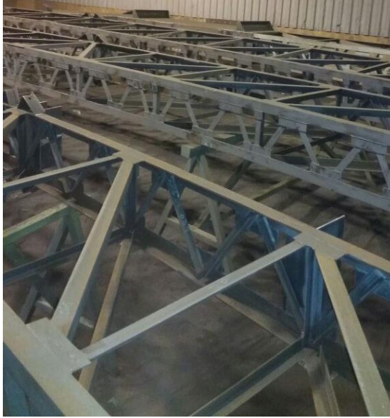
Figura 70. Limpieza superficial SSPC-SP 6
