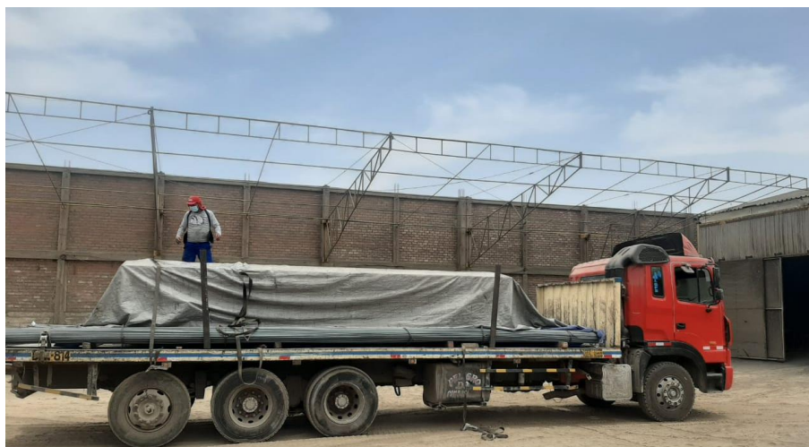
Figura 41. Recepción del material
