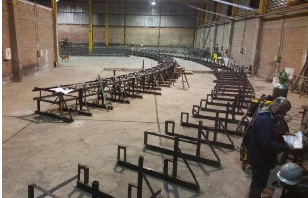
Figura 51. Armado de estructura
