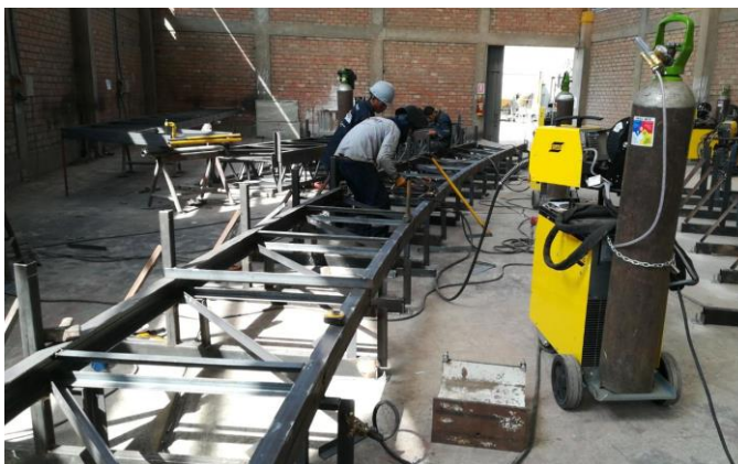
Figura 52. Apuntalado de estructura
