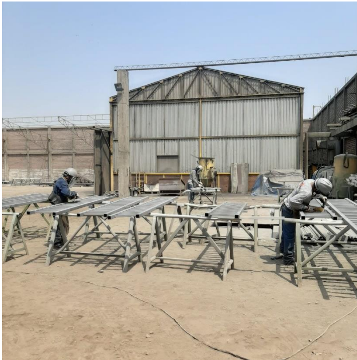
Figura 69. Limpieza mecánica de estructuras
