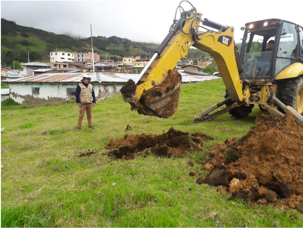
Figura 3 Excavación de la calicata C-11.
