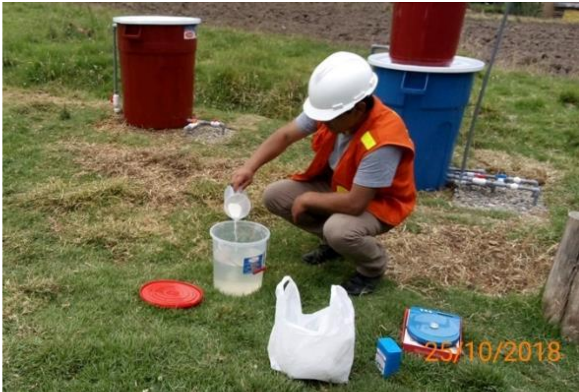
Figura 38. Cloración por goteo con flotador.
