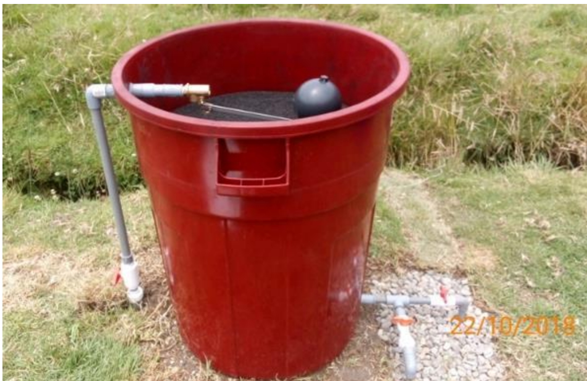
Figura 35. Instalación del filtro de carbón activado.
