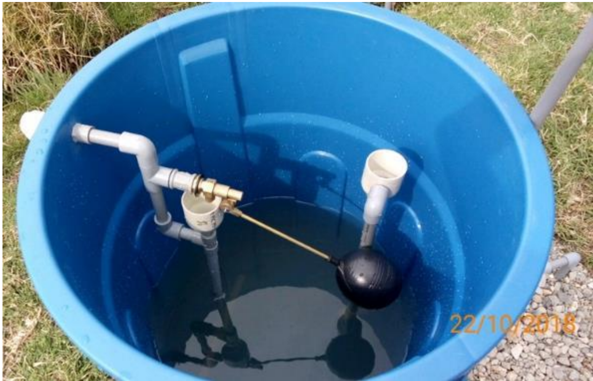
Figura 36. Instalación del tanque de almacenamiento.
