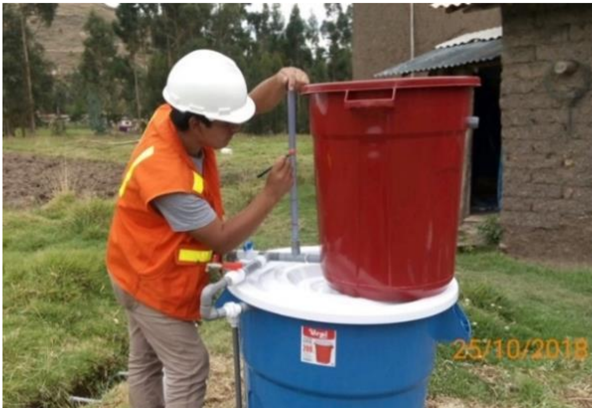
Figura 37. Graduación del tubo visor del tanque dosador.
