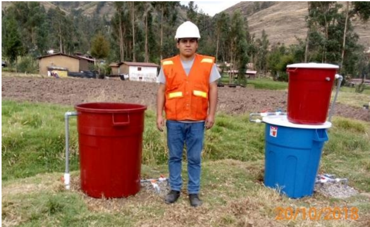
Figura 34. Sistema de tratamiento convencional para agua de consumo humano.
