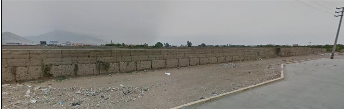
Figura 16: Vista lateral desde la calle S/N.
