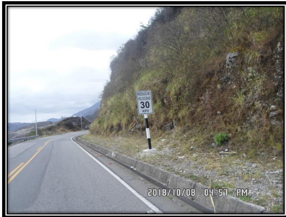
Figura 12. No existe la visibilidad del vehículo que viene en sentido contrario; aumentando la probabilidad de accidentes
