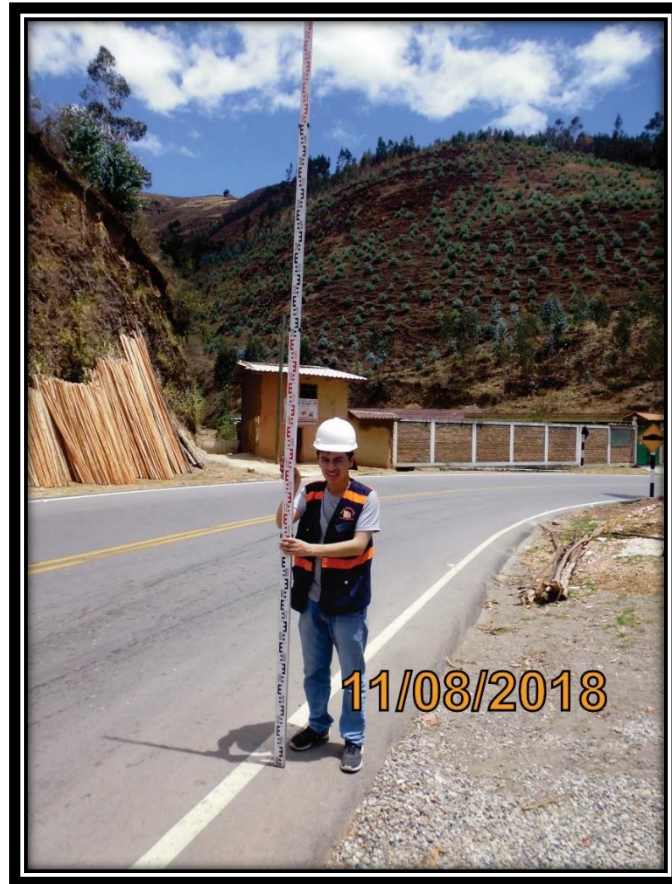
Figura 36. Verificación de pendientes
