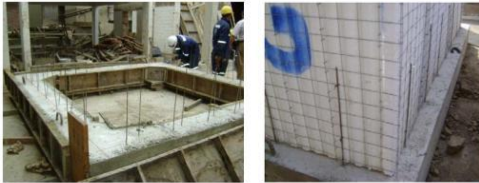
Figura 10. Espigas para la conexión de cimentación y muros. San Bartolomé, 2009. Informe Evaluación Experimental Del Sistema Constructivo “M2”
