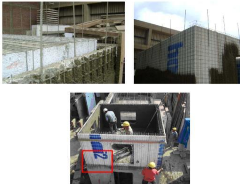
Figura 11. Espigas para conectar y dar continuidad a los muros. San Bartolomé, 2009. Informe Evaluación Experimental Del Sistema Constructivo “M2”
