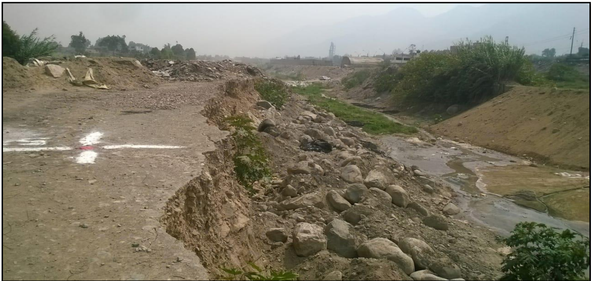
Figura N°: 25 Vista panorámica donde se observa el derrumbe de borde del río. Fuente propia
