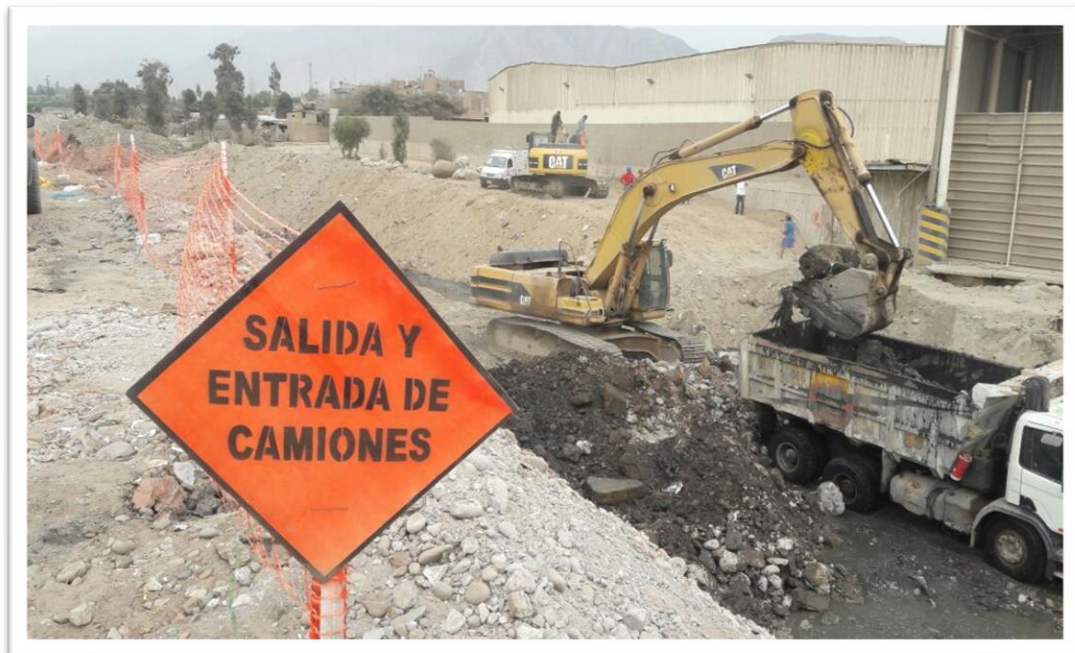
Figura 51. Eliminación de material contaminado carguío con excavadora y volquetes de 15 m 3 .
