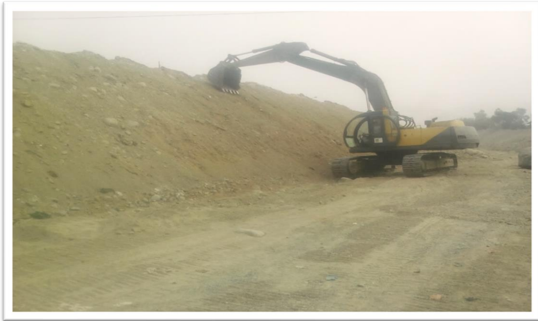
Figura 52 Perfilado del talud y conformación de borde desde la progresiva 0+000 al 0+860
