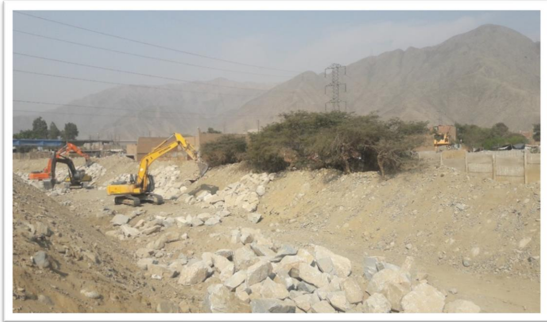
Figura 56. Enrocado en el margen izquierdo en la curva N°09 teniendo 120 ml desde la progresiva Km 1+290 al km 1+410
