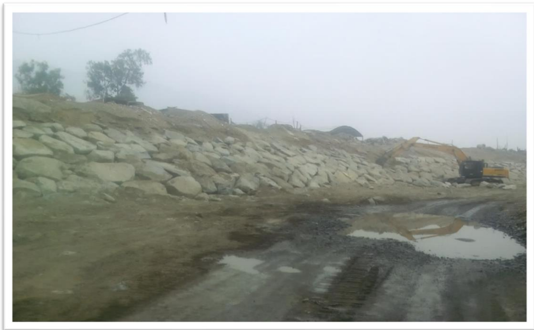
Figura 53. Se observa la colocación del enrocado en las progresivas 2+450 al 2+560
