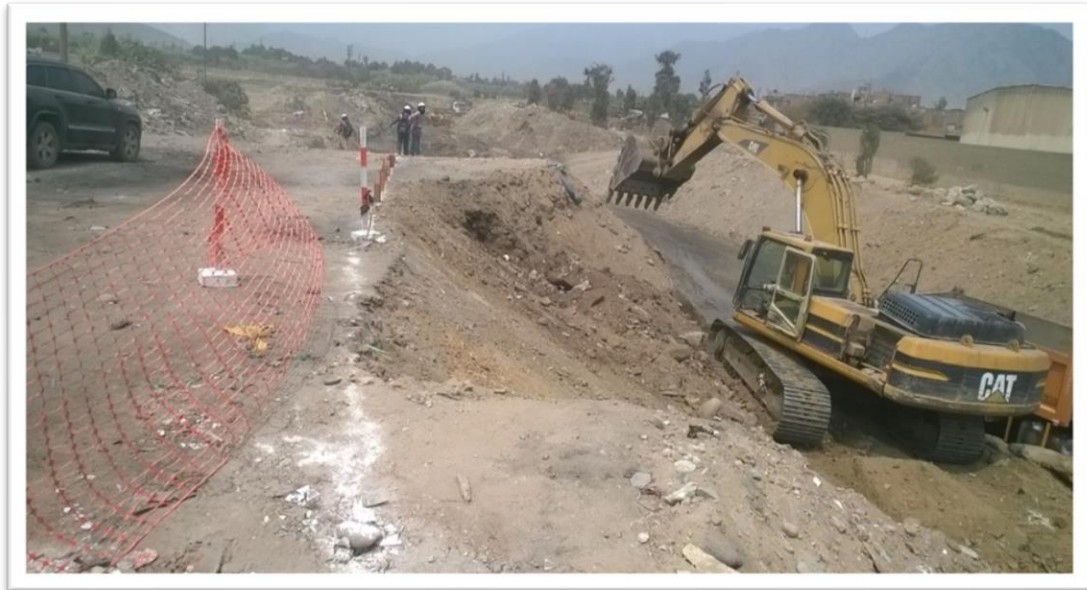
Figura 50. Trazo de topografía Corte y perfilamiento de talud según sección típica del proyecto, con cachacos y mallas de seguridad.
