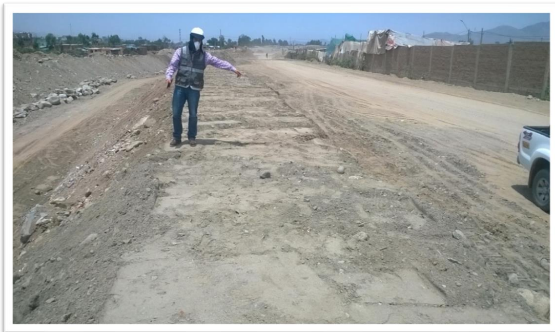
Figura 57. Conformación de bordes en margen derecho del cauce del Río Huaycoloro
