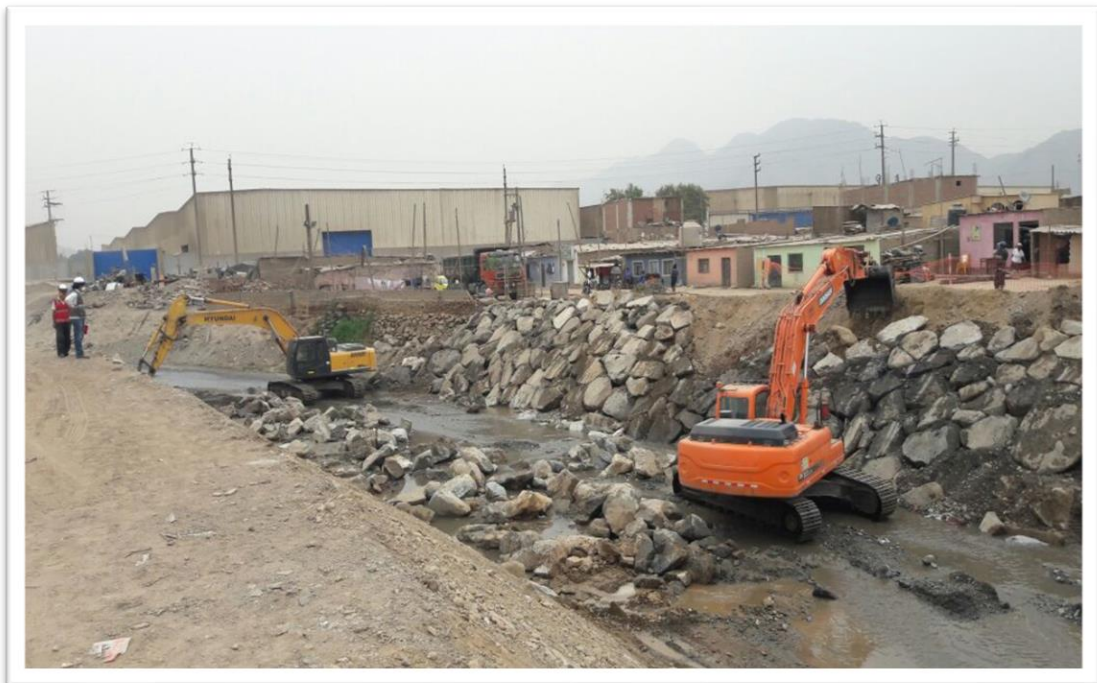
Figura 59. Enrocado final en el último tramo desde la progresiva 4.+540 al 4+580.
