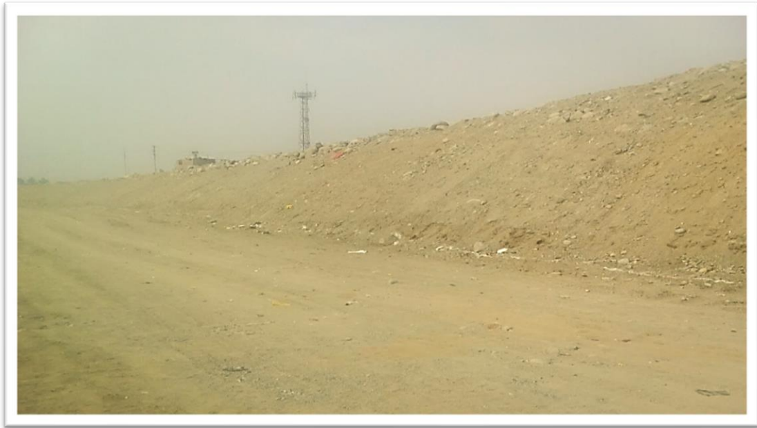
Figura 54. Vista panorámica de conformación de talud desde la progresiva 0.+0.00 al 0+860
