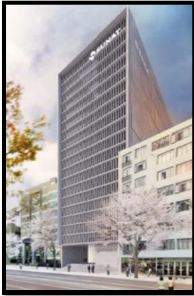
Figura 16: Edificio Nueva sede SUNAT. Fuente: Talavera, s.f.
