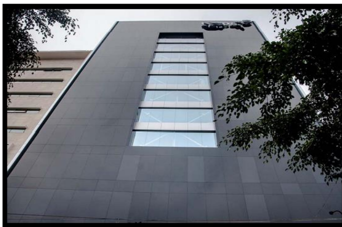
Figura 13: Edificio Gerpal. Fuente: Talavera, s.f.
