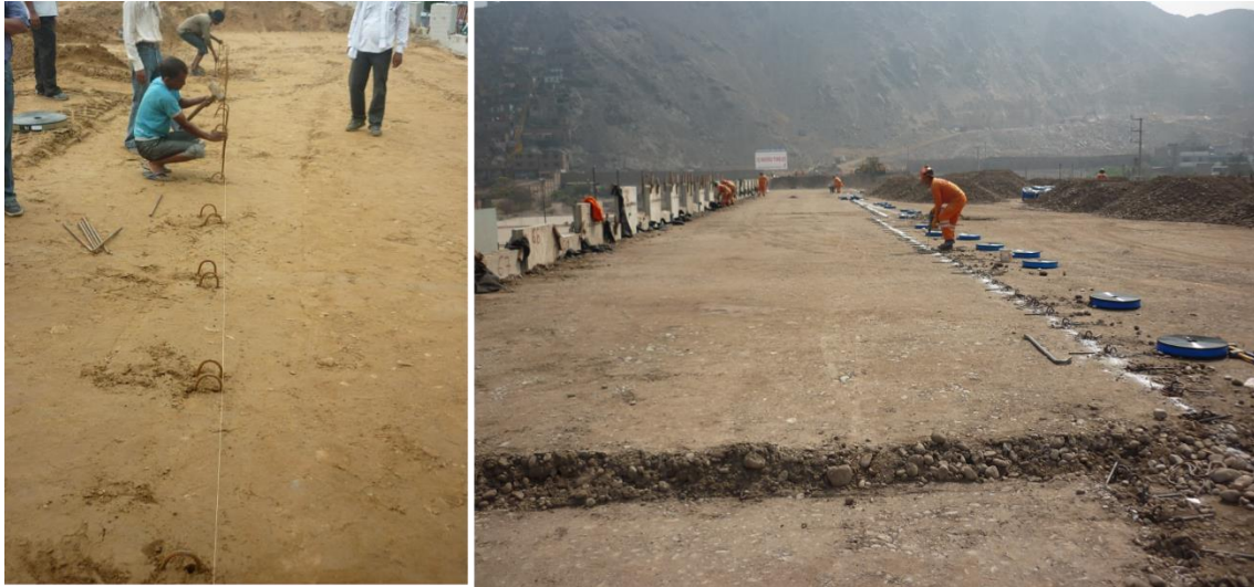
Figura 67. Colocación de anclajes posteriores
