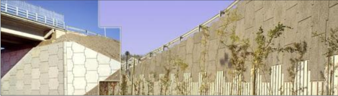
Figura 8. Muro de Tierra Reforzada Chile
