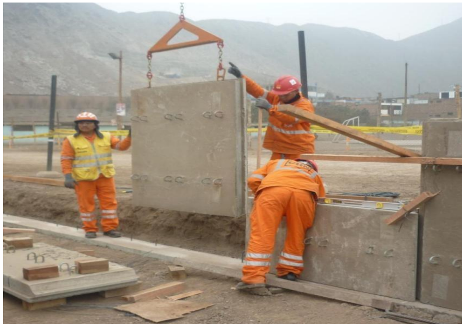
Figura 60. Colocación de los primeros paneles
