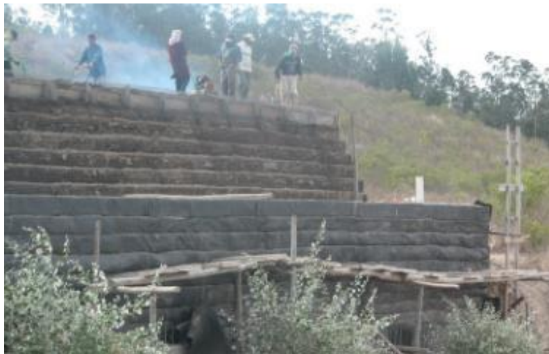
Figura 6. Muro Vegetal con Tierra Armada usando la Tecnología Geosintética (Geotextil y Geomalla), sector Tanda Quito – Ecuador
