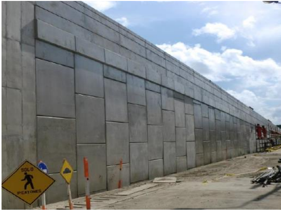
Figura 44. Muro de Contención con el Sistema MacForce
