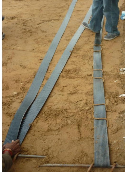
Figura 69. Colocación de las cintas Paraweb
