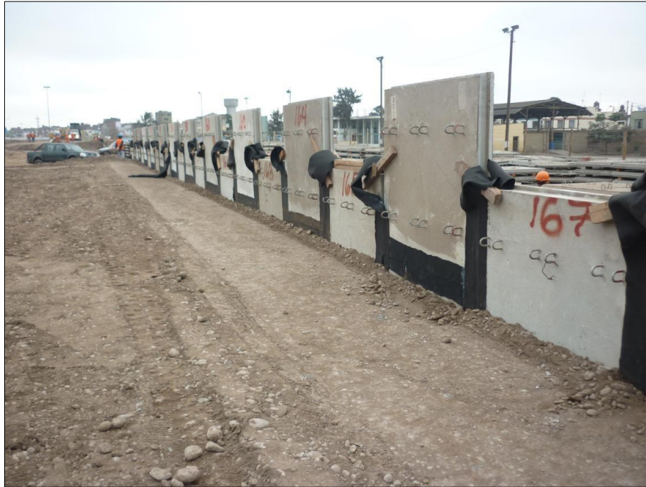
Figura 64. Colocación del Geotextil
