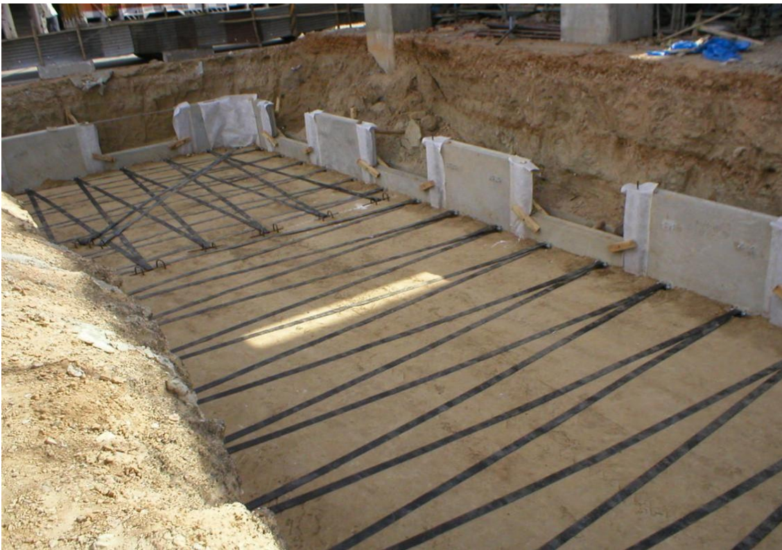
Figura 72. Colocación de las cintas ParaWeb Fuente: Maccaferri
