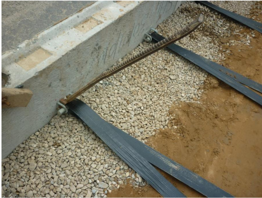
Figura 71. Colocación de las cintas Paraweb Fuente: Maccaferri
