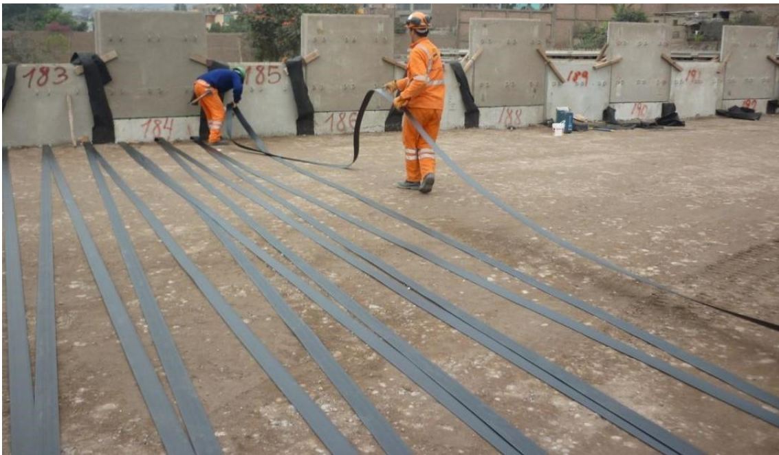
Figura 68. Colocación de las cintas Paraweb
