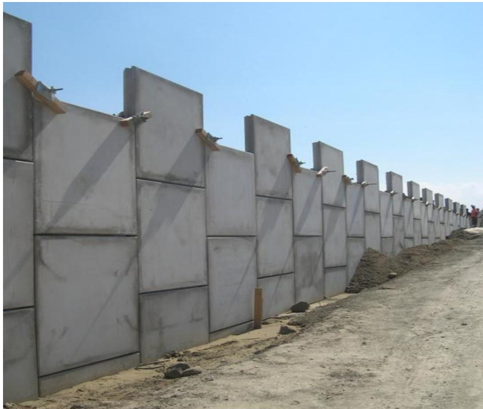
Figura 74. Colocación Paneles Superiores Fuente: Maccaferri
