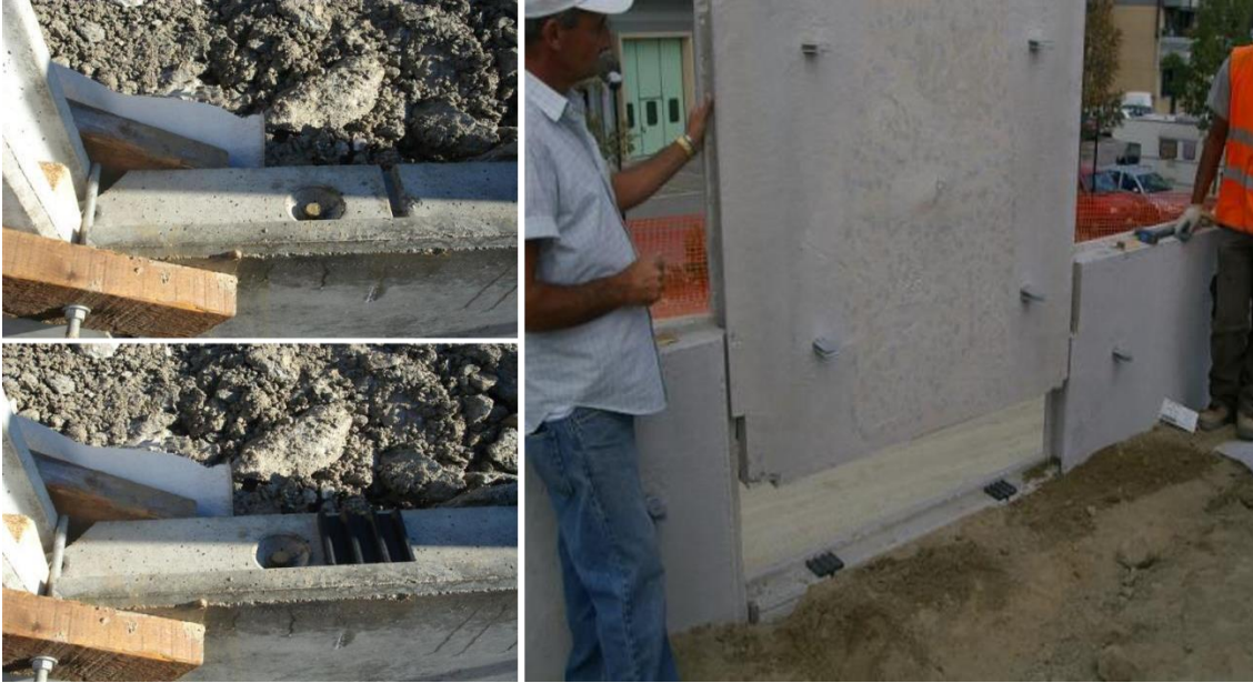
Figura 73. Colocación de apoyos Fuente: Maccaferri
