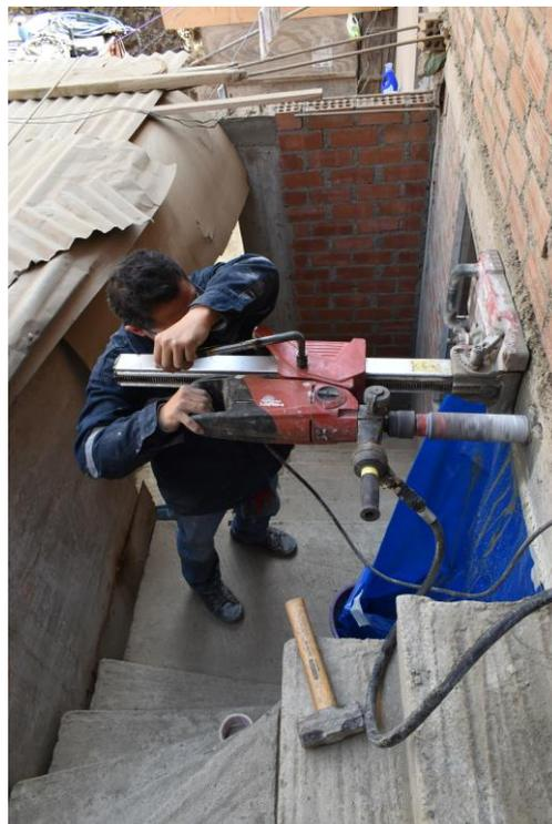
Figura 7. Proceso de extracción del núcleo.
