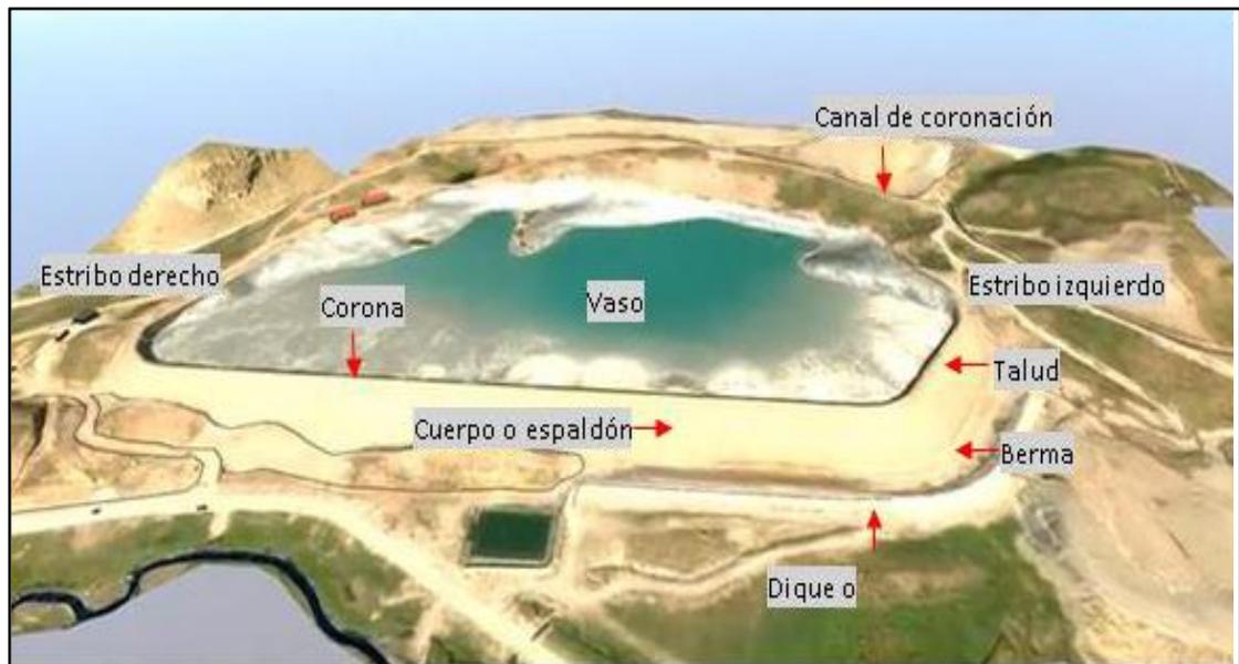
*Figura 01. Diseño de presa de relaves*
