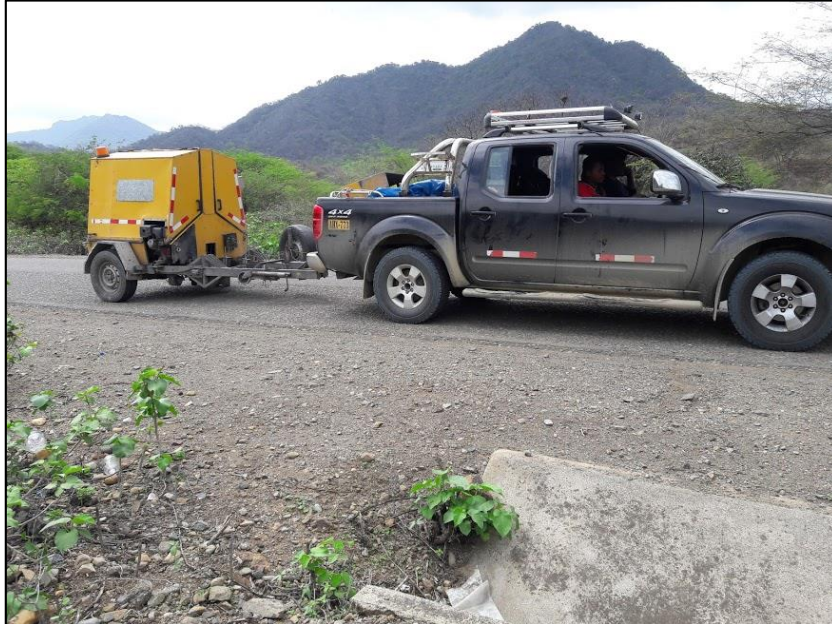
Figura 19 Trabajos de evaluación estructural mediante el deflectómetro de impacto FWD en el tramo Paimas – Pampa de Lobos para la empresa IHACSAC Fuente: Elaboración propia
