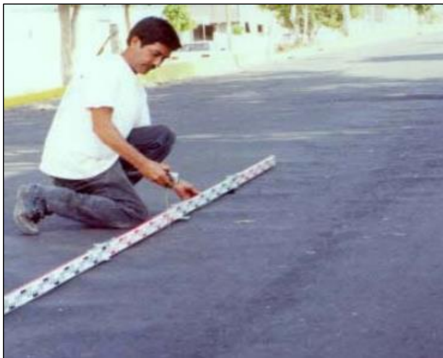
Figura 43 Imagen con falla de corrugación en nivel de severidad media Fuente: Universidad Nacional de Ingeniería de Nicaragua (2010)
