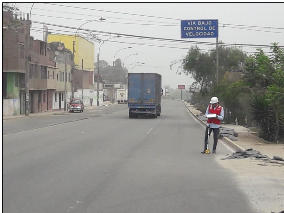
Figura 77 Trabajos de recolección de información en el tramo 01. Carril izquierdo. Fuente: Elaboración propia
