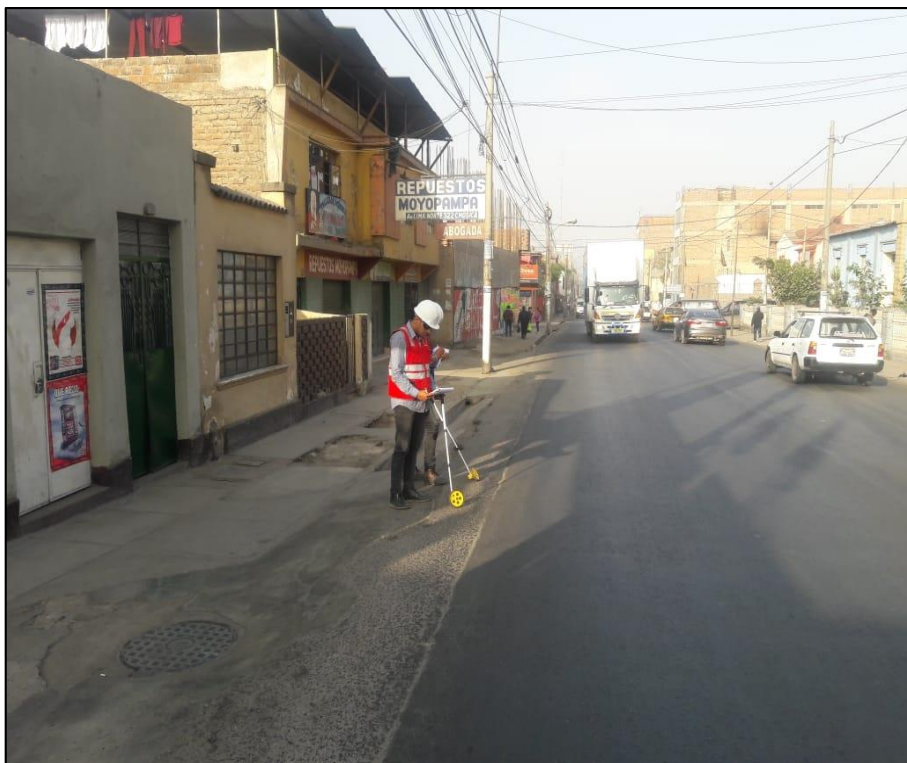
Figura 83 Trabajos de recolección de información en el tramo 03. Fuente: Elaboración propia
