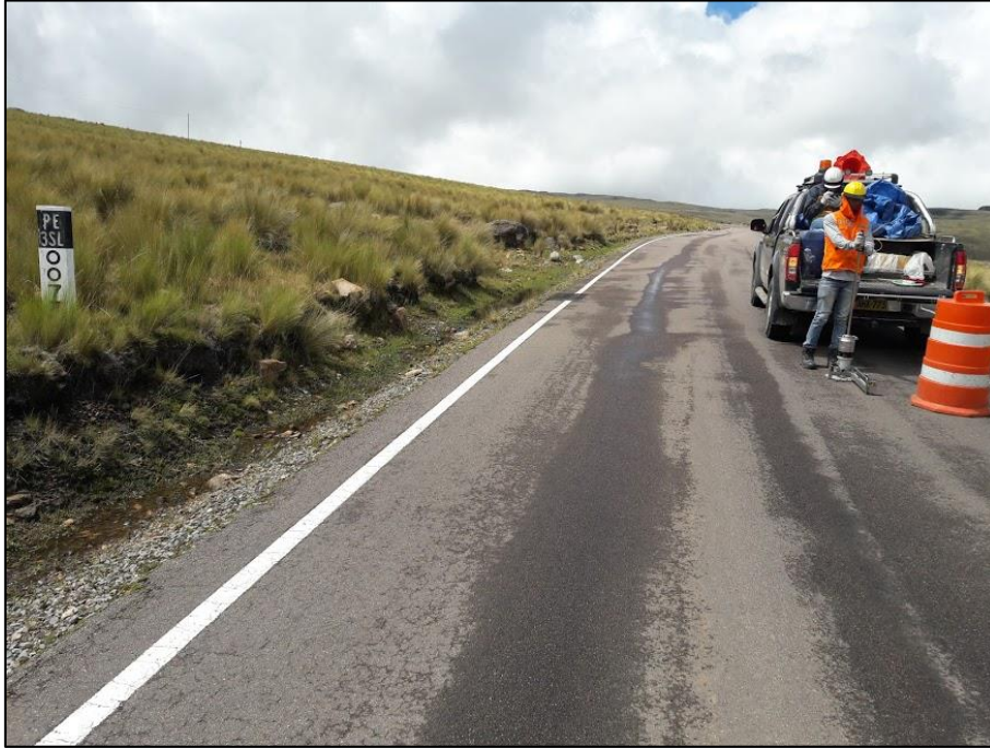
Figura 23 Trabajos de deflectometría Liviana en el tramo Ayacucho – Desvió Ocos para la empresa Geoconsult Ingenieros Fuente: Elaboración propia
