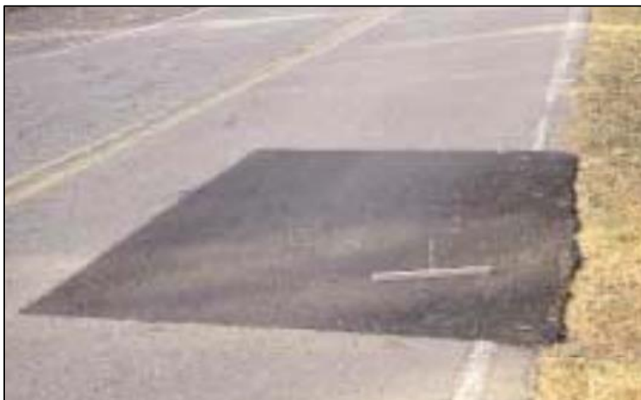
Figura 49 Falla tipo parcheo en nivel de severidad alta. Fuente: Universidad Nacional de Ingeniería de Nicaragua (2010)
