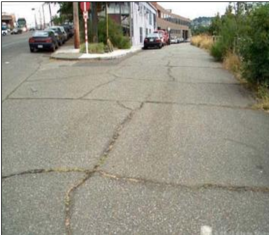
Figura 45 Falla de reflexión de junta en nivel de severidad media Fuente: Universidad Nacional de Ingeniería de Nicaragua (2010)
