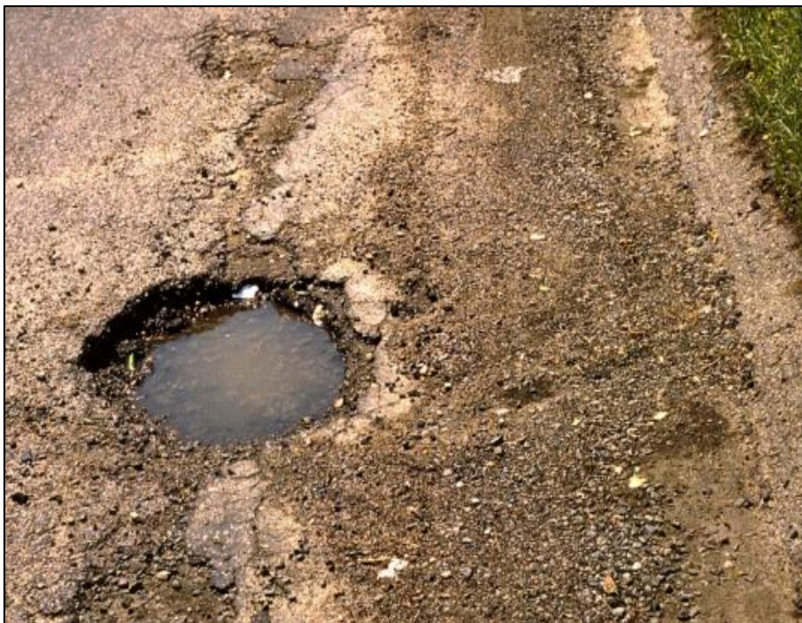
Figura 52 Falla tipo huevo en nivel de severidad alta. Fuente: Universidad Nacional de Ingeniería de Nicaragua (2010)
