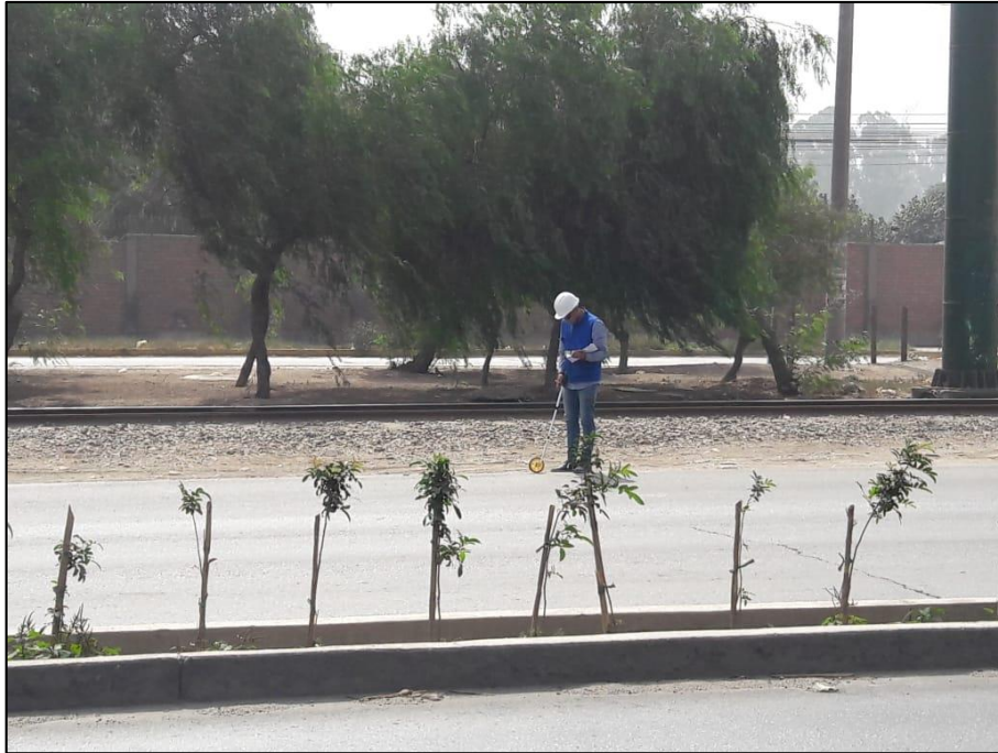
Figura 75 Trabajos de identificación de las unidades de muestra del tramo 01 Calzada Derecha. Fuente: Elaboración propia
