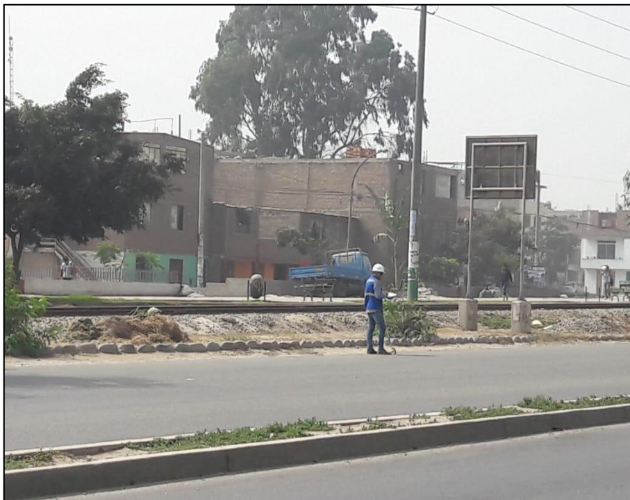
Figura 79 Trabajos de recolección de información en el tramo 01. Carril izquierdo. Fuente: Elaboración propia
