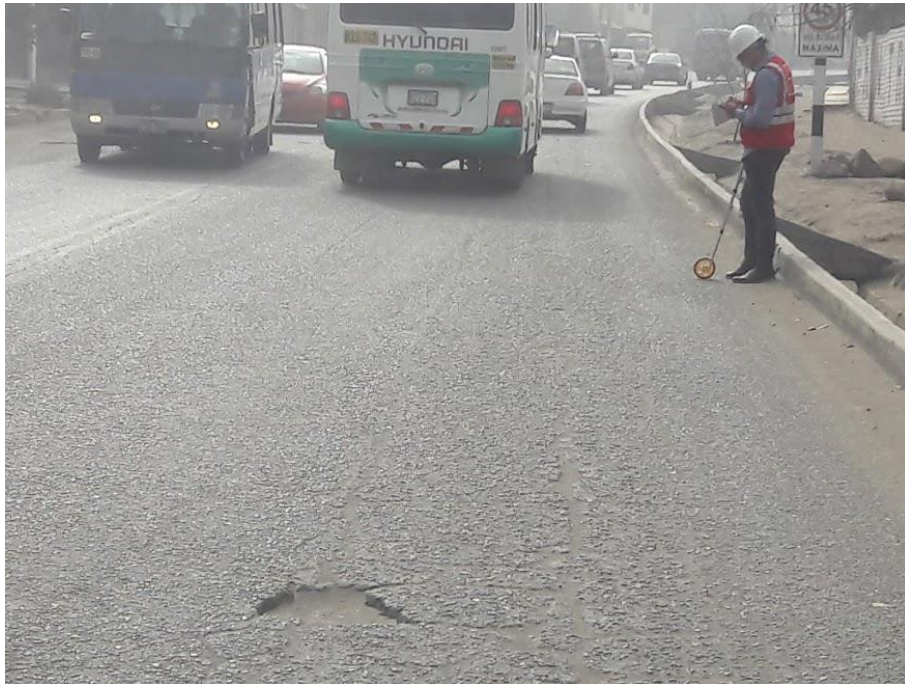
Figura 64 Se observa que la vía se encuentra con alto tránsito, de esta manera, dificulta el trabajo de recolección de datos. Fuente: Elaboración propia
