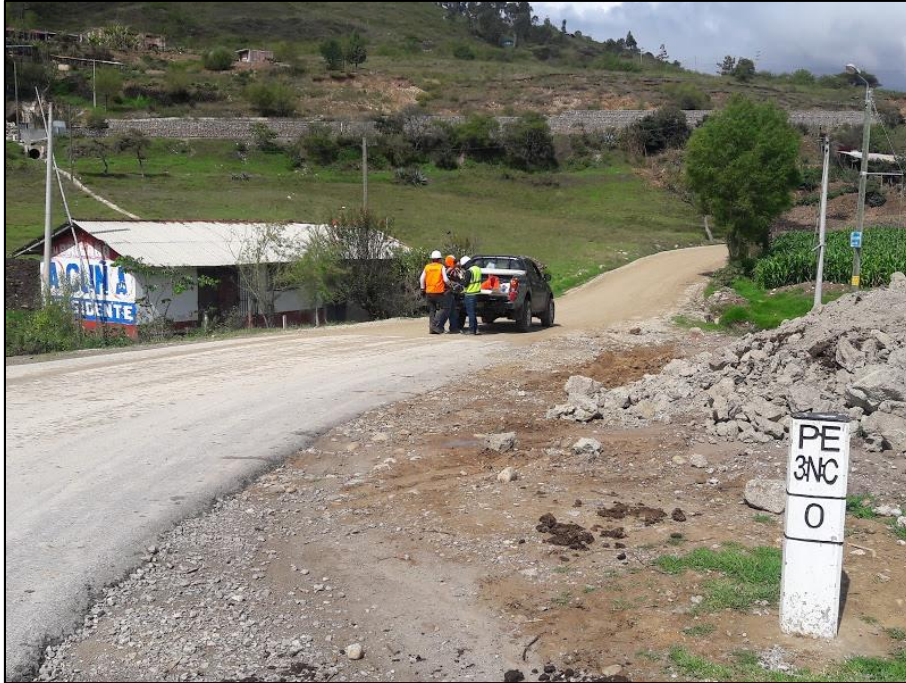
Figura 13 Trabajos de deflectometría Liviana en el tramo Chota – Cutervo para Geoconsult Fuente: Elaboración propia
