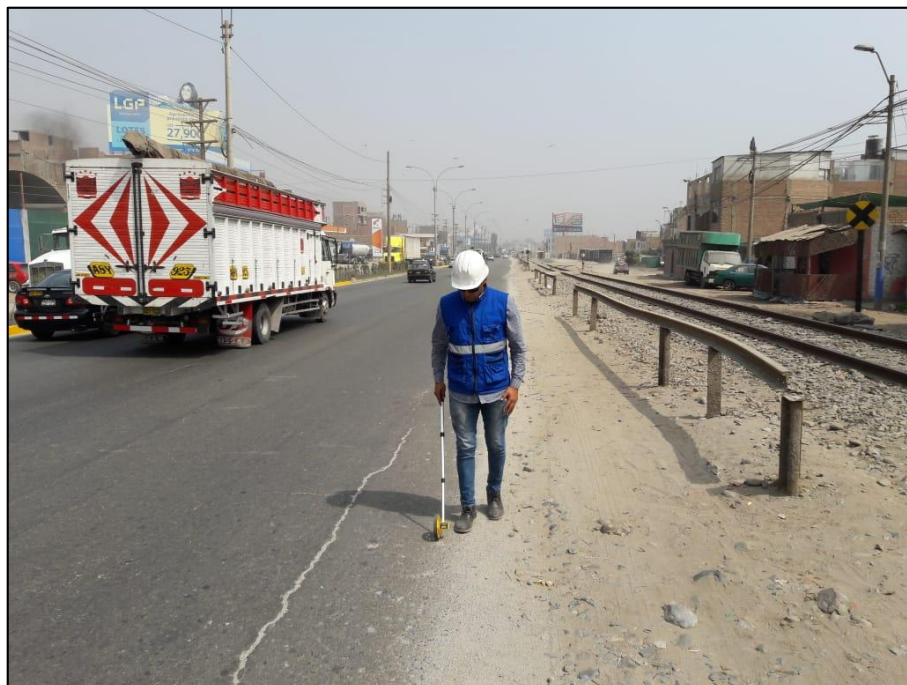
Figura 74 Trabajos de identificación de las unidades de muestra del tramo 01 Calzada Izquierda. Fuente: Elaboración propia.
