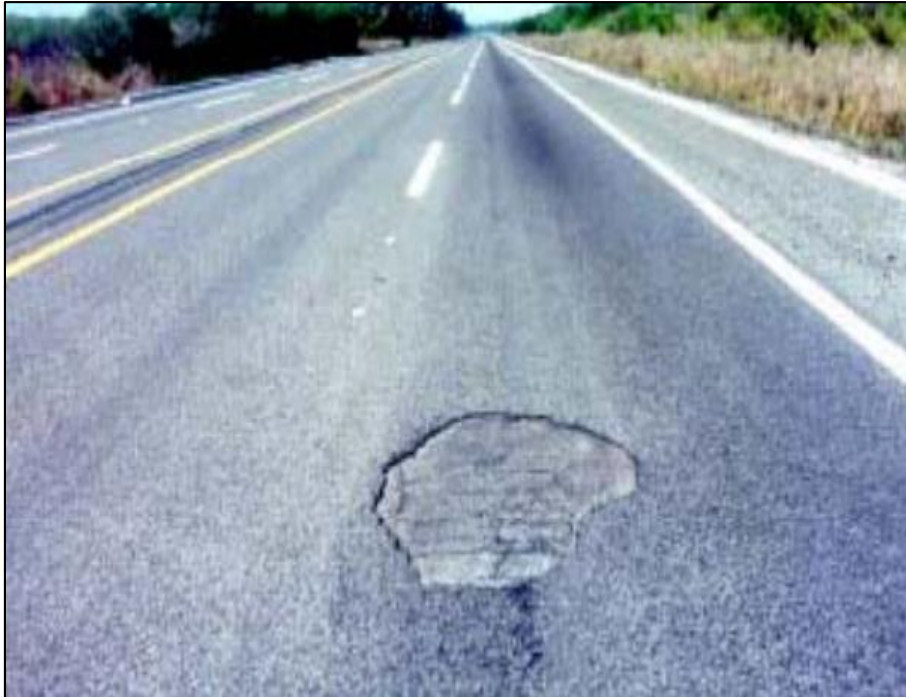
Figura 51 Falla tipo Huevo en nivel de severidad media. Fuente: Universidad Nacional de Ingeniería de Nicaragua (2010)
