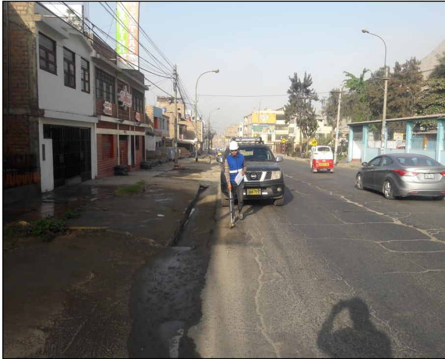
Figura 82 Trabajos de recolección de información en el tramo 03. Fuente: Elaboración propia
