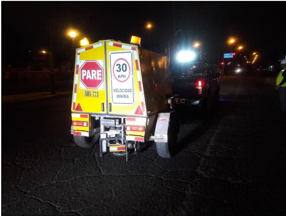
Figura 30 Trabajos de Evaluación estructural mediante el deflectómetro de impacto FWD en la Av. Santa Rosa Callao Fuente: Elaboración propia
