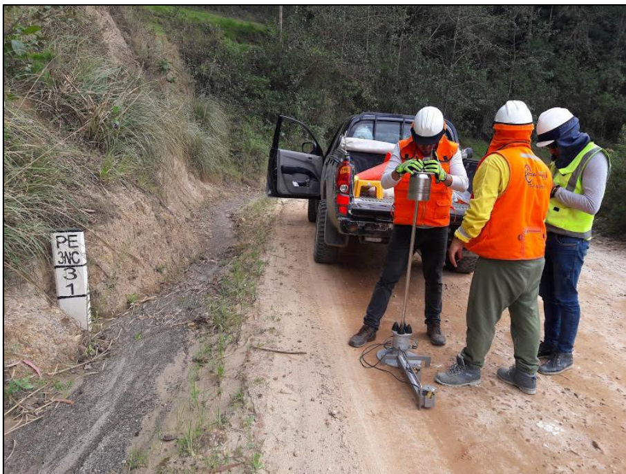
Figura 14 Trabajos de deflectometría Liviana en el tramo Puente Chota – Cutervo para Geoconsult Fuente: Elaboración propia
