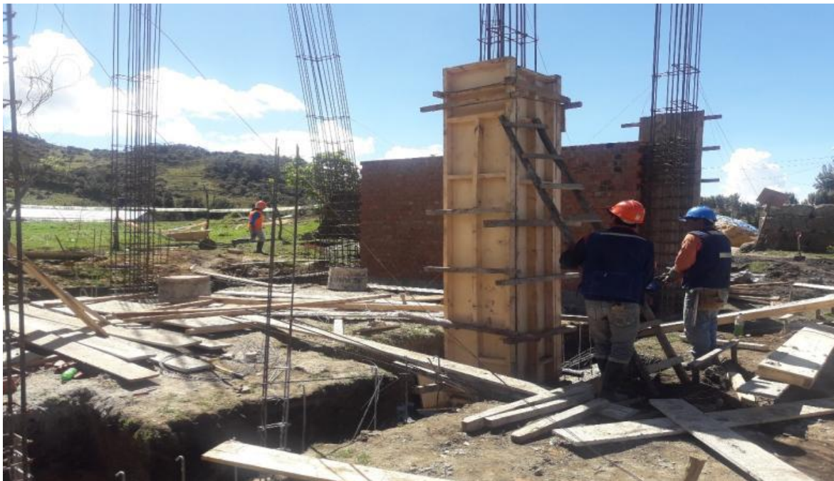
Fotografía 10: Habilitación de madera para encofrado
