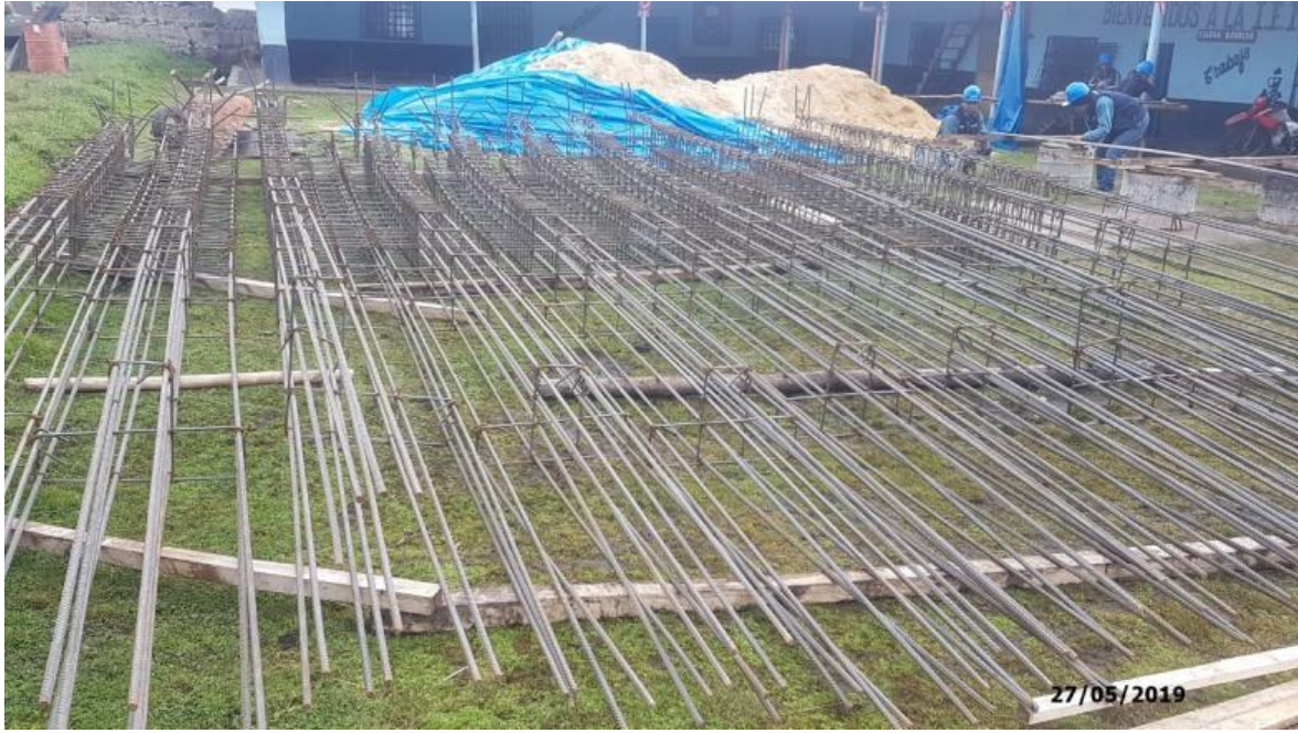
Fotografía 7: Habilitación de acero para columnas
