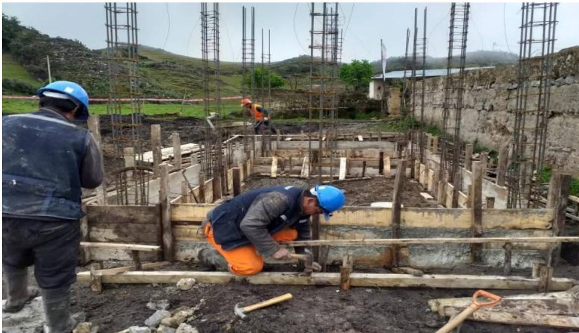
Fotografía 4: Tesista verificando la habilitación de madera para encofrado
