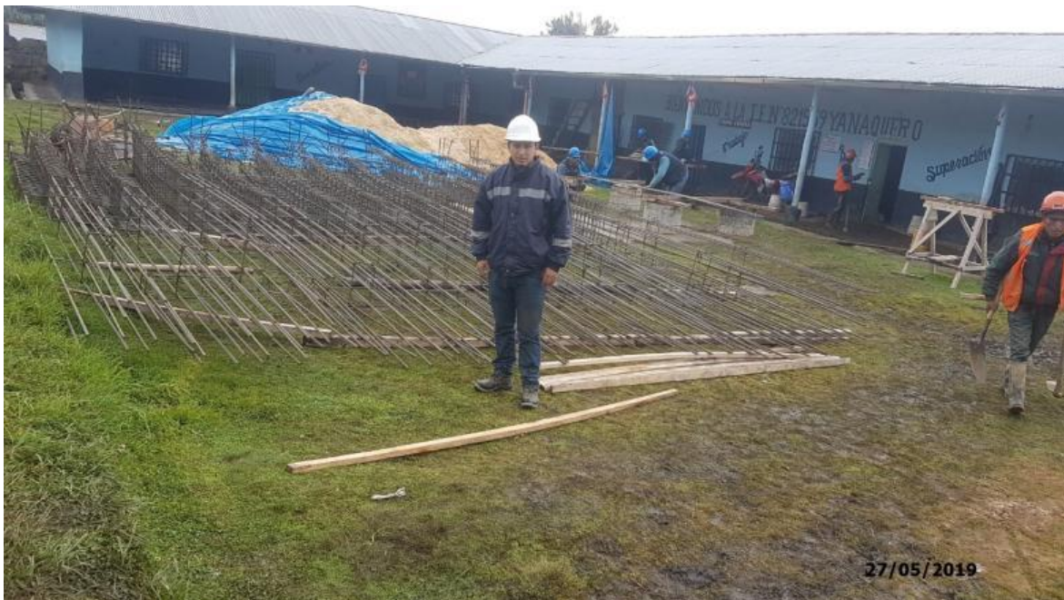
Fotografía 6: Tesista observando la habilitación de acero
