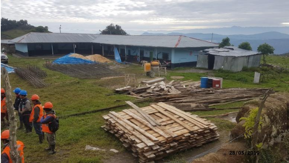
Fotografía 5: Ubicación de acero y madera
