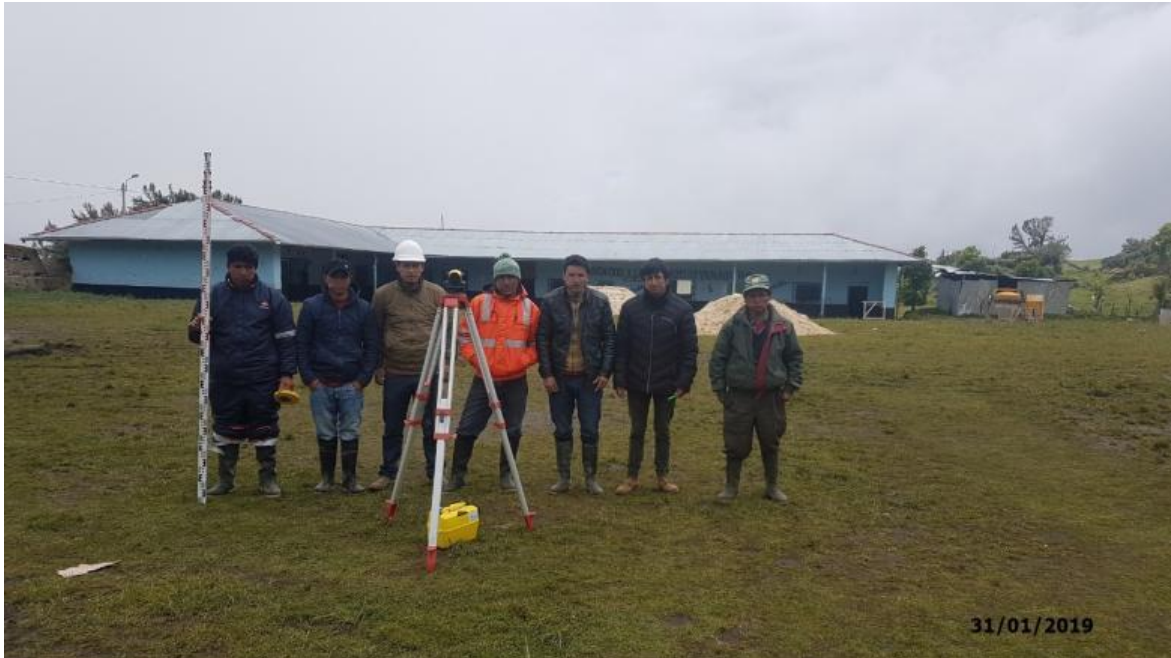
Fotografía 1: Vista panorámica del proyecto
