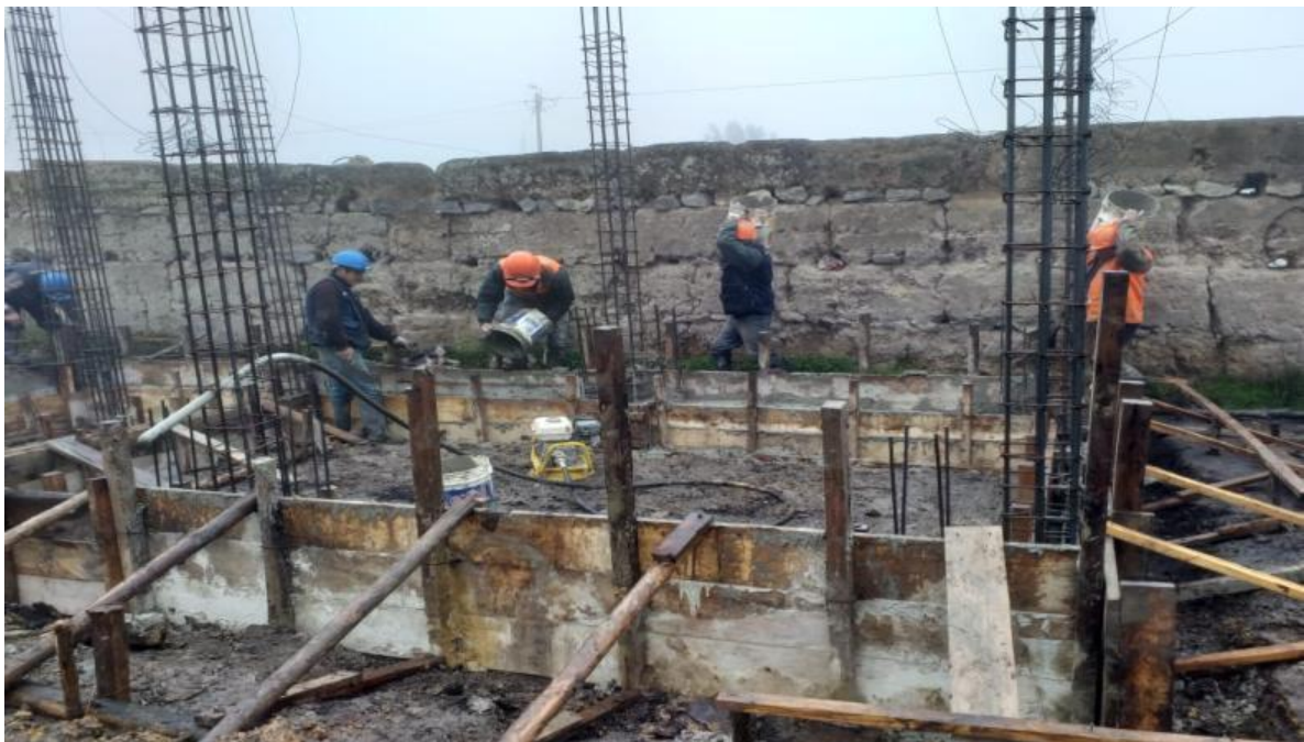
Fotografía 8 Habilitación de concreto
