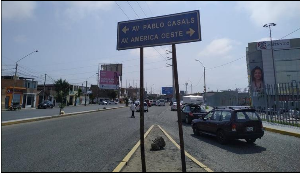
Figura 38. Señal Informativa de Dirección indicando hacia las Avenidas “Pablo Casals y América Oeste”
