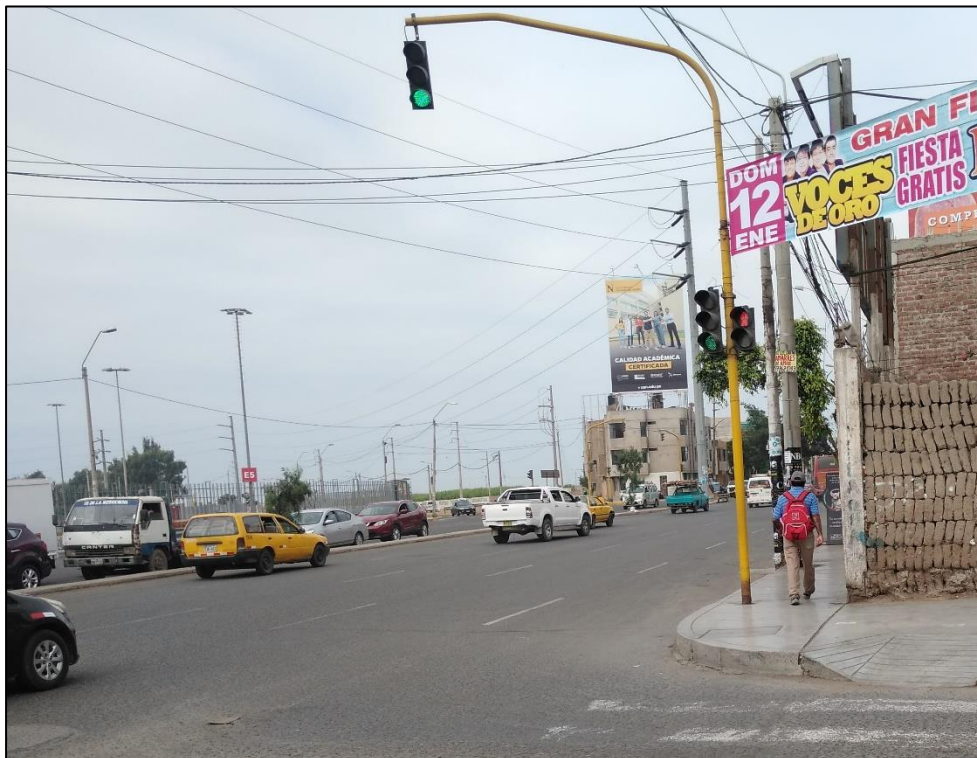
Figura 12. Semáforo vehicular y peatonal de tiempo fijo para el acceso N°2 en la Intersección N°01
