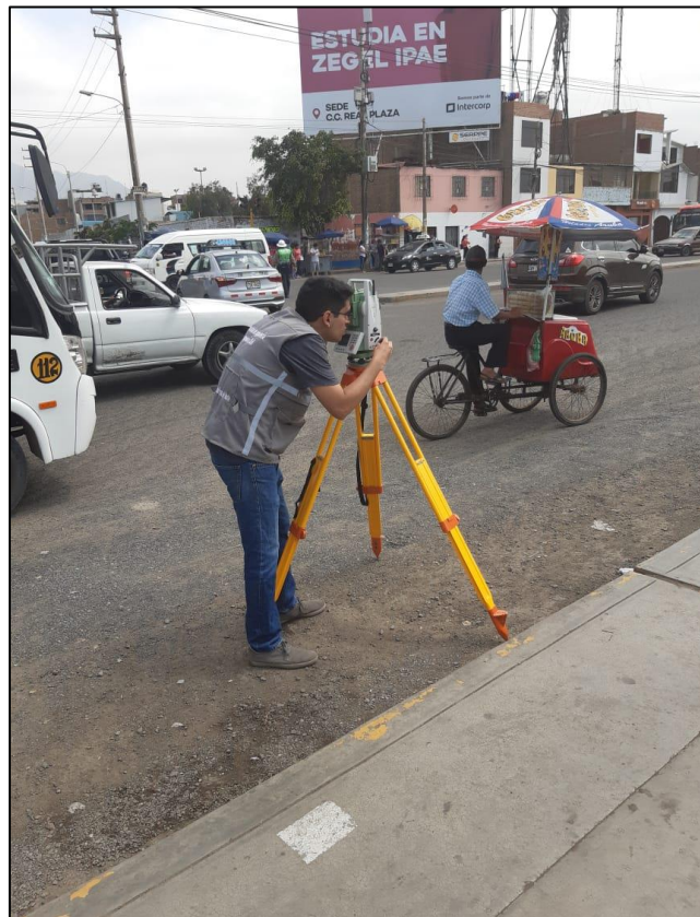
Figura 10. Estudio de Campo: Estudio Topográfico empleando Estación Total Leica TS09+
