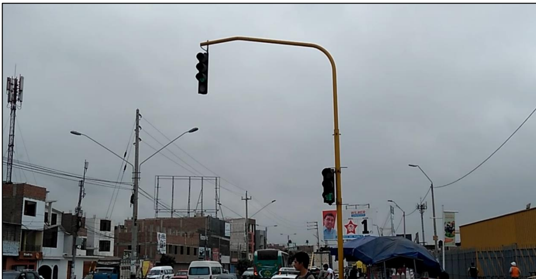
Figura 25. Semáforo S3 del acceso N°03 de la Intersección N°01
