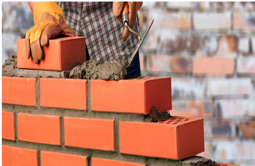
Figura 1.7. Uso de ladrillos de arcilla en la construcción de edificaciones.
