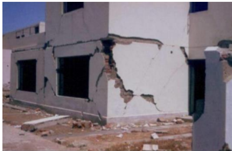
Figura 1.6. Viviendas de albañilería sin columnas.
