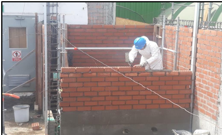
Figura 8.15. Asentado de muro (primer piso) con ladrillo King Kong 18 huecos Lark.
