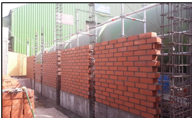
Figura 8.16. Asentado de muro (segundo piso) con ladrillo King Kong 18 huecos Lark.
