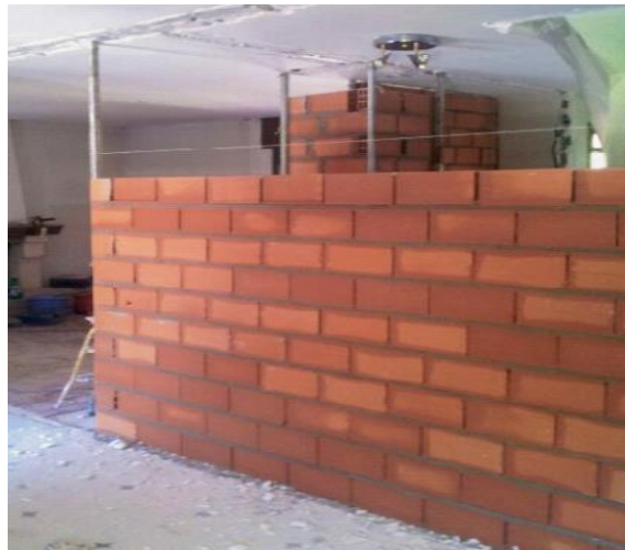
Figura 1.11. Muros no portantes de la albañilería
