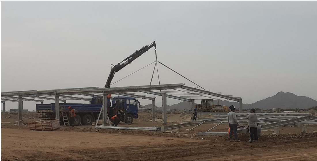
Figura 23 Armado e izaje de pórticos metálicos
