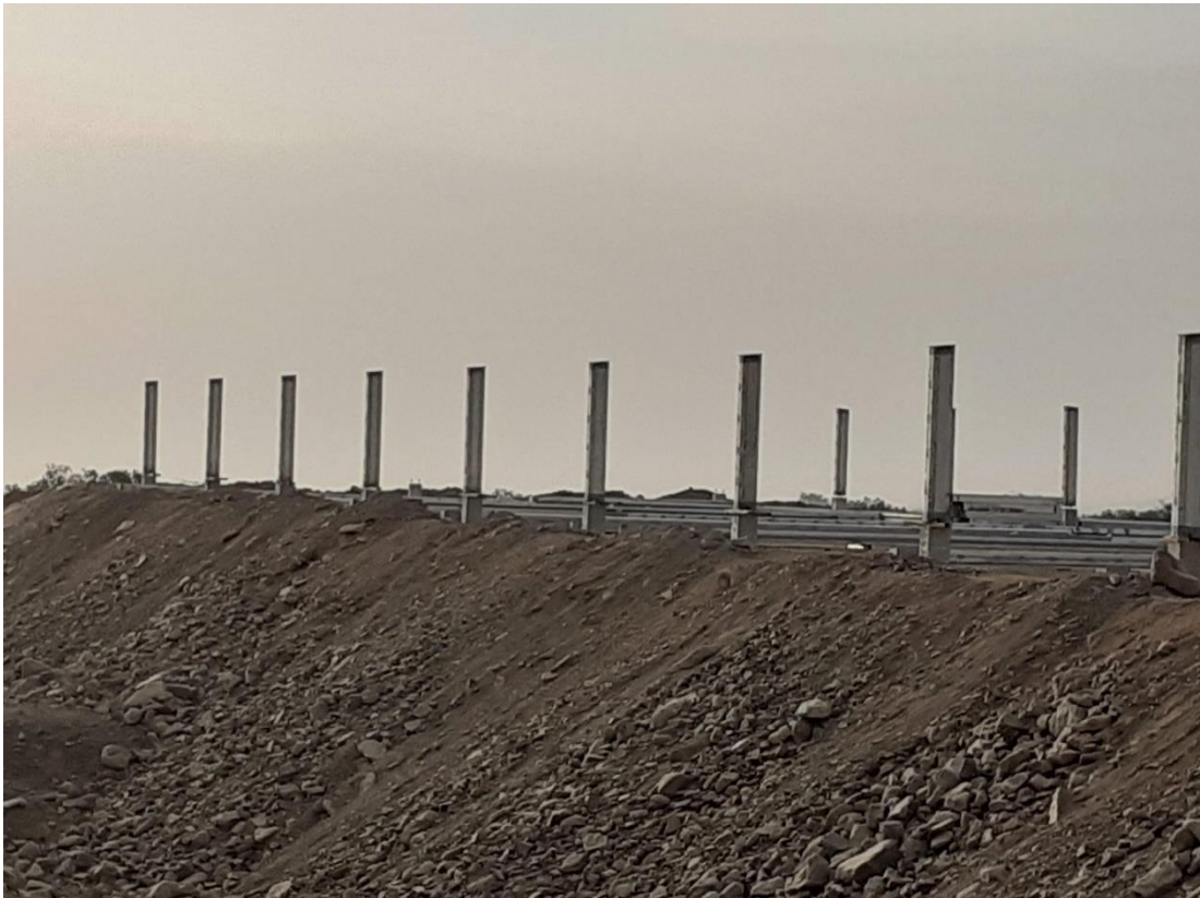
Figura 22 Instalación de parantes metálicos
