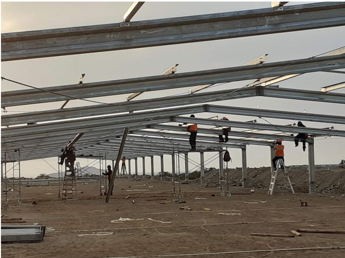
Figura 24 Instalación de correas de techo
