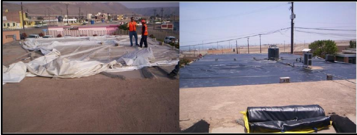
Figura 8. Impermeabilización con Geomembrana PVC en Techos Southern Perú Ilo en Moquegua
