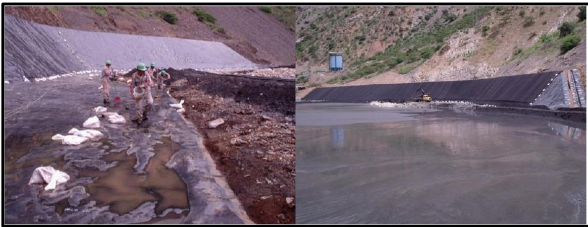
Figura 7. Relavera Norte Doe Run Peru S.A Unidad Cobriza Huancavelica
