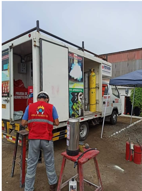
Figura 8. Venta y recarga de extintores. Fuente: Micheller Ingenieros SAC. (2021)
