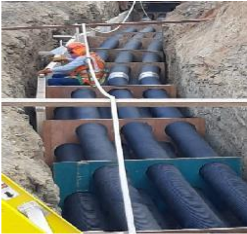
Fig. 26 Encofrado de CE20 a CE-21
