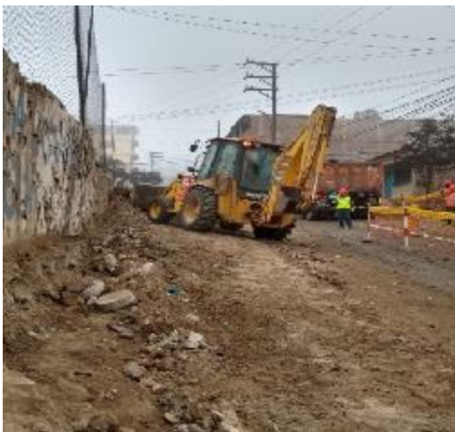
Fig. 24 Mejoramiento de Vía en tramo de CE-20 a CE-21
