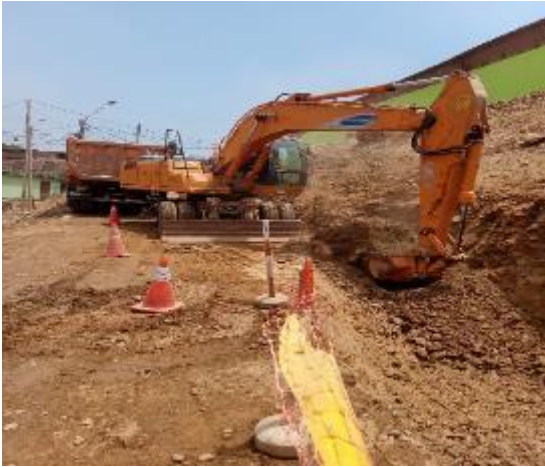
Fig. 14 Excavación con maquinaria
