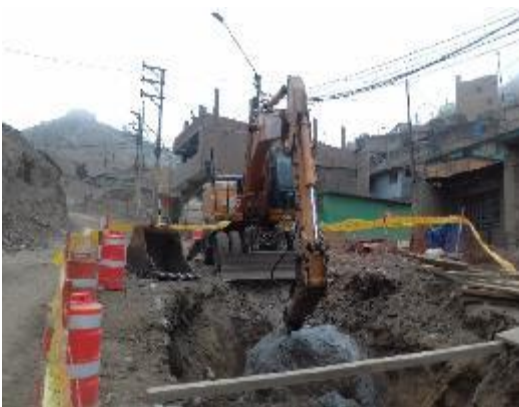
Fig. 18 Demolición de roca en CE-20
