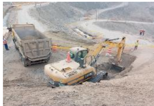
Fig. 5 Excavación con maquinaria en Av. Unión
