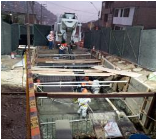
Fig. 22 Vaciado de Concreto en CE-20
