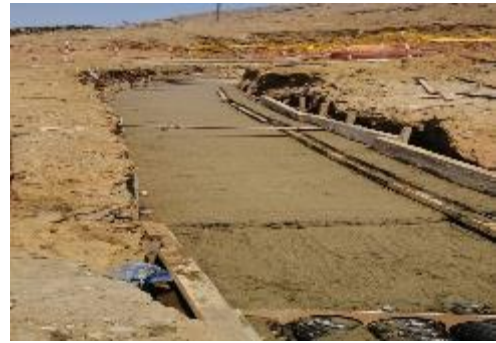
Fig. 7 Vaciado de concreto
