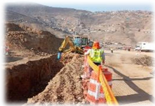
Fig. 6 Excavación de CE18 a CE19
