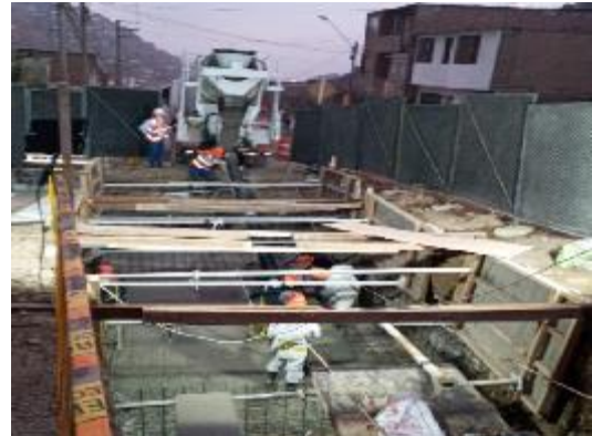
Fig. 29 Vaciado de concreto en CE-21
