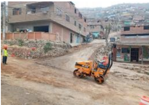
Fig. 8 Relleno y compactado de CE18 a CE19
