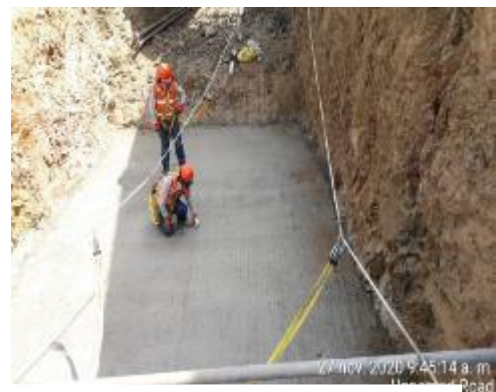
Fig. 11 Vaciado de concreto en CE-19 (Solado)
