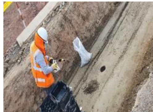
Fig. 9 Prueba de densidad de campo de CE18 a CE19
