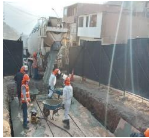
Fig. 23 Vaciado de Concreto en CE-20
