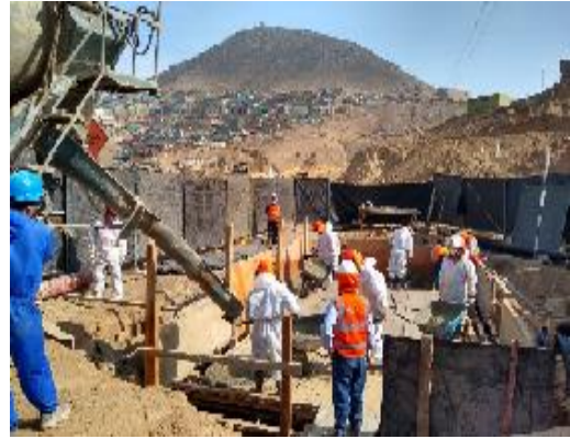
Fig. 2 Vaciado de concreto en Muros en Cámara 18
