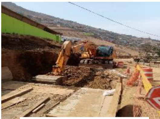
Fig. 10 Excavación con maquinaria
