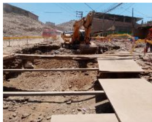
Fig. 19 Excavación con maquinaria en
