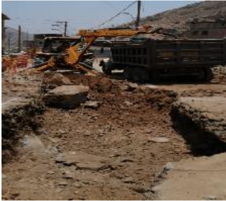
Fig. 1 Excavación con Maquinaria en Cámara 18
