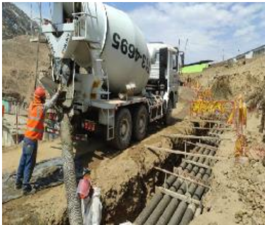
Fig. 16 Vaciado de concreto
