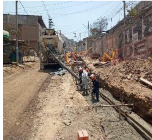
Fig. 27 Vaciado de concreto
