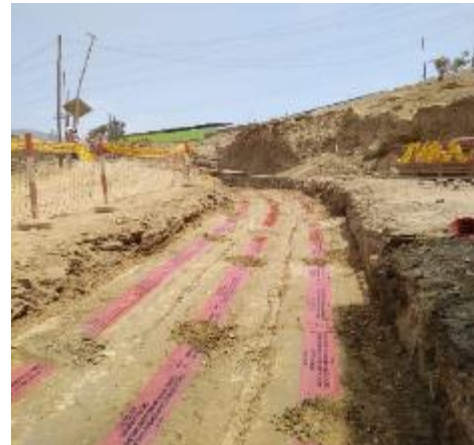
Fig. 17 Inst. de Cinta de Seguridad
