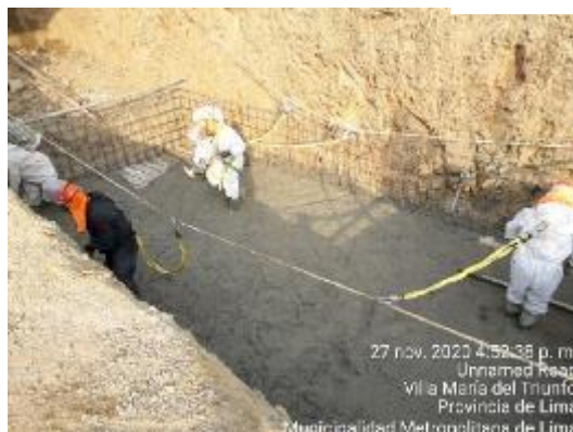
Fig. 12 Vaciado de concreto en CE-19
