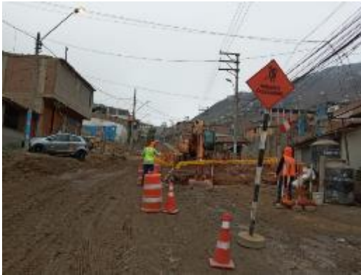
Fig. 28 Excavación con maquinaria en CE-21
