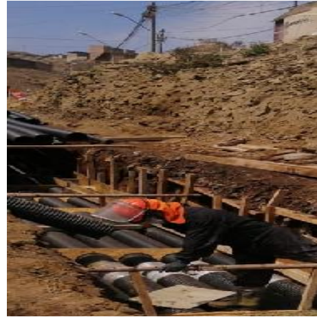
Fig. 15 Encofrado de Tuberías
