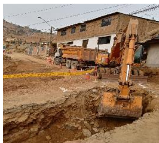
Fig. 25 Excavación con maquinaria de CE20 a CE21
