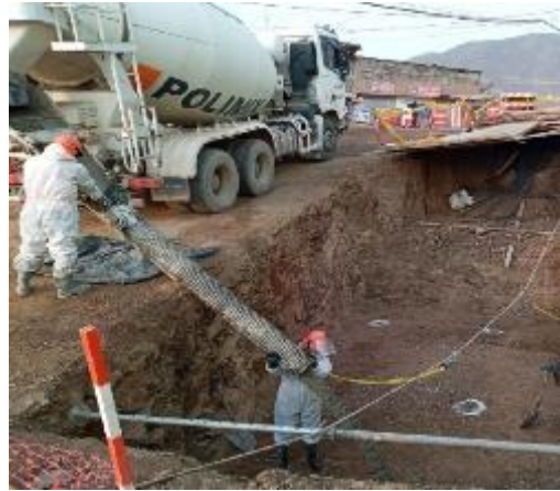
Fig. 21 Vaciado de Concreto en CE-20
