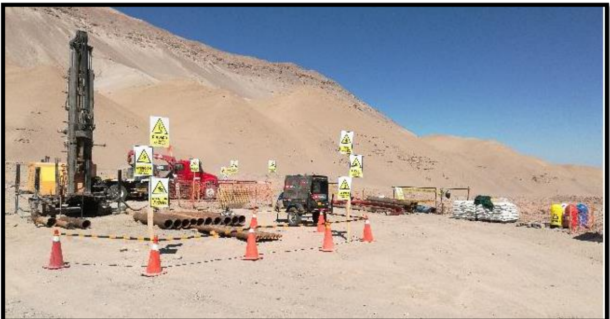
Obra en la empresa Aceros Arequipa - Pisco
