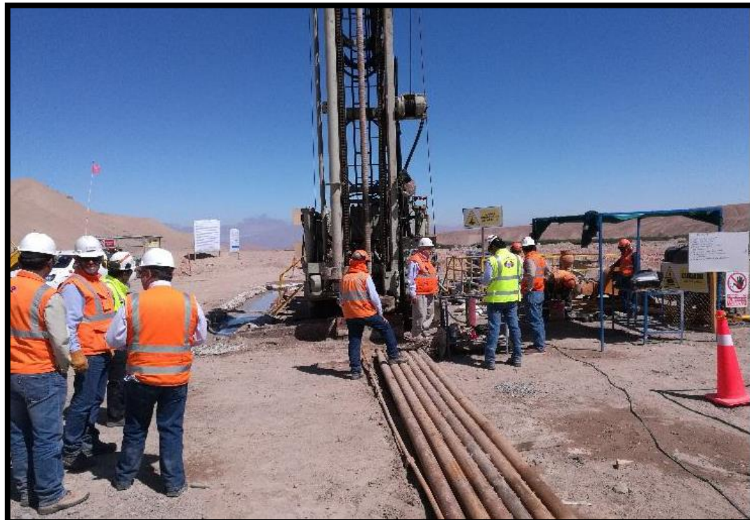
Visualización de los clientes sobre el avance en la obra en la empresa Aceros Arequipa – Pisco
