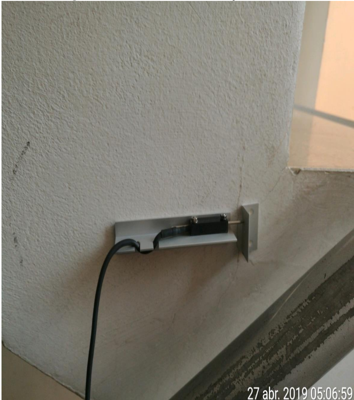
Fotografía 46: Fisura en Gradas de Escalera en 4 piso, Zona Común.
