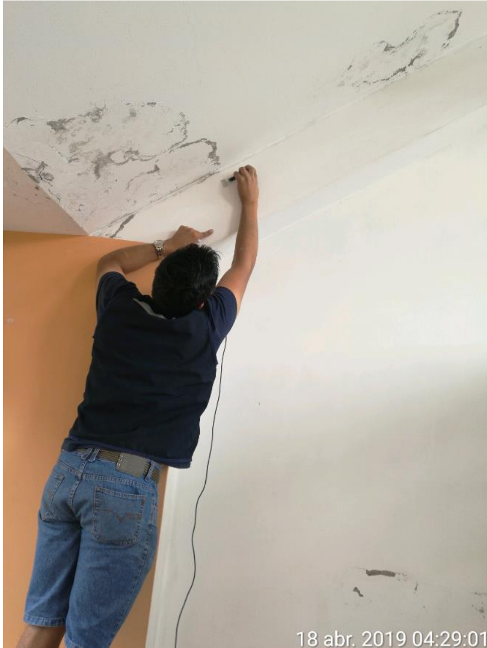
Fotografía 84: Colocado de censor en Viga de escalera.
