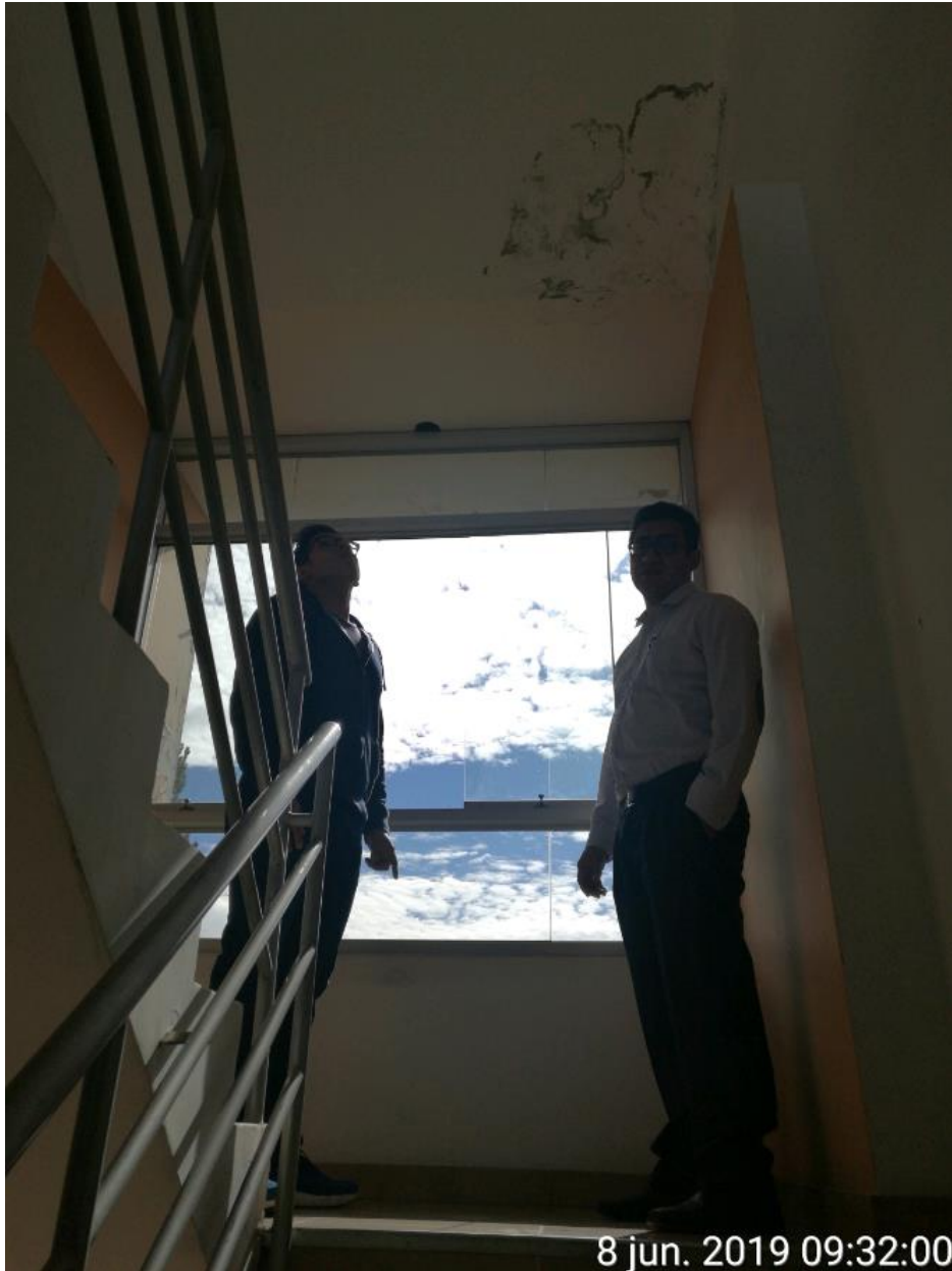
Fotografía 100: Inspección de Asesor en zona común de residencial.
