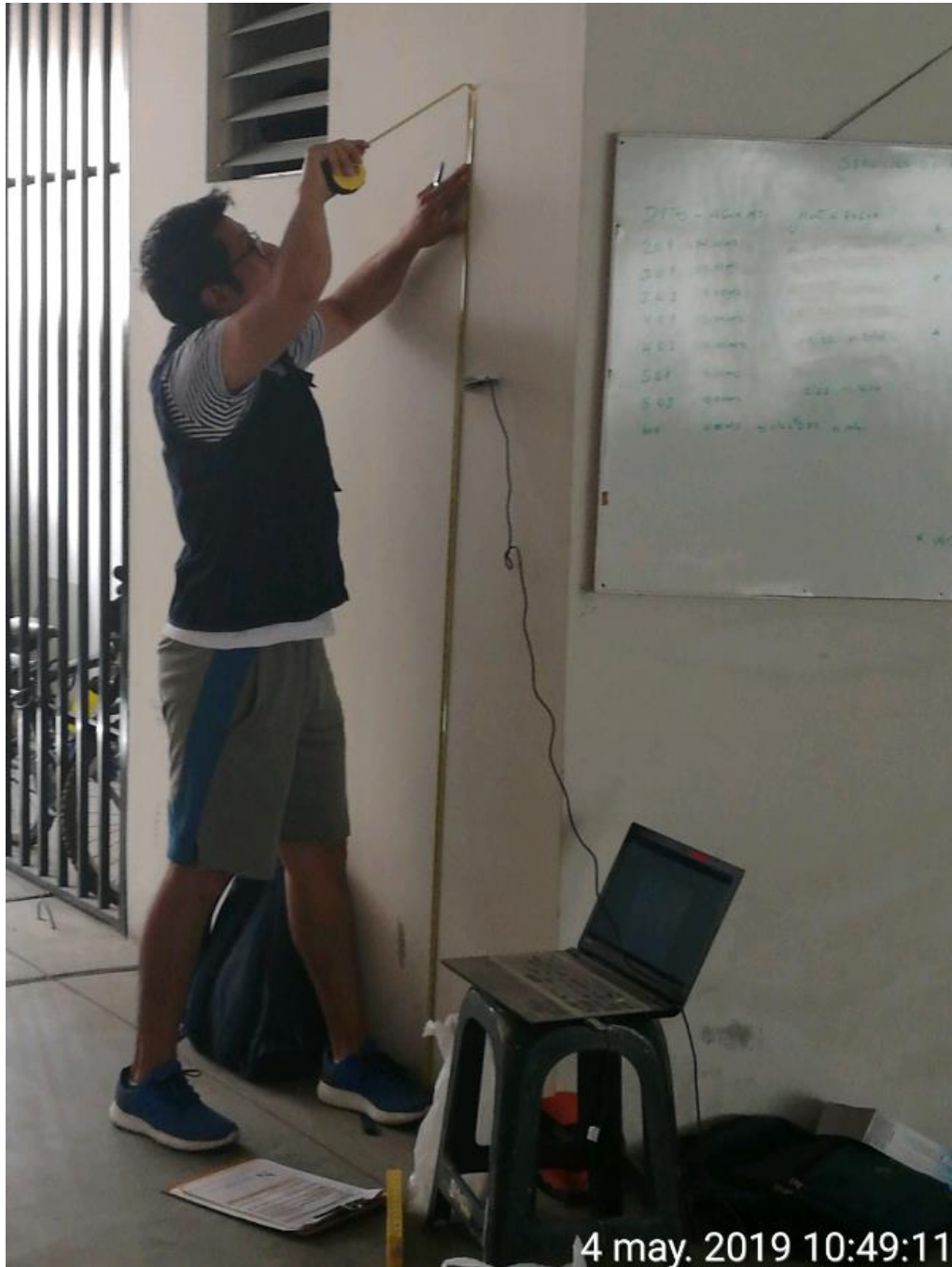
Fotografía 89: Toma de Lectura y medición de longitud de fisuras en Estacionamiento.
