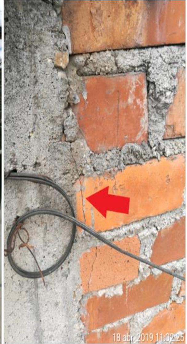
Fotografía 3: Grieta de Parapeto Sur (Azotea)
