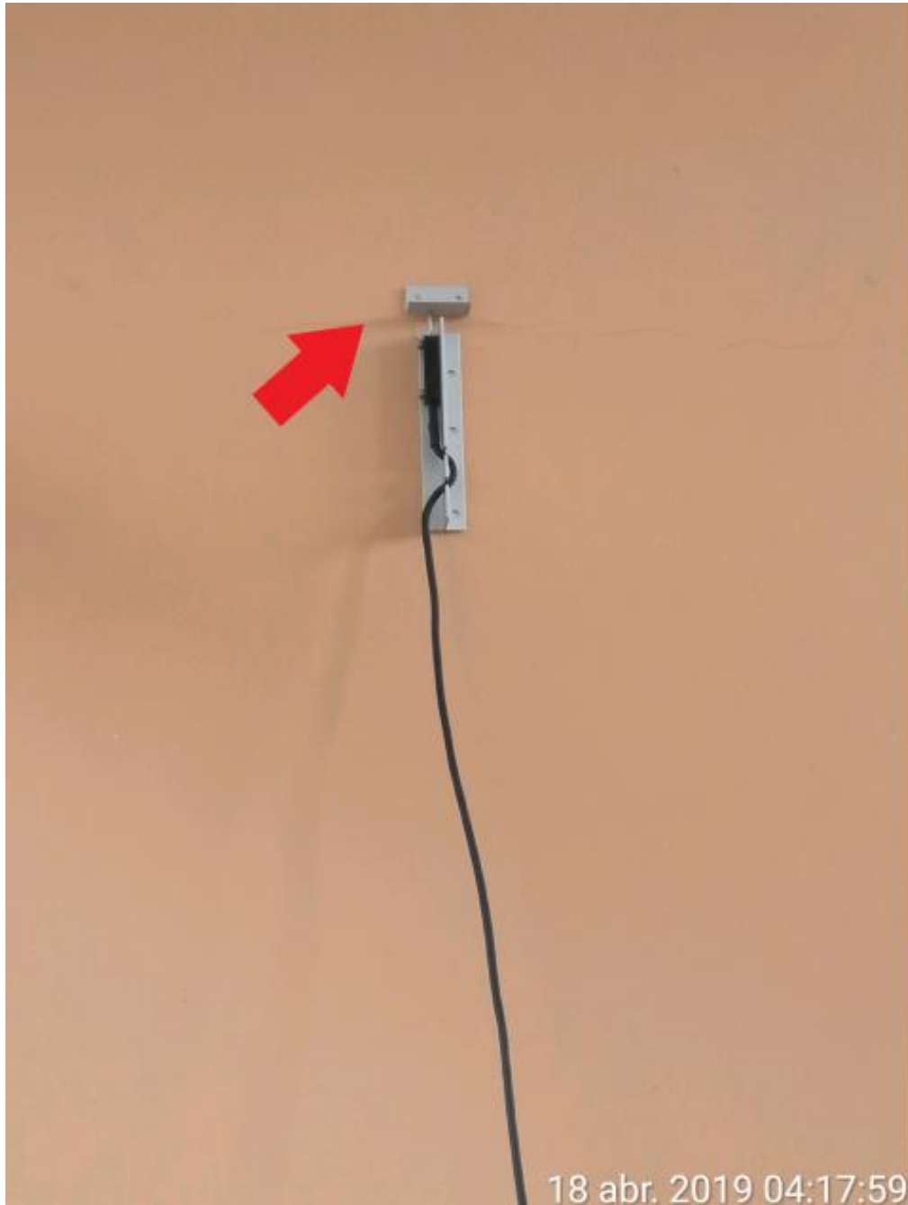
Fotografía 7: Fisura en Descanso de Escalera 6 to piso.
