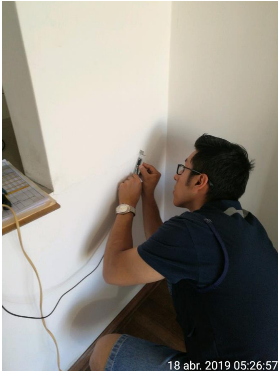
Fotografía 85: Colocado de censor en Departamento 502.
