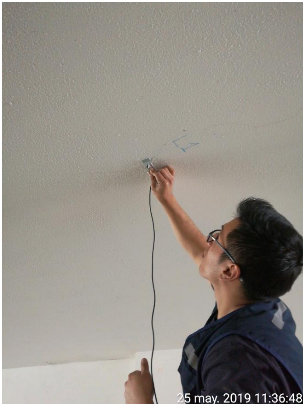
Fotografía 91: Colocado de censor en loza de estacionamiento.
