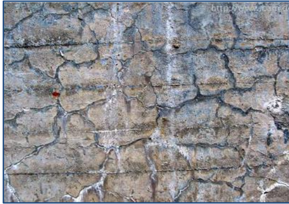
Figura 12: Fisuración por reacción Alkali-Sílice , de Rodríguez, (2011), Tesis de grado.
