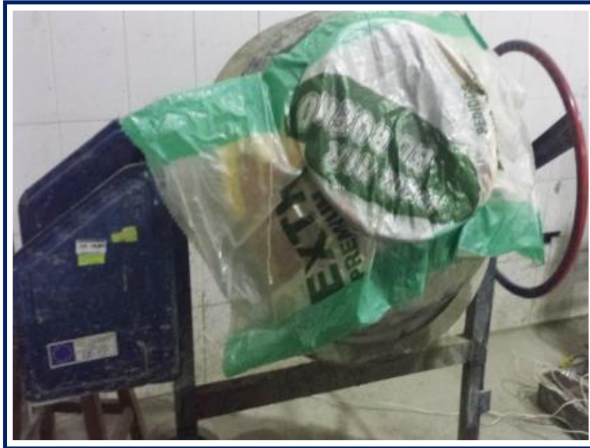
Figura 9. Elaboración del concreto en mezcladora
