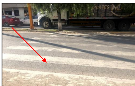
Demarcación de cruce peatonal.
