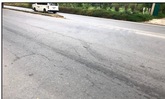
Indicaciones de frenado abrupto en tramos de vía.0
