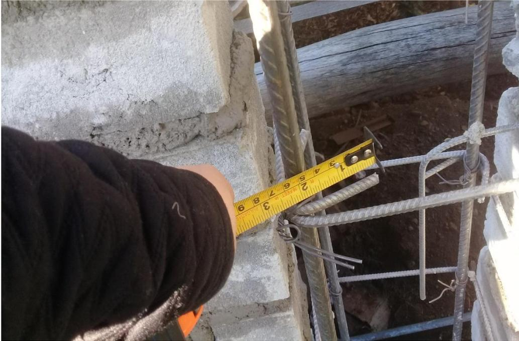
*Figura 85:* Midiendo los ganchos de los estribos de la columna.
