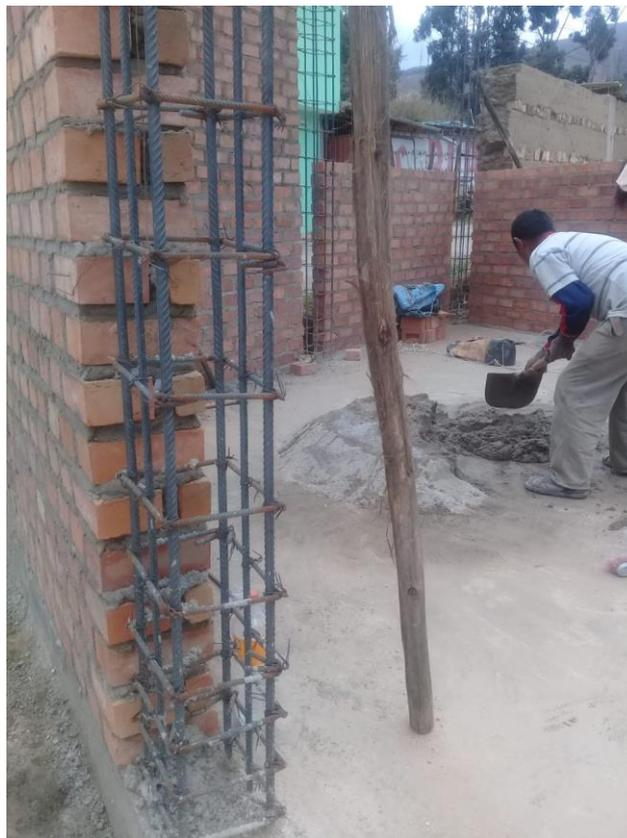
*Figura 75:* Operario haciendo la mezcla para el mortero del muro.
