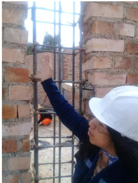
*Figura 77:* Observando la nivelación de la columna con el muro.
