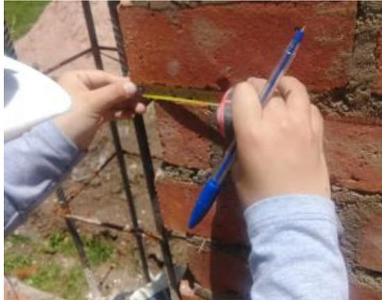
*Figura 91:* Toma de datos de la longitud de los dientes en el sistema de conexión dentado para la elaboración del APU.
