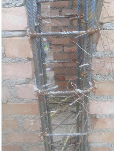
*Figura 78:* Tomando datos del Acero, estribos y mechas de la columna.
