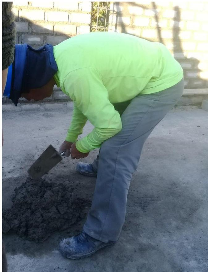
*Figura 86:* Peón haciendo la mezcla para el mortero para asentado de ladrillo.
