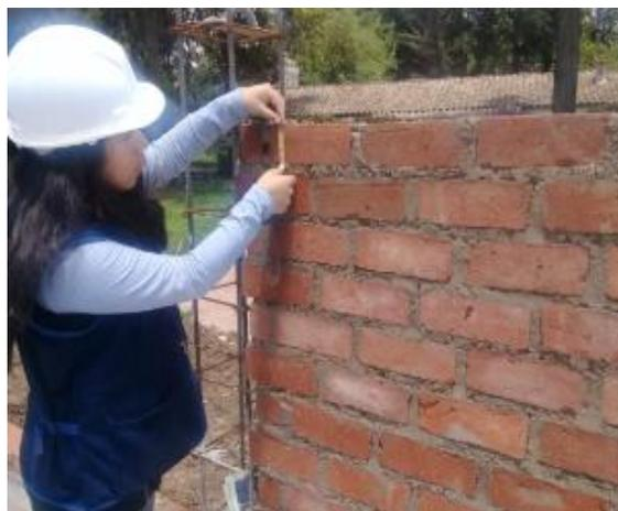
*Figura 93:* Toma de datos de las dimensiones de ladrillo y el mortero para la elaboración del APU.
