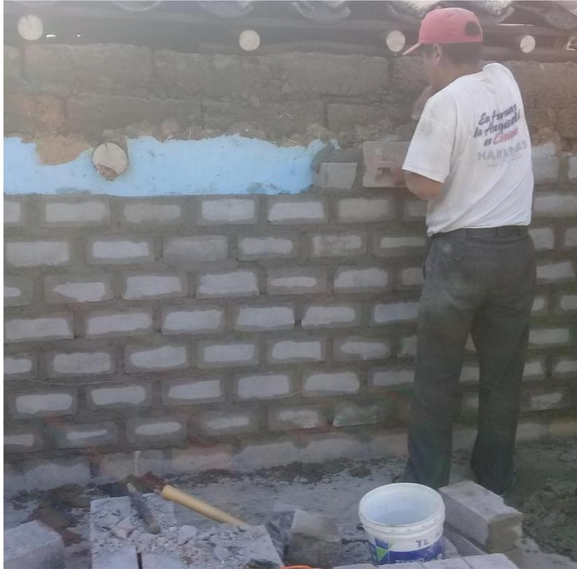
*Figura 87:* Operario haciendo el asentado de ladrillo y puesta de mortero.
