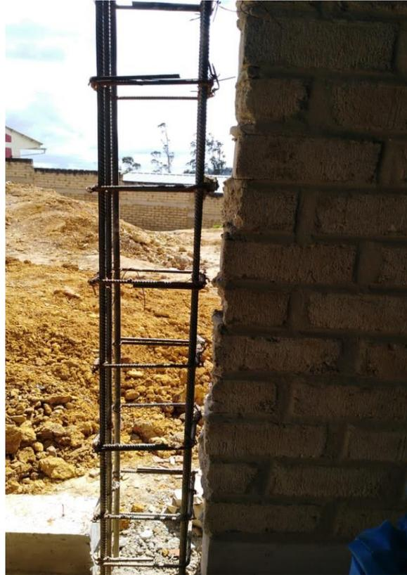
*Figura 81:* Observando la nivelación de la columna y el tipo de conexión usado.
