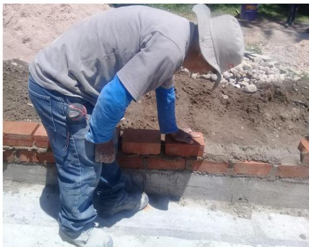
*Figura 80:* Operario colocando los ladrillos y el mortero en el muro de la vivienda.
