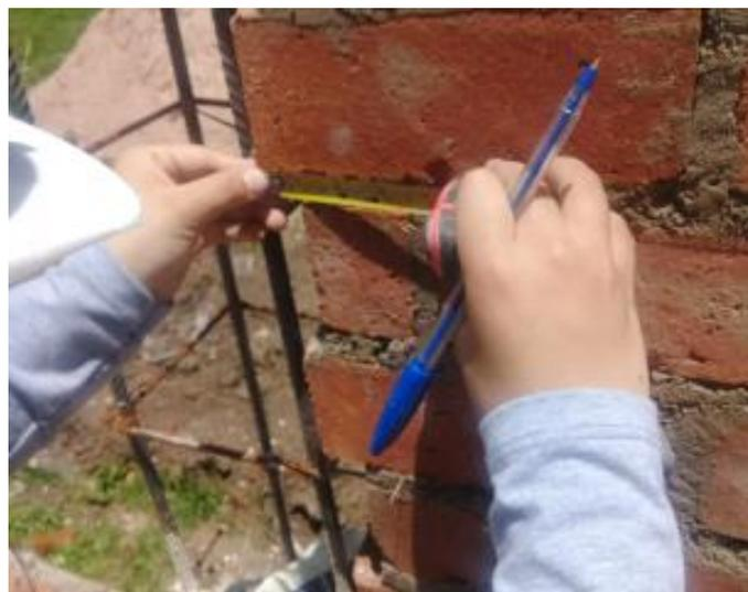
*Figura 7:* Medición de la longitud de los dientes en una vivienda elegida para la elaboración del APU.
