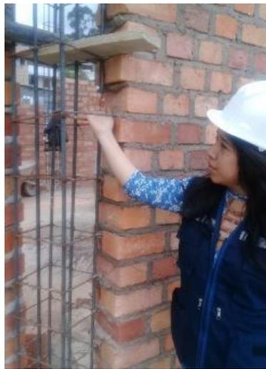
*Figura 9:* Uso de mechas en la interacción muro - columna en una vivienda con tipo de conexión dentado.
