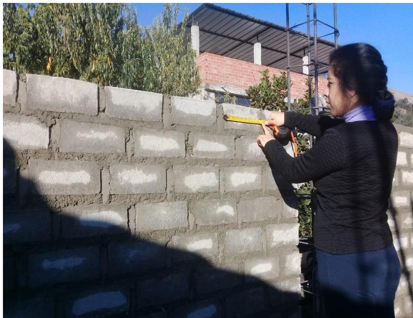
*Figura 88:* Midiendo con wincha las dimensiones de ladrillo y juntas.
