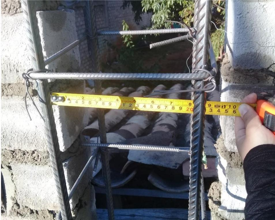
*Figura 83:* Tomando dimensiones de la columna, aceros y estribos
