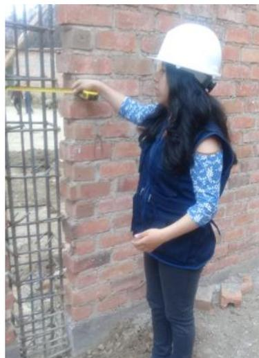
*Figura 10:* Toma de datos de las dimensiones de la columna para la elaboración del APU.
