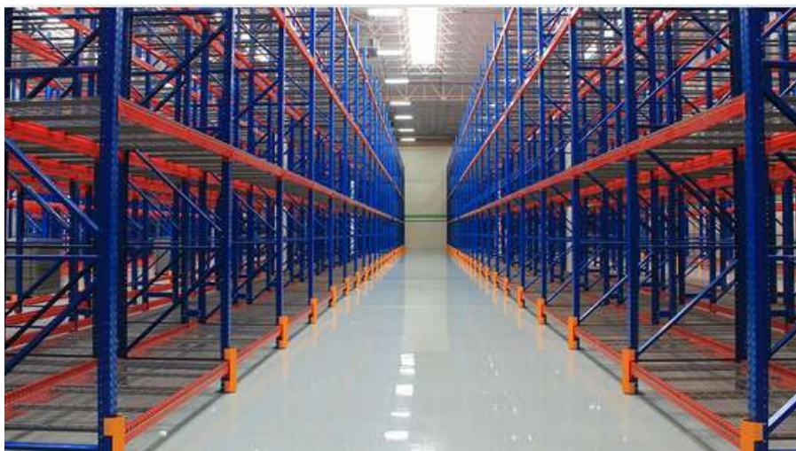
Figura 16, Rack de almacenamiento.
