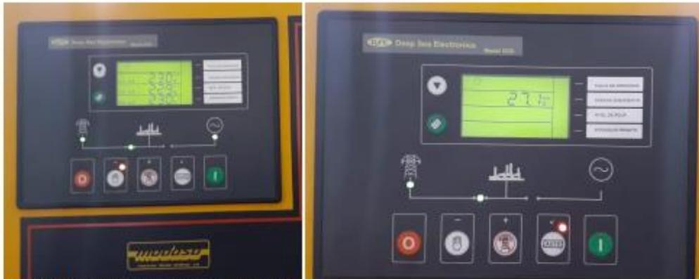
*Imagen 04: Pruebas en vacío y puesta en servicio. Después del mantenimiento preventivo semestral del equipo se realizó pruebas en vacío en modo manual. Después de las pruebas realizadas al equipo se dejó en modo automático el sistema de control y el ITM cerrado.*
