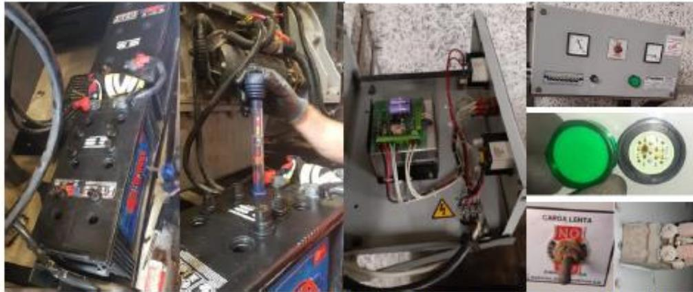
*Imagen 02: Mediciones de voltaje, densidad de las baterías y mantenimiento al cargador de baterías. En las imágenes se muestran las mediciones realizadas con el densímetro y la pinza amperimétrica a las baterías encontrándose con los niveles dentro del rango permitido. Se realizó el mantenimiento preventivo del cargador de batería estático las cuales tiene observaciones de sus componentes en mal estado (led indicador y el switch on-off).*
