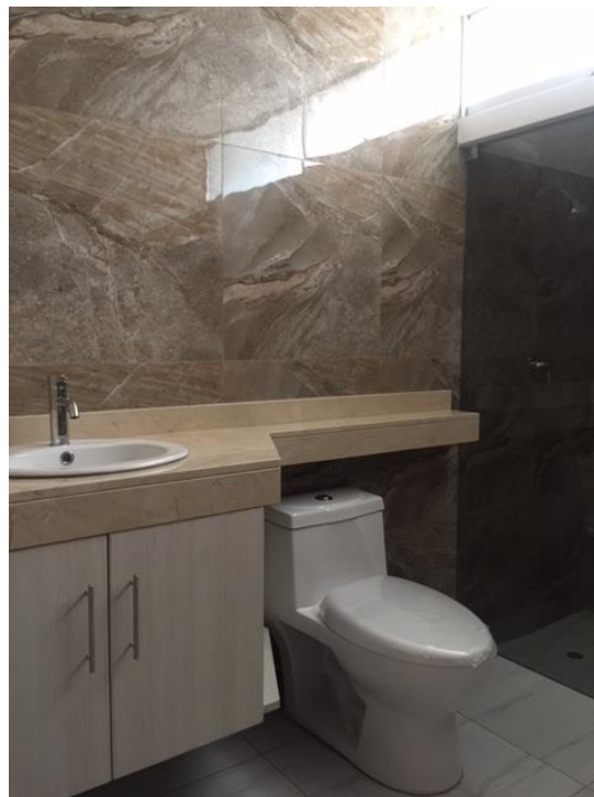
Figura 18. Instalación de tableros de mármol y revestimientos de porcelanato.
