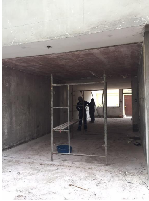
Figura 12. Revestimientos eliminados en piso y techo
