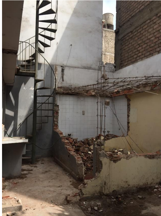
Figura 8. Estructura independiente en área posterior en proceso de demolición
