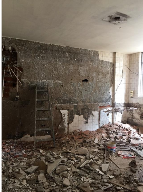
Figura 10. Revestimientos en proceso de extracción Fuente: Base de datos de Gestión de Proyectos
