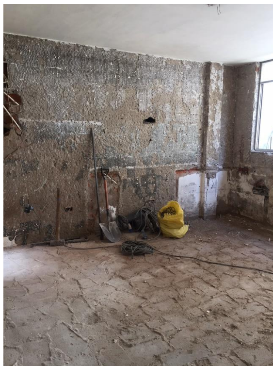
Figura 11. Revestimientos eliminados en piso y pared Fuente: Base de datos de Gestión de Proyectos
