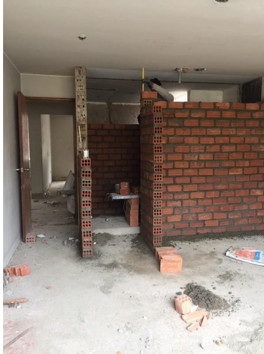
Figura 14. Tabiquería para adicionar nuevo baño y closet en dormitorio principal
