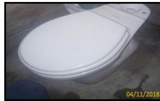
Fotografía 1. Losa de los servicios higiénicos inexistente.
