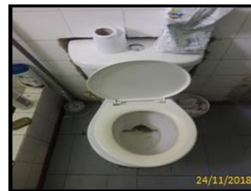
Fotografía 14. Inodoro empotrado en muro.
