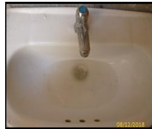
Fotografía 29. Cambio de accesorios en lavatorio.
