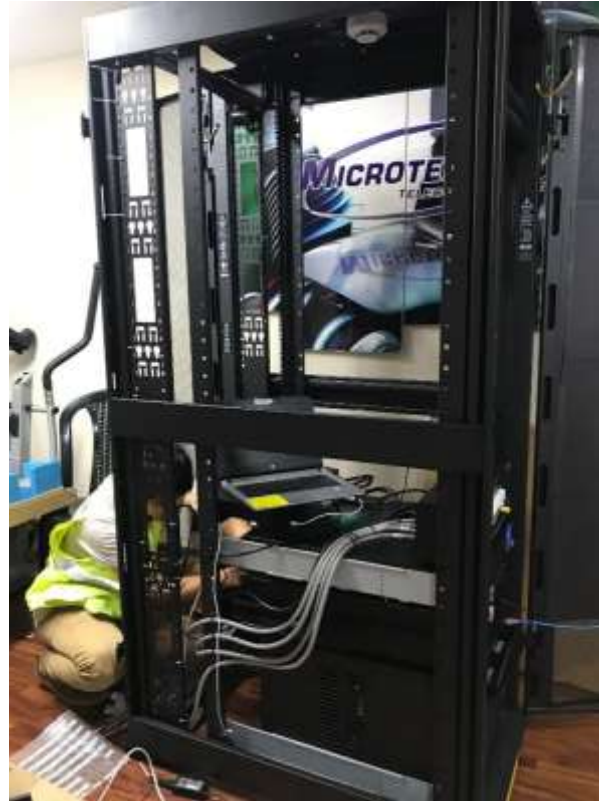
Figura N° 15 Imagen del microdatacenter instalado.
