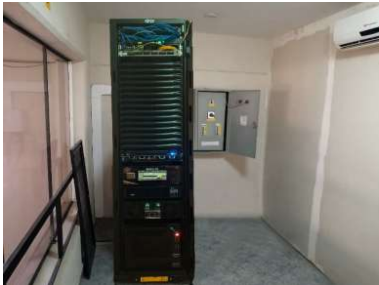
Figura N° 15 Imagen del microdatacenter instalado.
