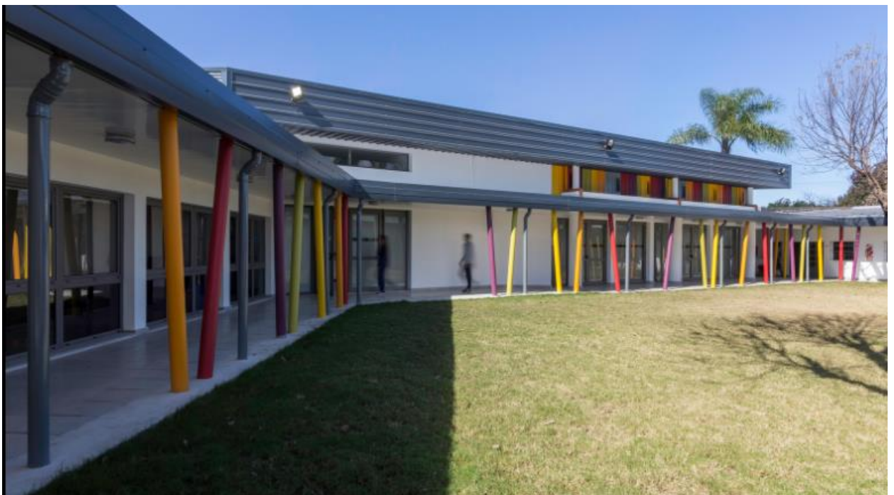
Figura V. Vista aérea de la Escuela Especial N° 149
