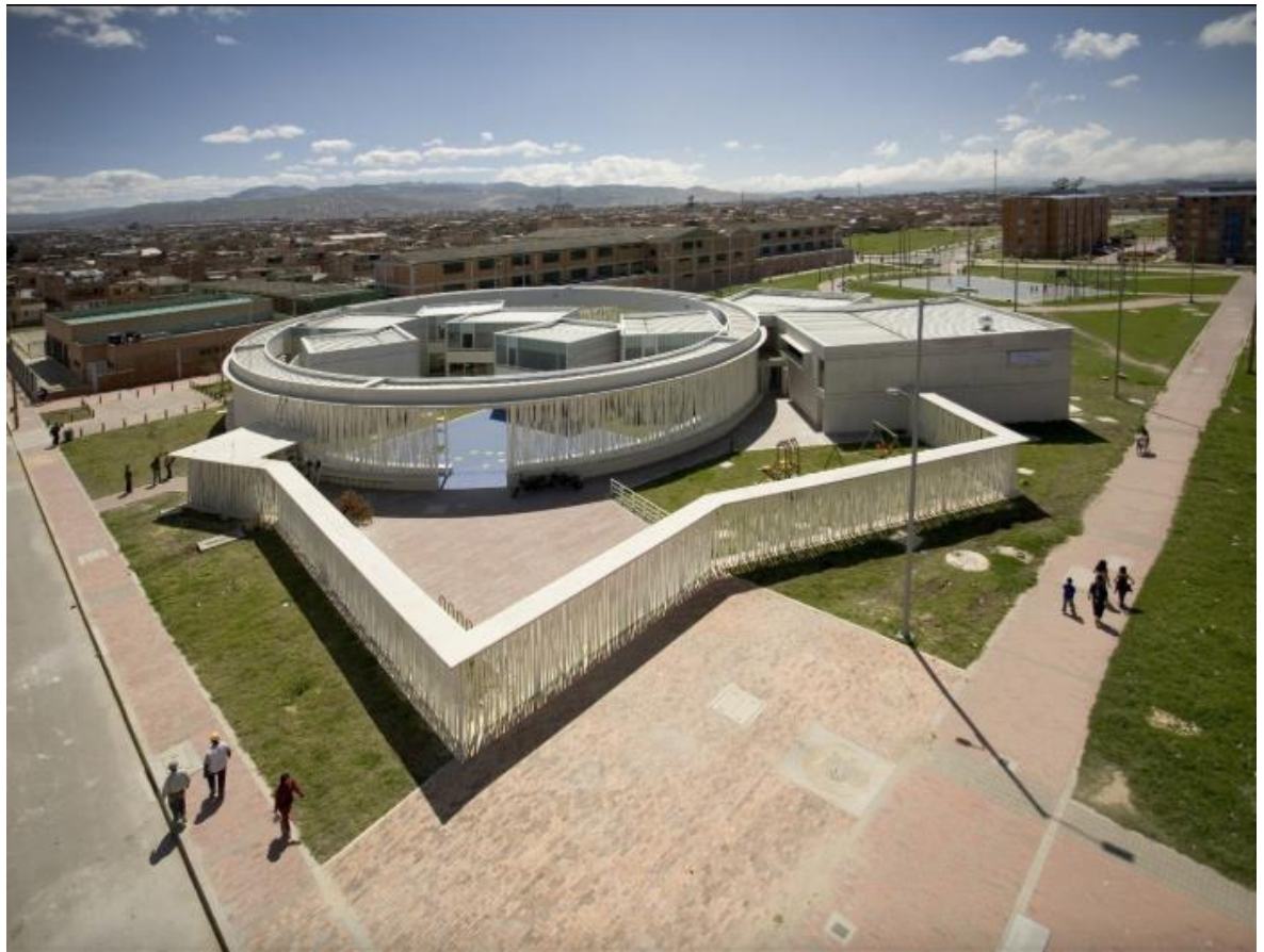
Figura IV. Vista aérea de colegio El Porvenir
