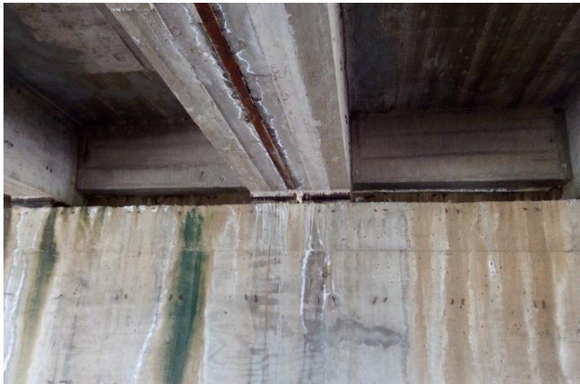
Figura 28 Unión de los dos tableros del Puente Los Shilcos.
