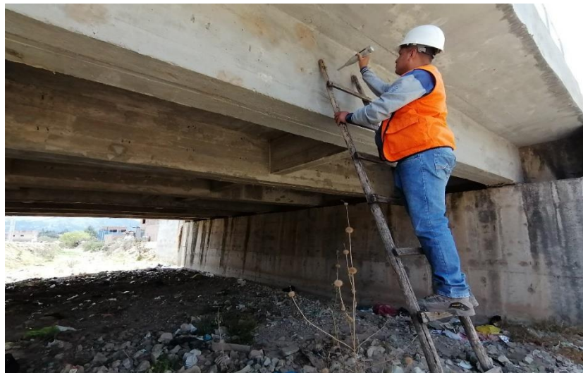
Figura 30 Realizando el ensayo de esclerometría en el Puente Shudal.
