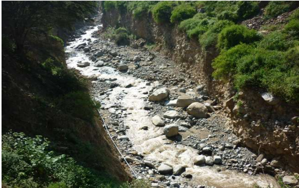
Figura 15: Captación Colapsada- Simbal
