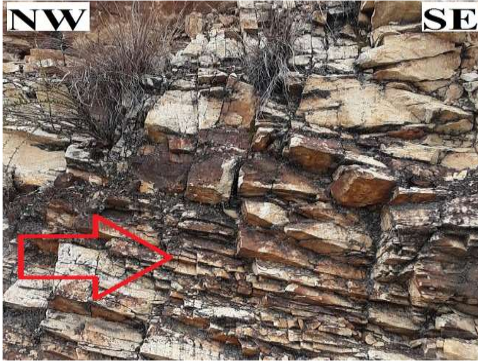
Figura 18. Roca moderadamente meteorizada.
