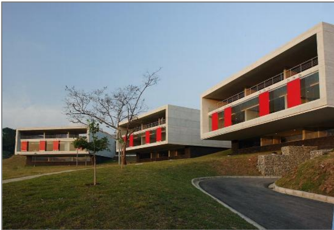
Figura 02: Vista del Parque Biblioteca León Grieff – Medellín.
