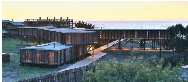
Figura N° 12: Uso de vidrio fotovoltaico
