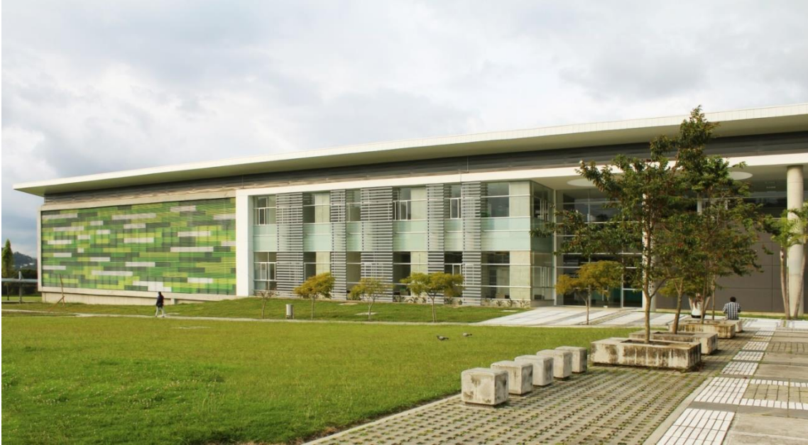
Figura N° 04: Vista del proyecto
