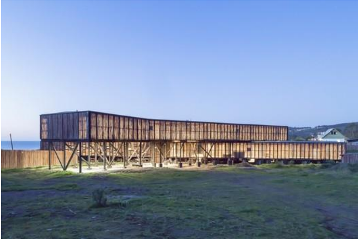
Figura N° 02: Vista del proyecto
