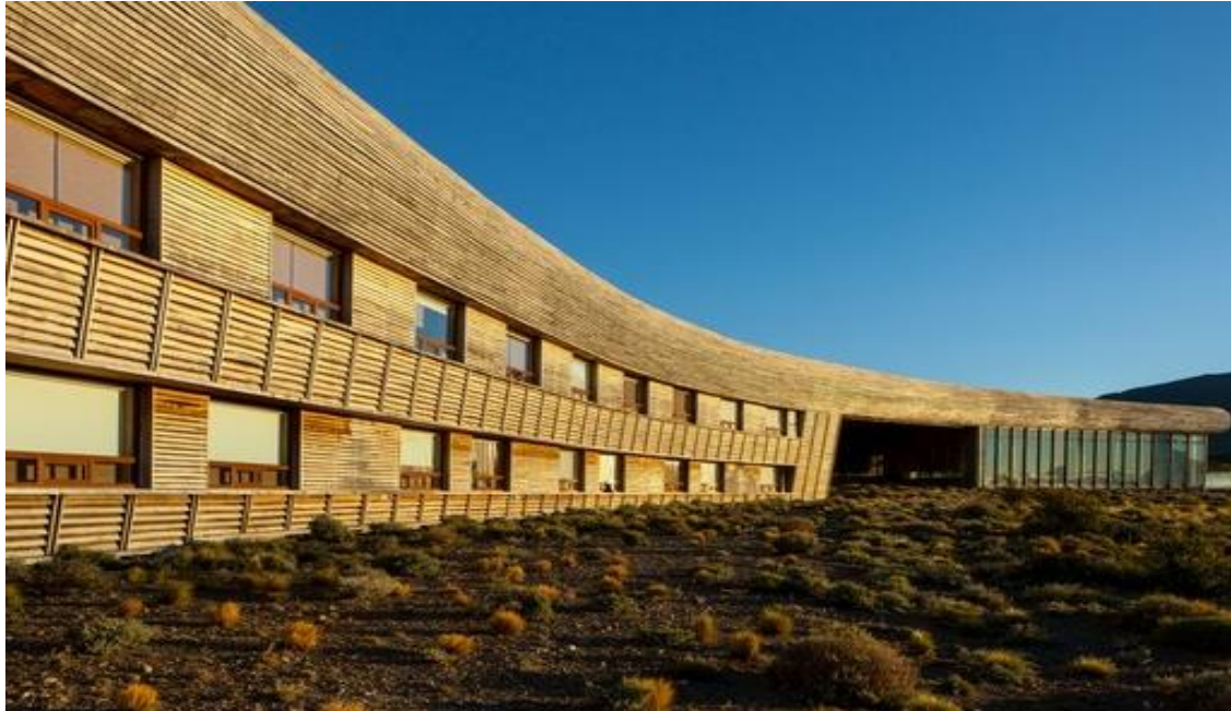
Figura N° 05: Vista del proyecto
