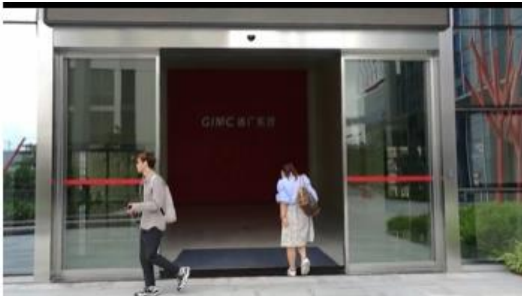
Figura 20. Puerta de apertura y cierre automático
