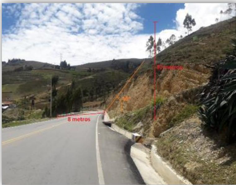
Figura 31 Talud de la estación geomecánica 10
