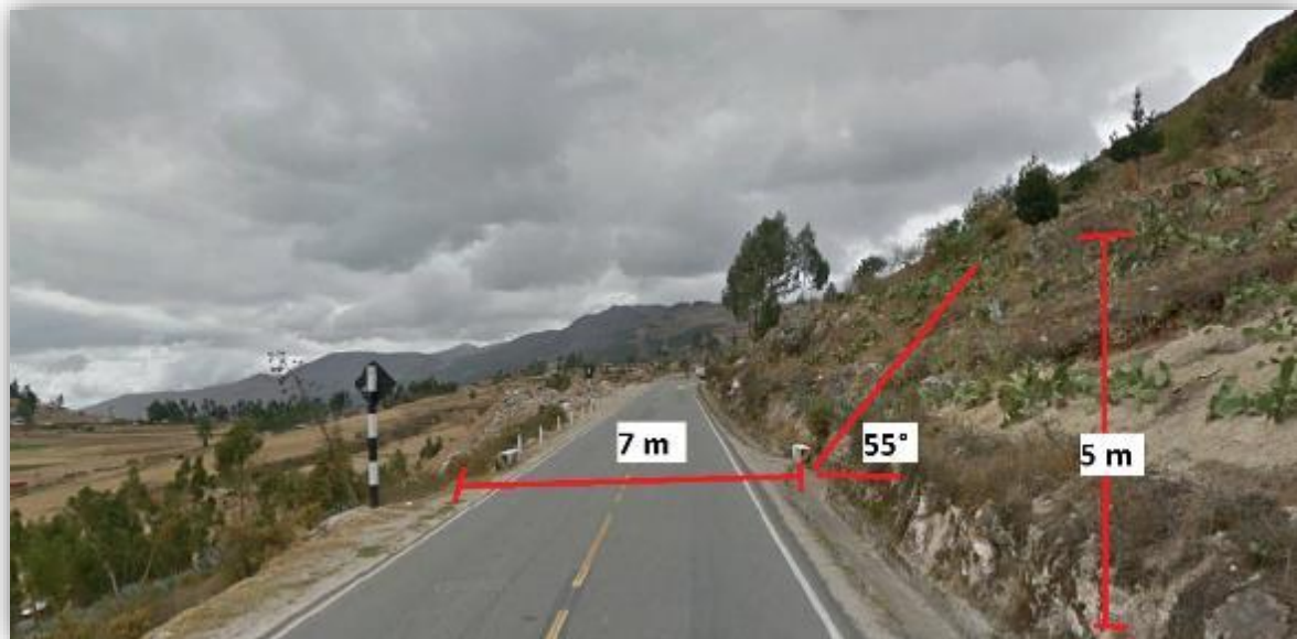
Figura 35 Talud de la estación Geomecánica 12
