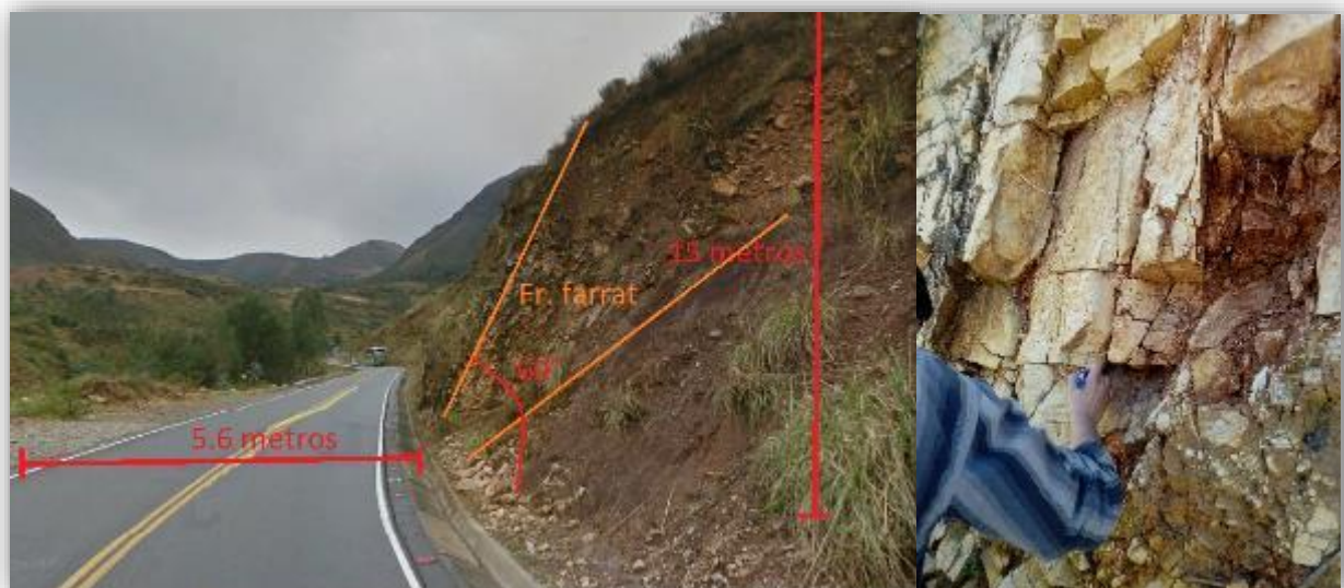
Figura 18 Talud de la estación geomecánica 04
