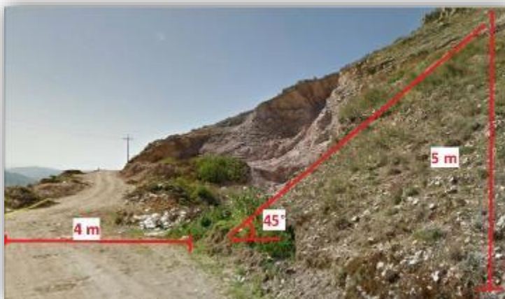
Figura 36 Talud estación Geomecánica 13
