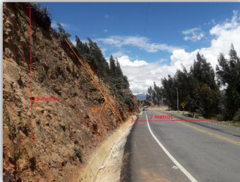
Figura 28 Talud de la estación geomecánica 09
