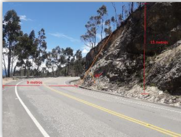
Figura 26 Talud estación geomecánica 08
