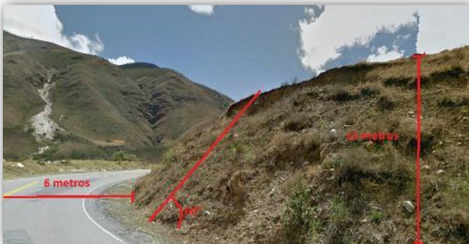
Figura 20 Talud de la Estación Geomecánica 05
