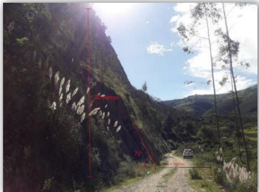
Figura 10. Talud de la estación 01
