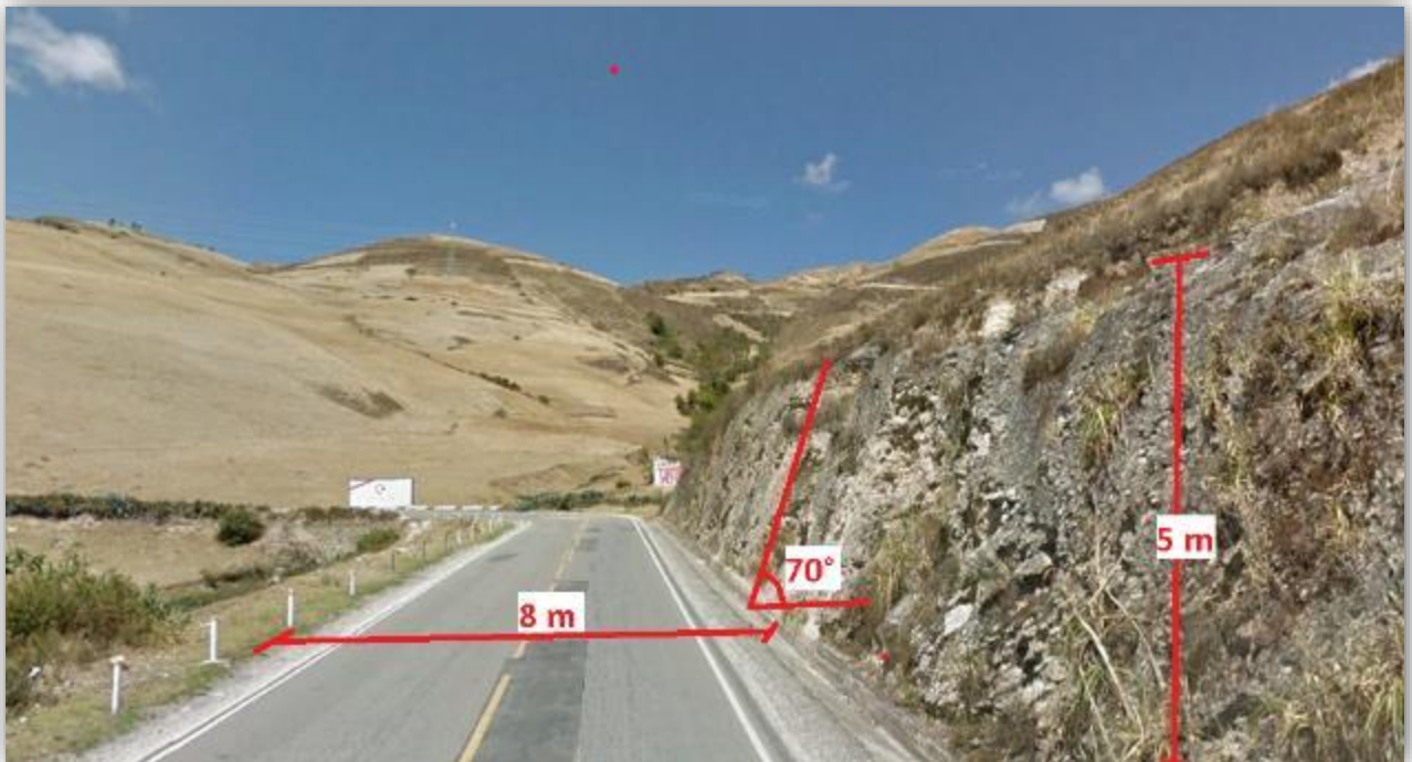
Figura 33 Talud de la estación geomecánica 11
