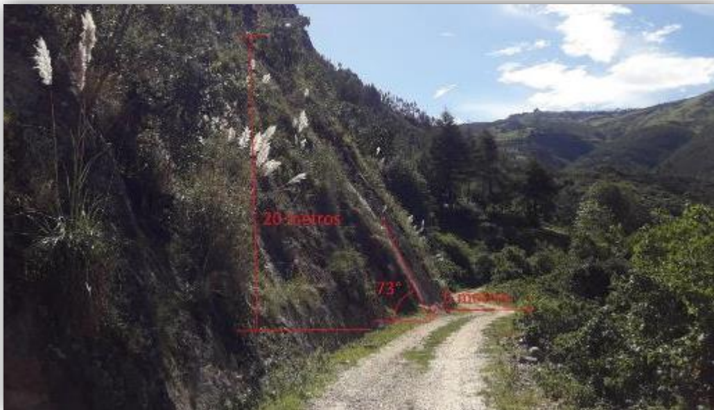
Figura 13. Talud de estación geomecánicas 2
