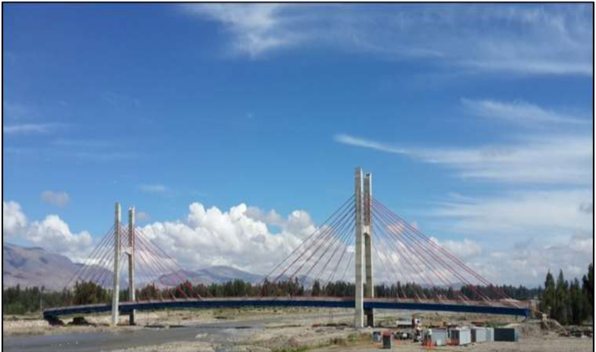
Figura 14 – Construcción del Puente Comuneros
