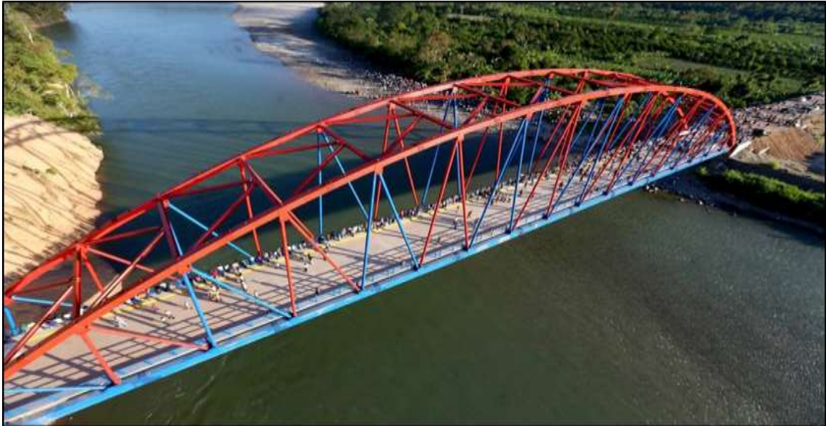
Figura 13– Ampliación y mejoramiento del Puente Noruega
