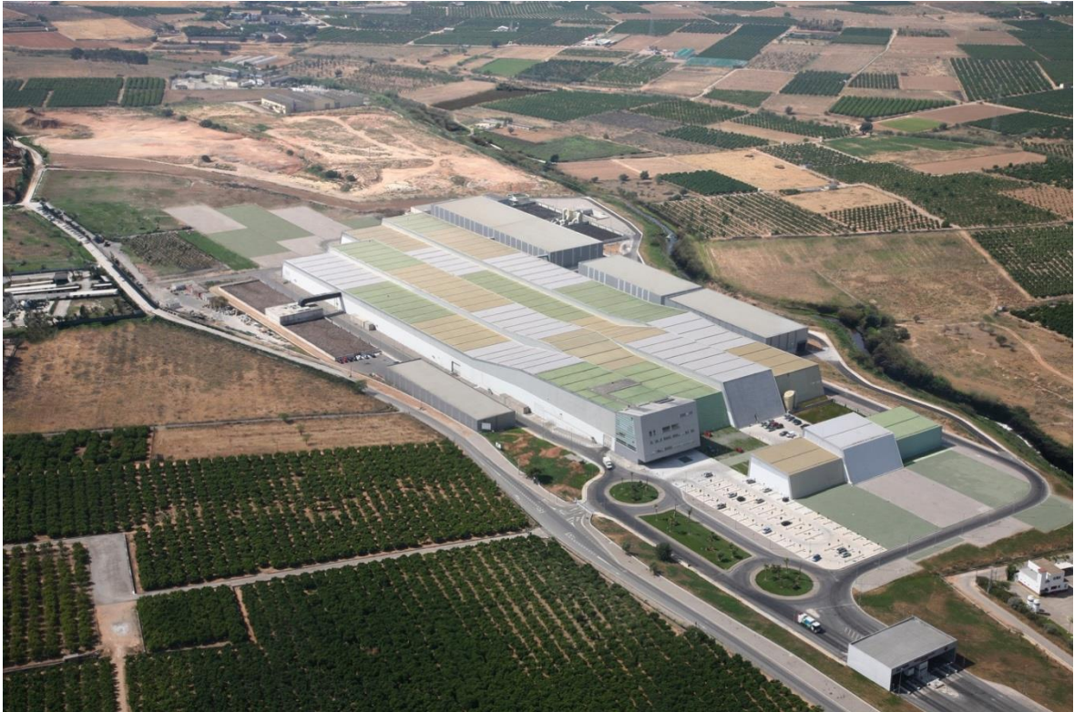
Figura 6. Vista aérea del proyecto de la Planta para Tratamiento de Residuos, recopilado de archdaily.pe.
