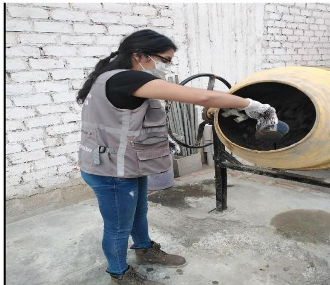
**Figura 28:** La figura muestra la elaboración del concreto elaborado con cemento tipo MS. Autoría propia.
