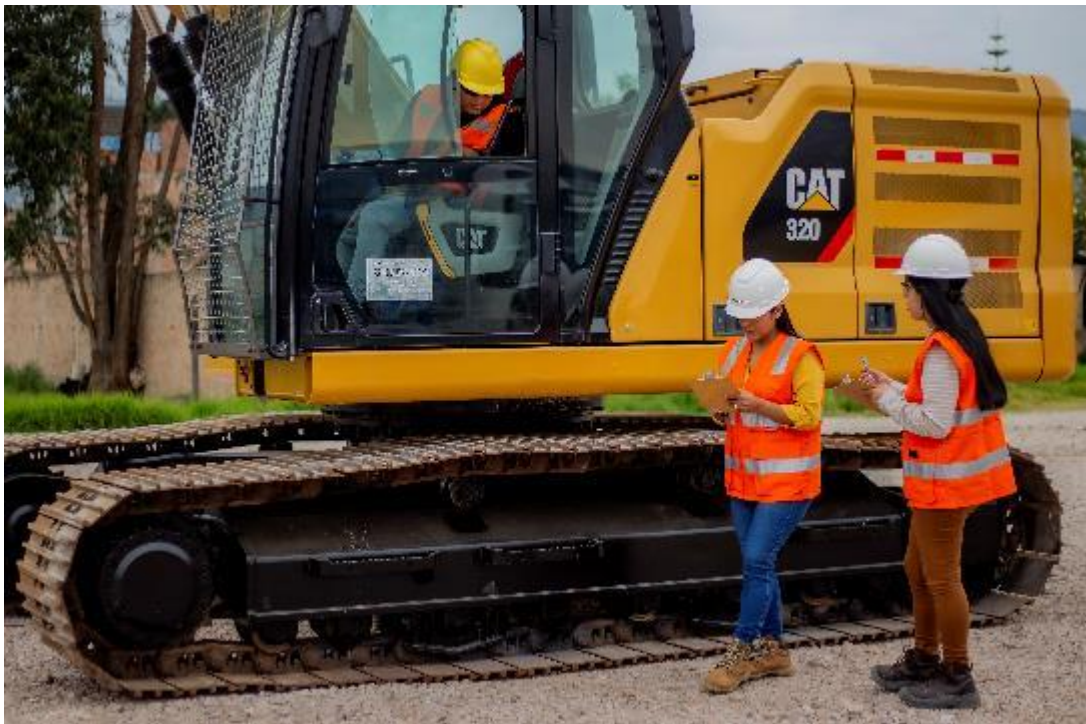
Foto 4. Recogiendo información del operador de la Excavadora
