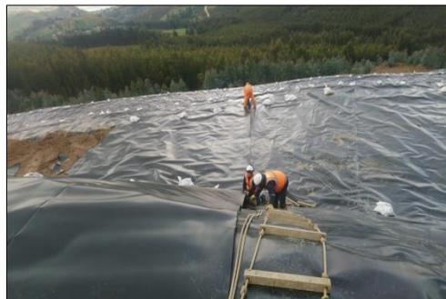
*Figura 5.* Instalación de geomembrana
