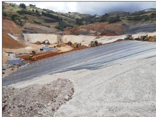
*Figura 4.* Instalación de sistema Rain Coat
