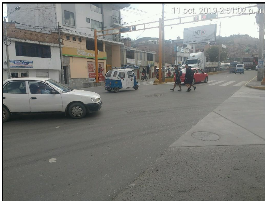
Figura 23. Se aprecia que no se cuenta con isla de refugio.
