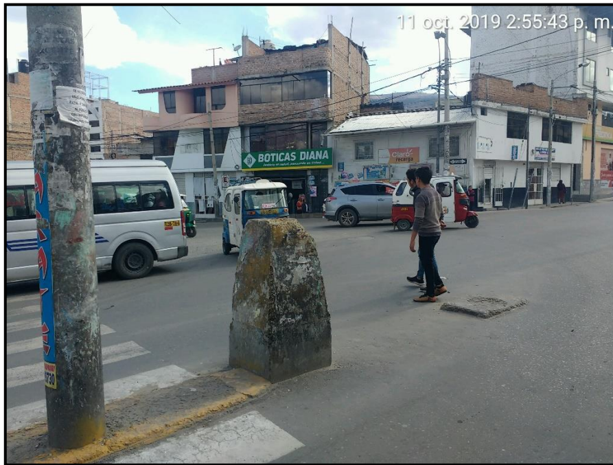
Figura 22. No presenta isla de refugio en la Av. Atahualpa.
