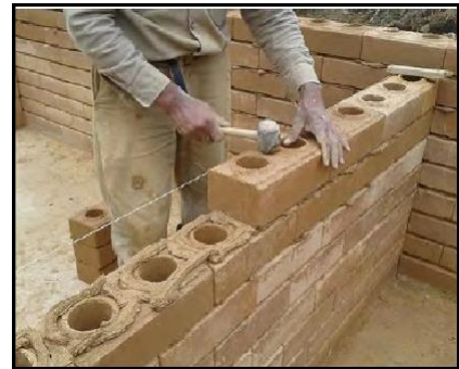
Imagen 2 Proceso constructivo BSC
