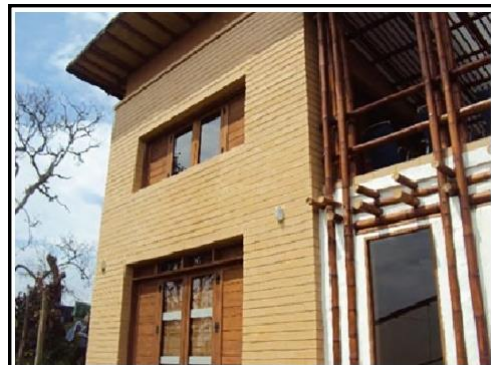
Imagen 3 Fachada en BSC, bahareque y guadua
