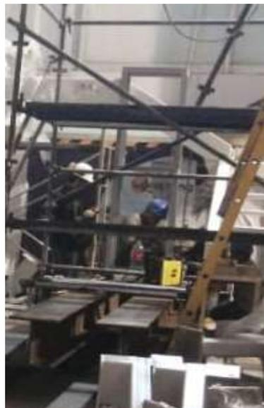
*Figura 64.* Montaje de primer módulo de la torre grúa.
