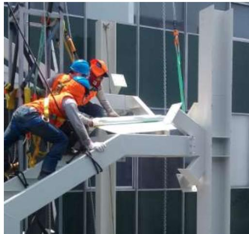
*Figura 71.* Montaje descanso de escalera nivel 2.
