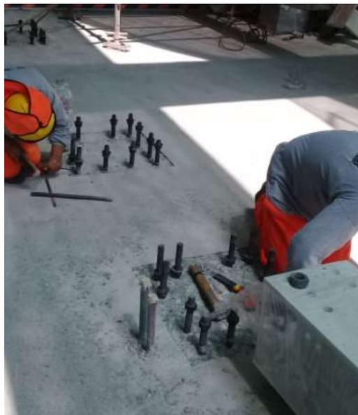
*Figura 58.* Instalación de contra tuercas.
