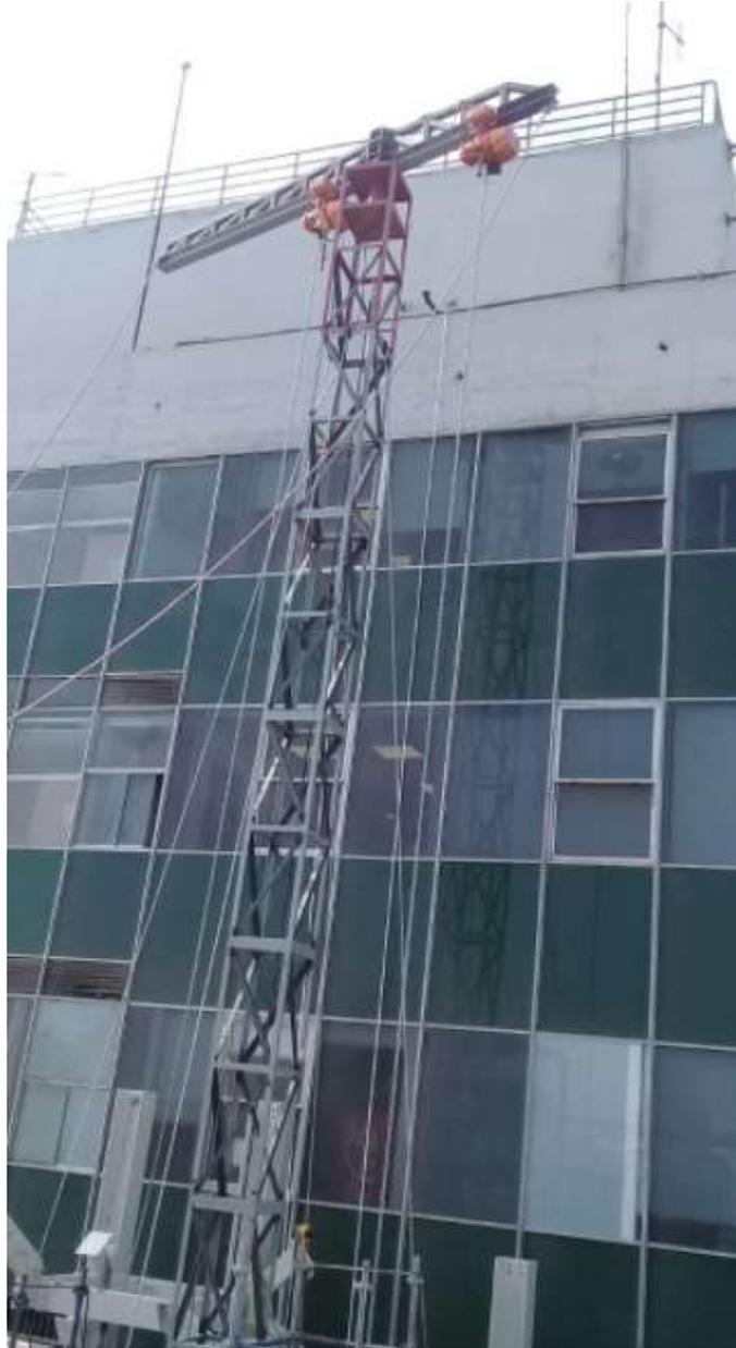
*Figura 9.* Estructura tipo torre grúa.
