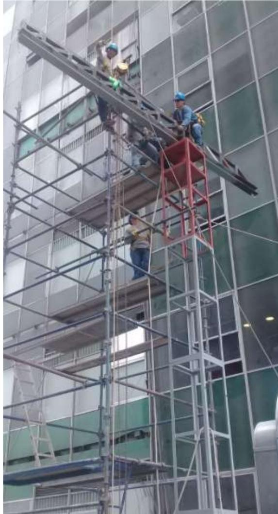
*Figura 65.* Montaje del brazo de la grúa.
