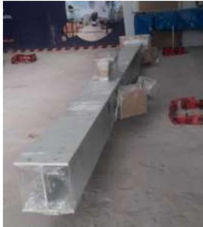
*Figura 59.* Ubicación de columna para iniciar montaje.
