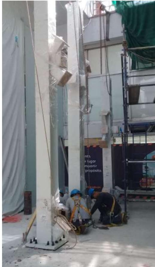
*Figura 61.* Fijación de las columnas metálicas del nivel 1.
