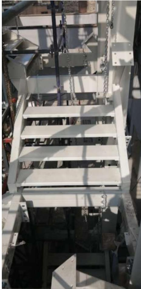
*Figura 62.* Montaje de escalera metálicas del nivel 1.
