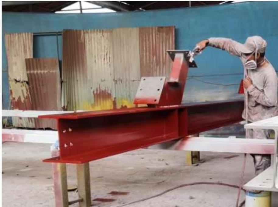
*Figura 41.* Aplicación de pintura base.
