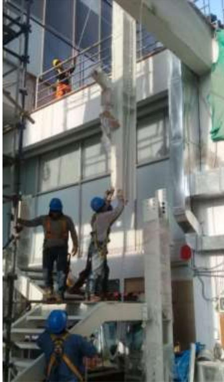
*Figura 66.* Montaje columna nivel 2.
