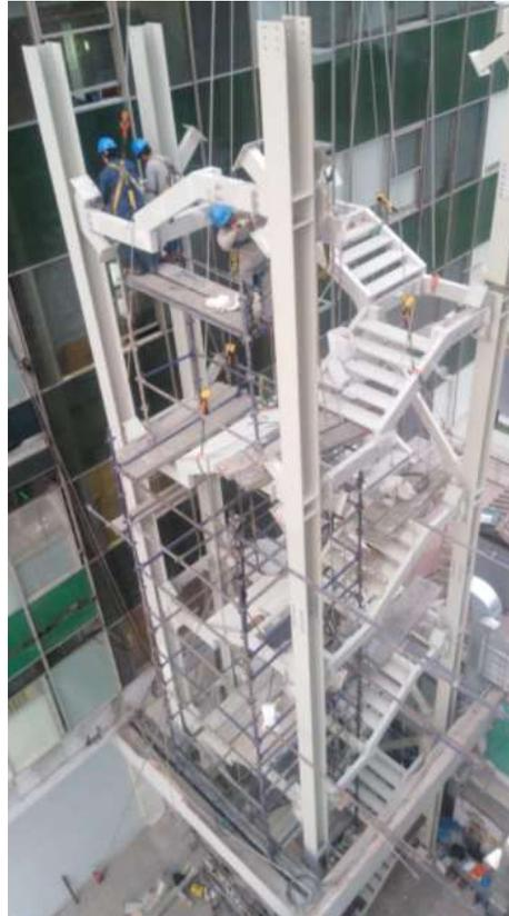
*Figura 73.* Montaje de escalera nivel 3.
