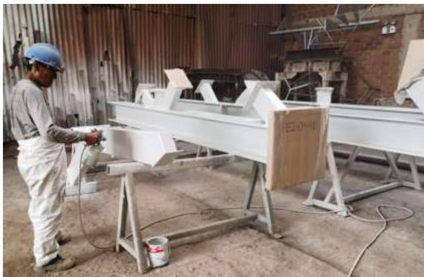
*Figura 42.* Aplicación de pintura de acabado.
