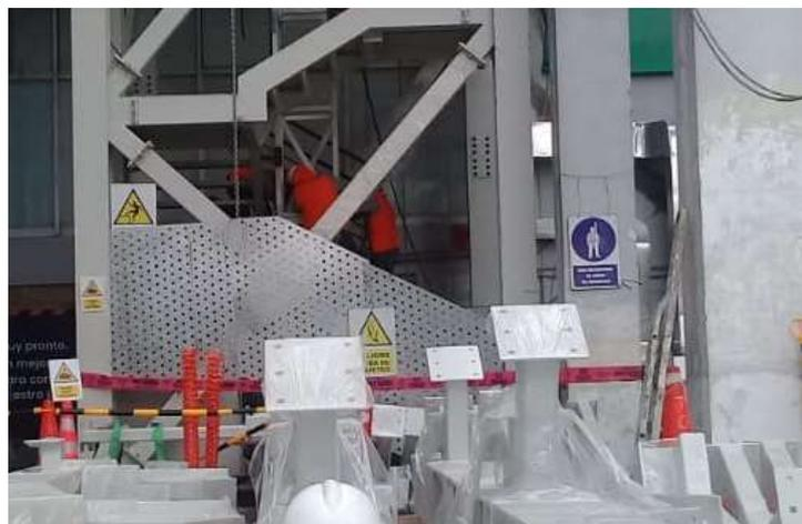
*Figura 72.* Izaje de la torre para ganar altura.
