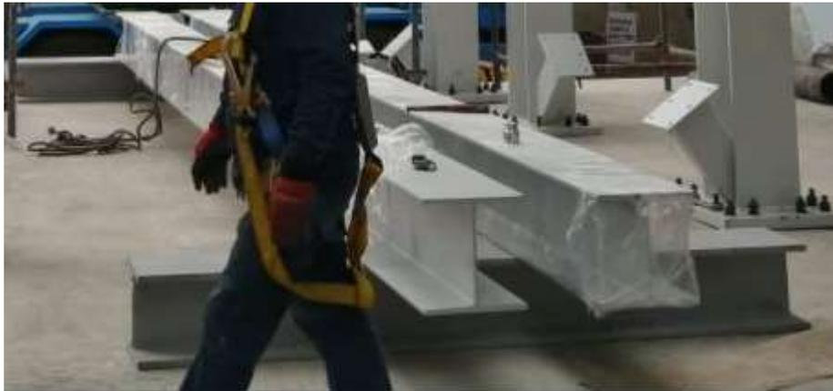
*Figura 63.* Estructura base para apoyo de torre grúa.
