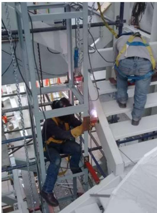
*Figura 70.* Montaje paso de escalera.
