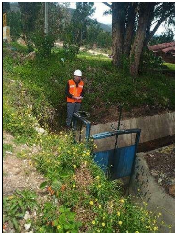
Imagen 48: Punto final del canal principal de derivación. Punto final del canal principal de derivación.
