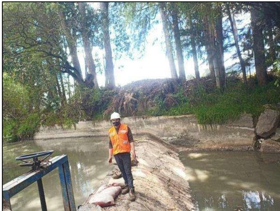
Imagen 75: Costales de arena sobre el barraje. Se muestra unos costales de arena sobre el barraje para captar mejor el caudal.
