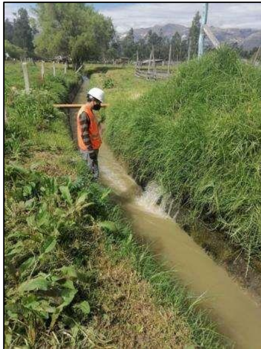
Imagen 35: Ingreso de aguas residuales de la PTAR al canal de riego la Collpa El canal de riego es abastecido por las aguas residuales de la PTAR de la ciudad e Cajamarca.
