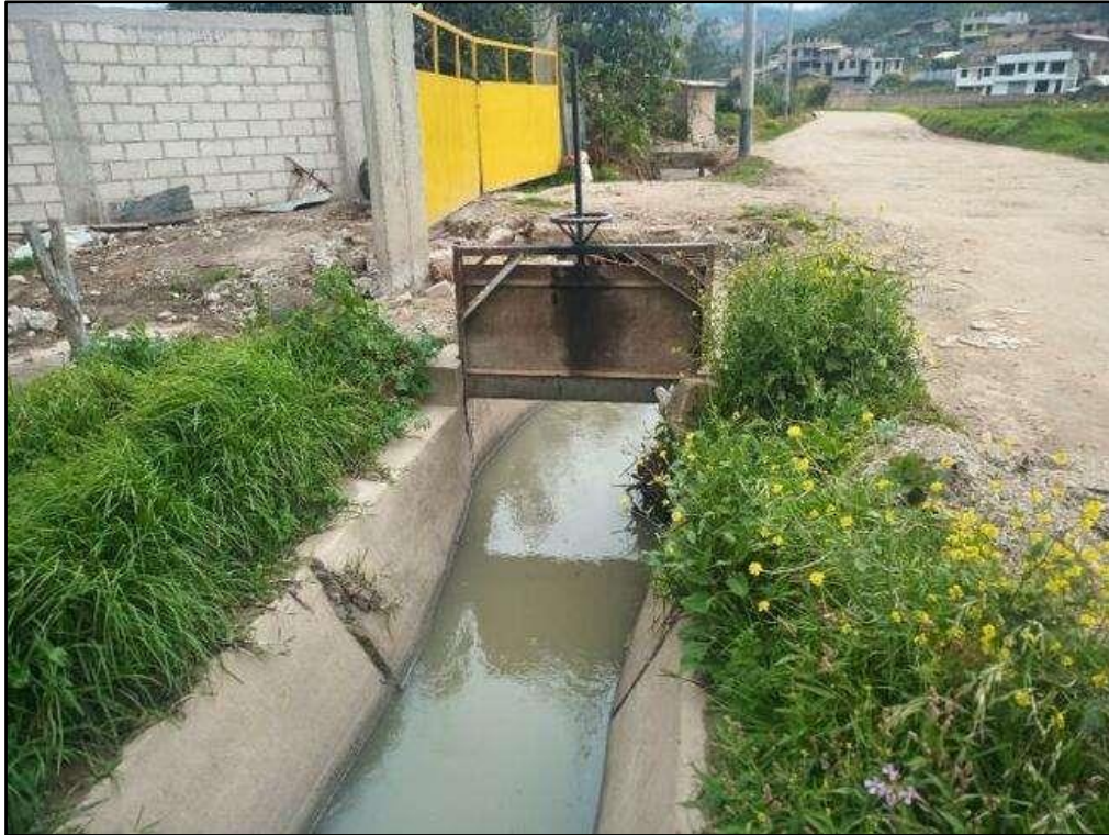
Imagen 71: Compuerta tipo tarjeta sin pintura. Se muestra la compuerta de hierro tipo tarjeta; la cual controla el curso del agua.
