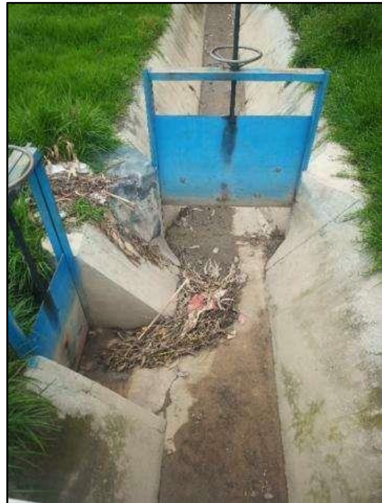
Imagen 39: Tramos finales del canal
