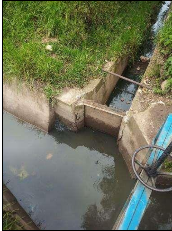
Imagen 57: Tramo del canal lateral de primer orden N° 03. Tramo del canal lateral de primer orden N° 03.
