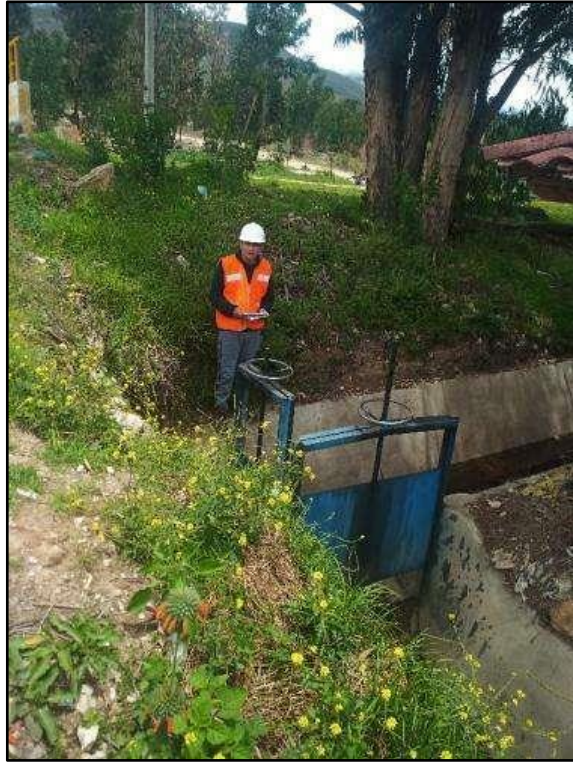
Imagen 40: Punto final del canal la Collpa.
