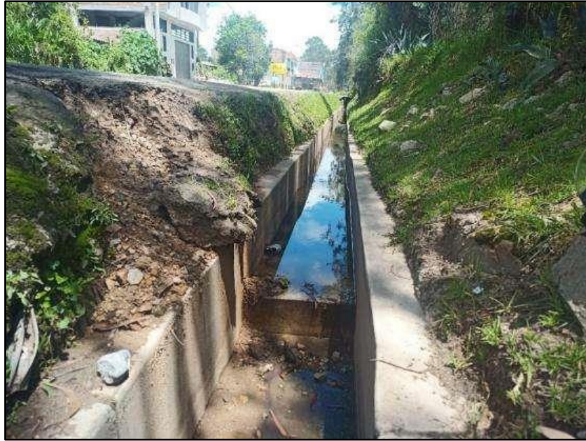
Imagen 51: Tramo del canal lateral de primer orden N° 01
