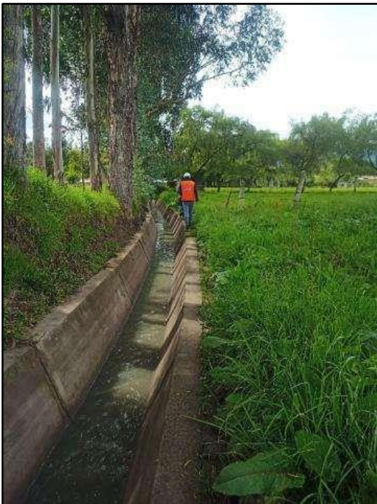
Imagen 15: Tramo en buen estado del canal.
