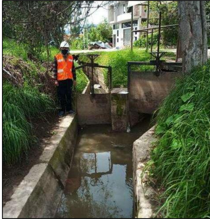
Imagen 23: Inicio del canal lateral de primer orden.
