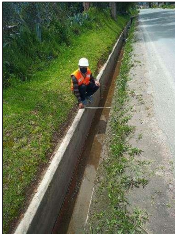
Imagen 52: Mediciones del tramo del canal lateral de primer orden N° 01
