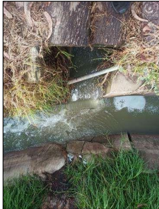
Imagen 12: Ingreso de aguas grises al canal.
