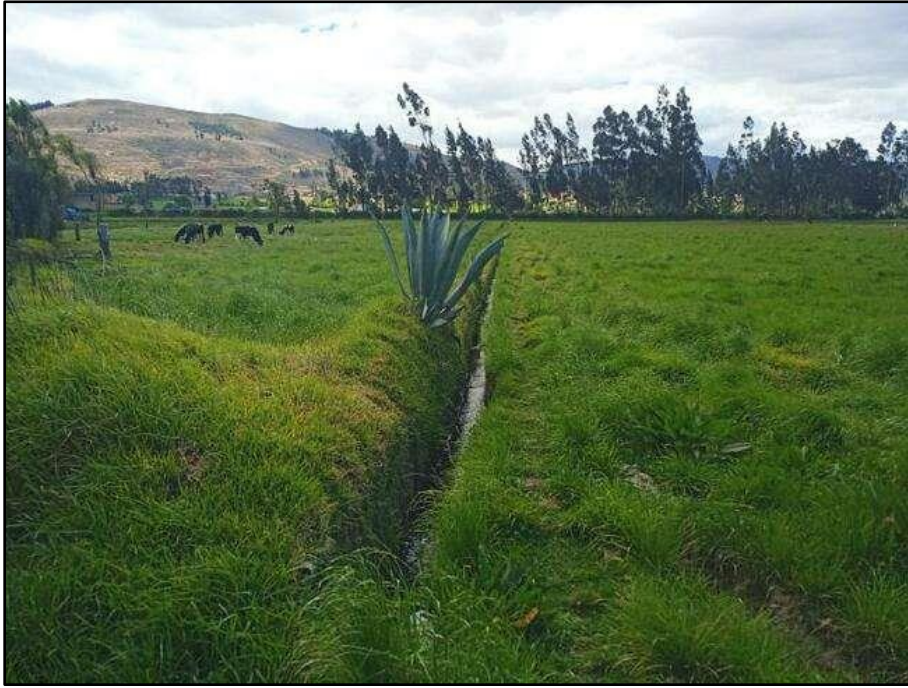
Imagen 50: Tramo de canal lateral de primer orden sin revestir
