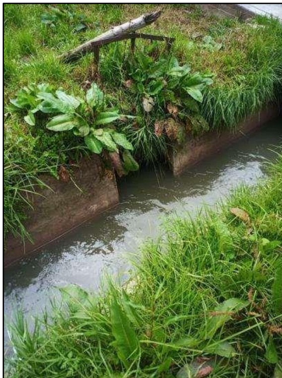
Imagen 78: Rotura de concreto para nuevas tomas. Generación de nuevas tomas por parte de los usuarios.
