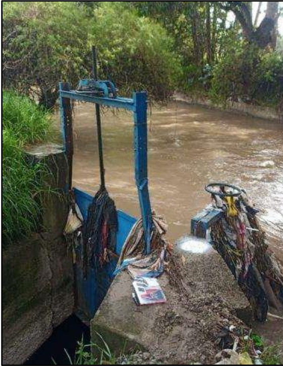
Imagen 04: Bocatoma del canal la Collpa en épocas de lluvia.
