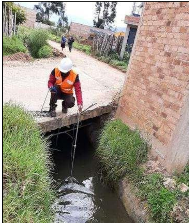
Imagen 53: Tramo del canal lateral de primer orden N° 02
