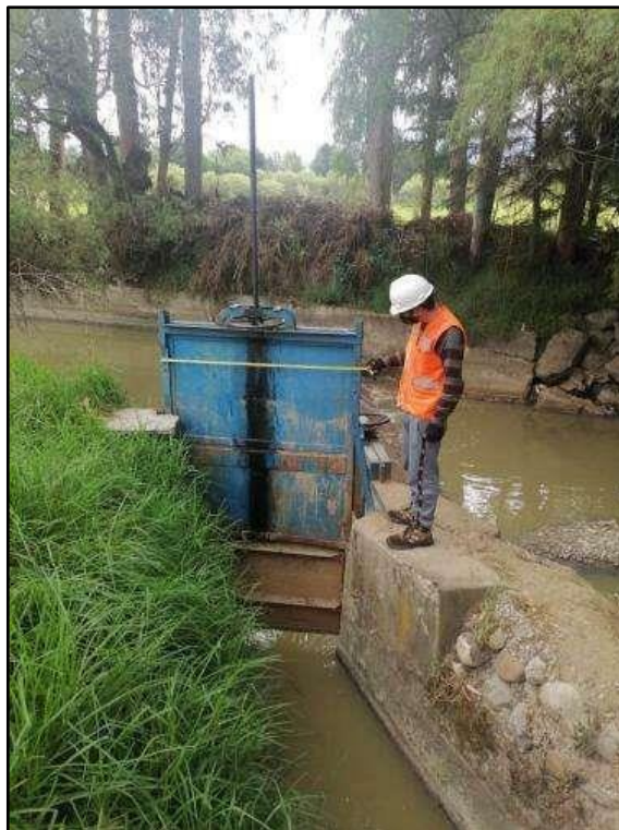
Imagen 19: Mediciones de la compuerta en la bocatoma. Se muestra una imagen realizando la toma de datos de la compuerta respectivamente.
