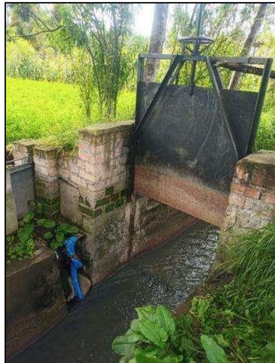
Imagen 16: Compuerta tipo gusano en buen estado.
