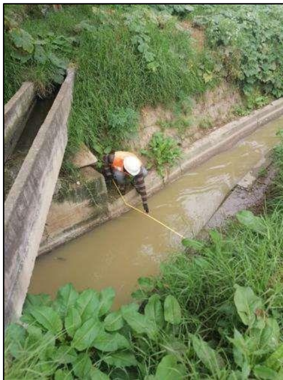
Imagen 24: Realizando mediciones en el estanque disipador Obteniendo datos geométricos del estanque disipador.
