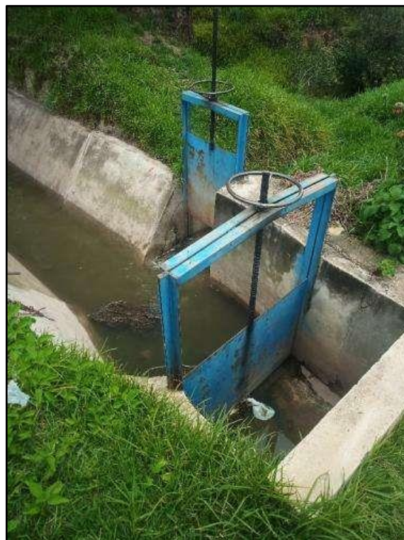
Imagen 72: Compuertas tipo tarjeta en buen estado. Se muestra dos compuertas de hierro tipo tarjeta; la cual controla el curso del agua en buen estado.
