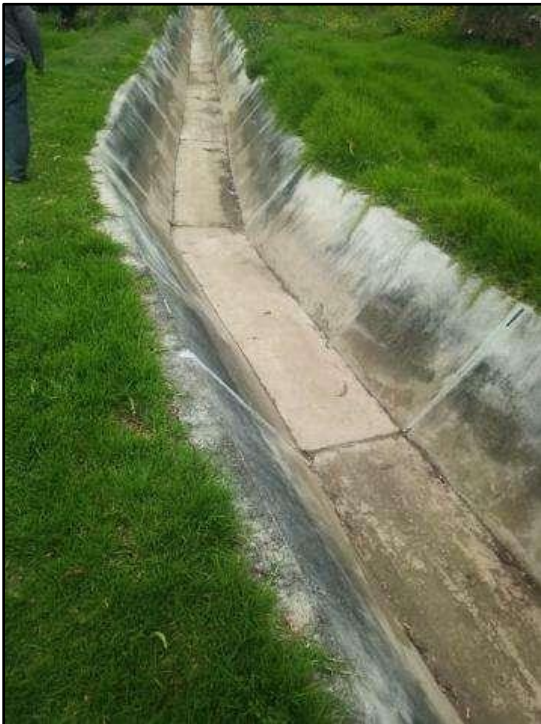
Imagen 38: Tramos finales del canal.
