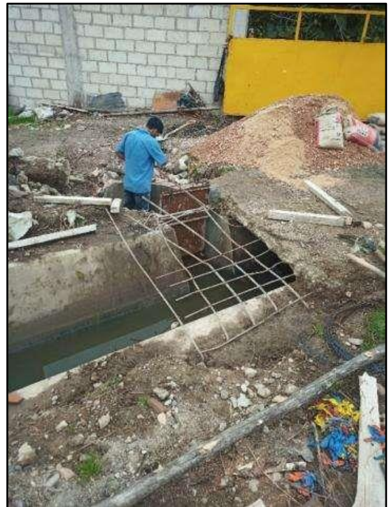
Imagen 32: Construyendo un pase vehicular.
