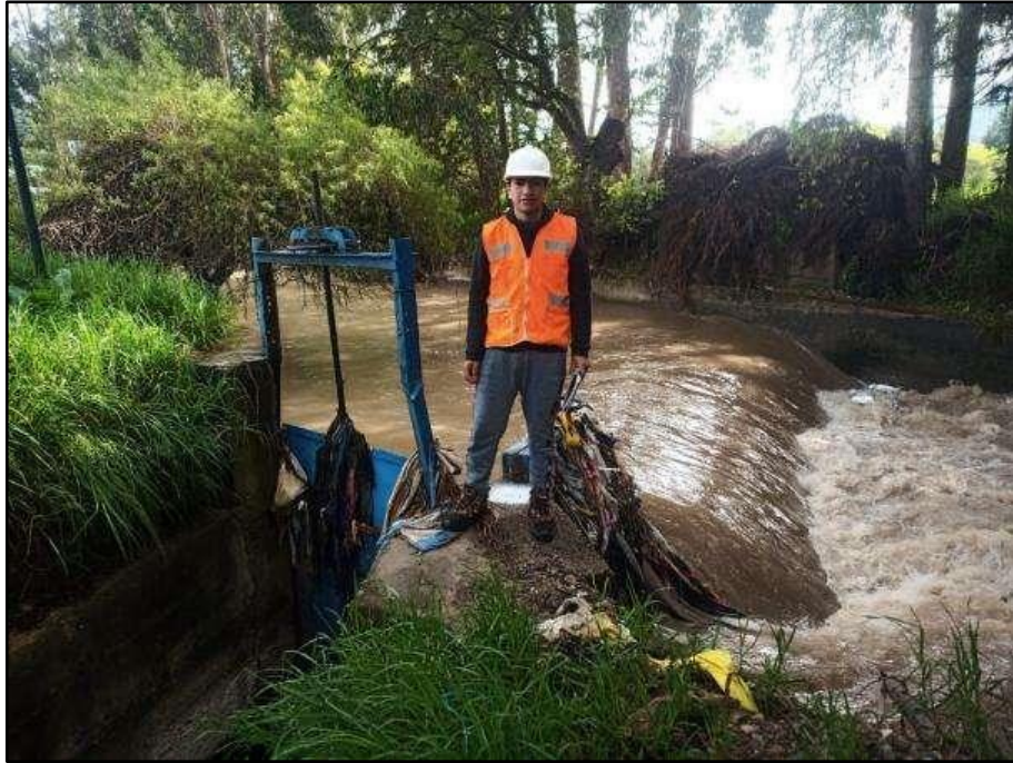
Imagen 16: Bocatoma del canal la Collpa (Máximas avenidas) Se muestra la bocatoma del canal la collpa, en épocas de máximas avenidas del cauce del rio Mashcón.
