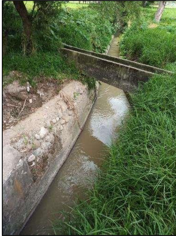
Imagen 23: Estanque disipador en épocas de estiaje El estanque disipador se encuentra posterior a la bocatoma, en condiciones regulares.
