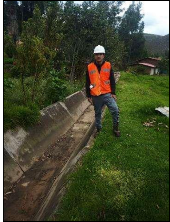
Imagen 37: Tramos finales del canal.
