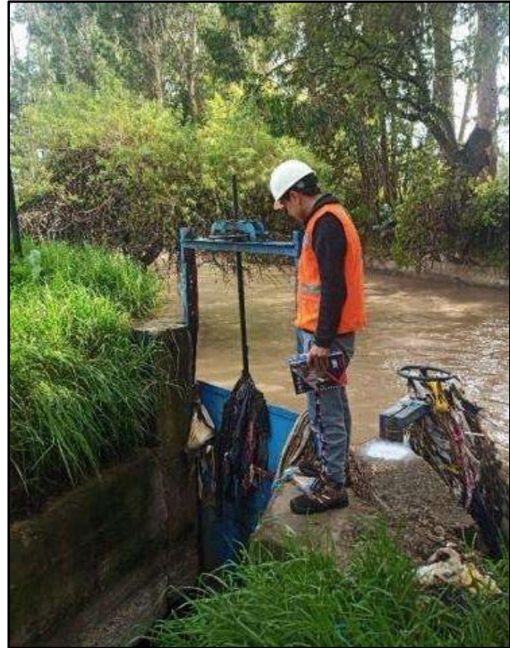
Imagen 05: Inspección de bocatoma del canal la Collpa.
