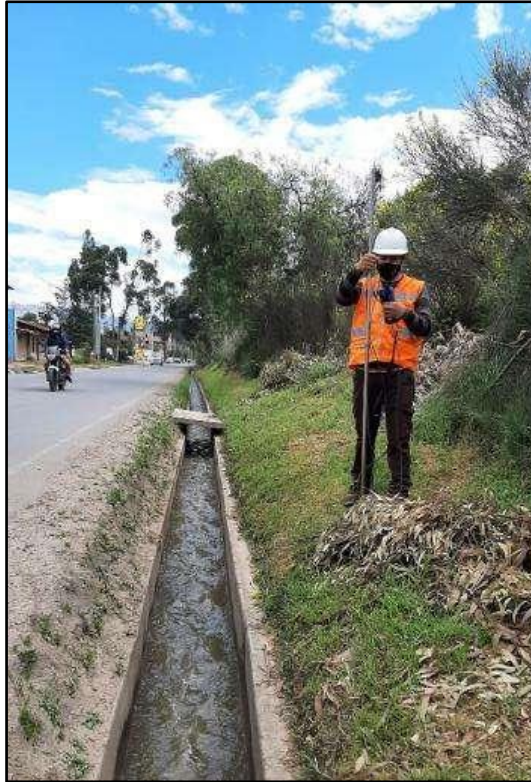
Imagen 82: Se observa el tipo de flujo turbulento. Se observa un tipo de flujo turbulento en parte del canal.
