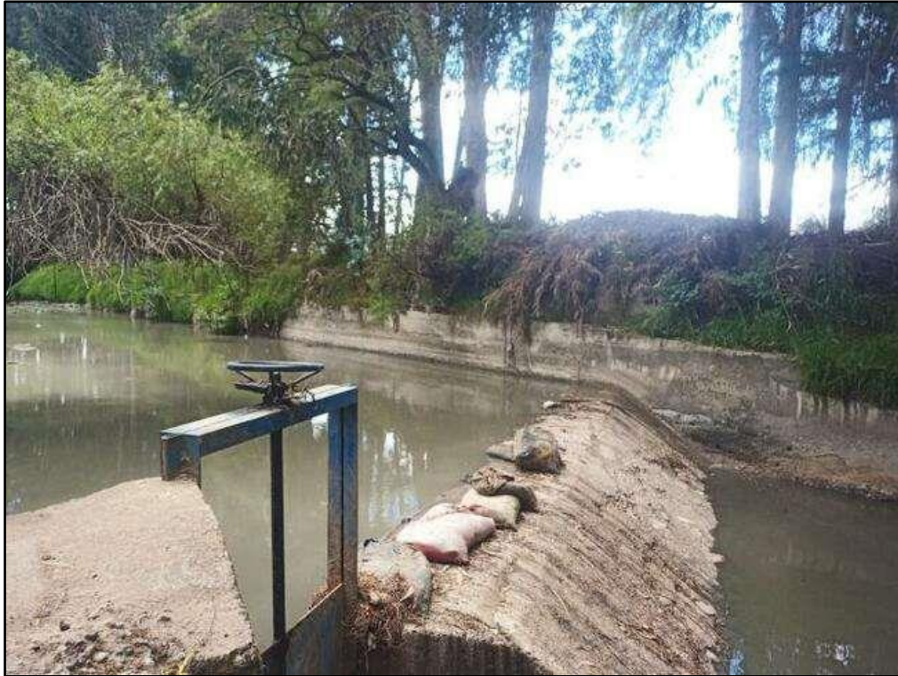
Imagen 07: Retiro de costales de arena para medir el caudal y la velocidad de ingreso en la bocatoma.
