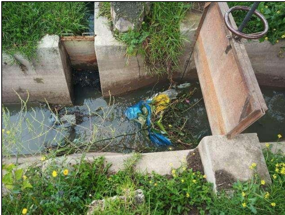
Imagen 28: Canal de derivación principal con presencias de basura, yerbas y lodo.
