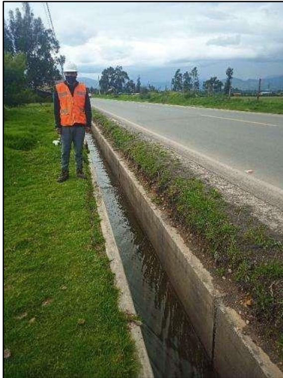
Imagen 68: Borde libre en sección rectangular. Se muestra el borde libre del canal lateral de primer orden N° 01.
