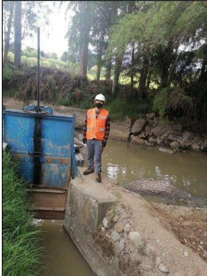
Imagen 17: Bocatoma del canal la Collpa (Épocas de estiaje) Se muestra una imagen de la bocatoma del canal en épocas de estiaje.
