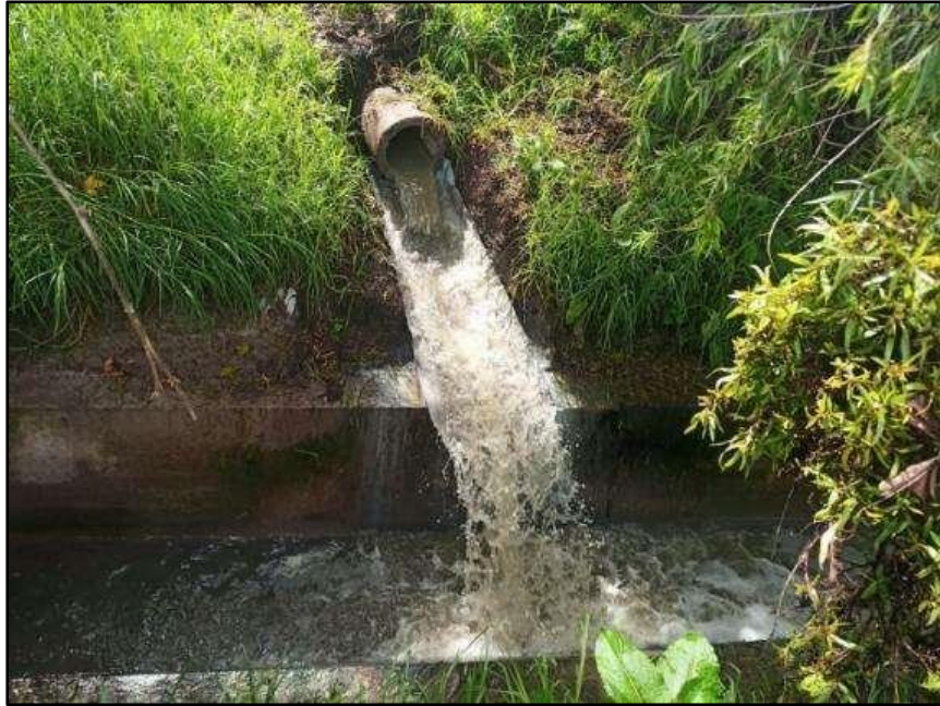
Imagen 34: Ingreso de aguas residuales de la PTAR al canal de riego la Collpa El canal de riego es abastecido por las aguas residuales de la PTAR de la ciudad e Cajamarca.
