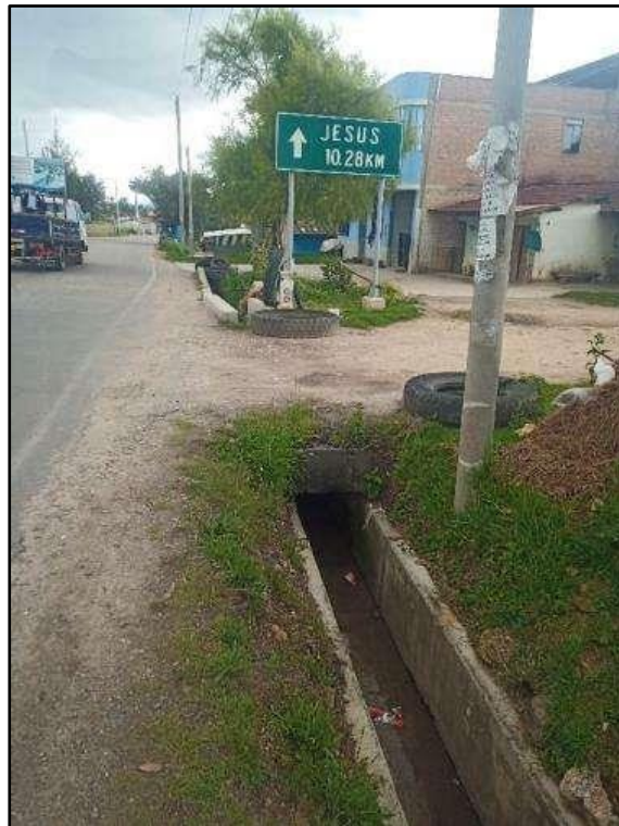
Imagen 73: Alcantarilla en el canal la Collpa.
