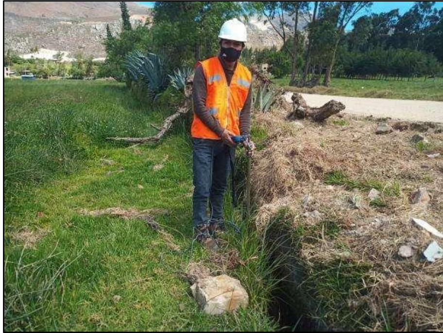
Imagen 60: Final del canal lateral sin revestir.
