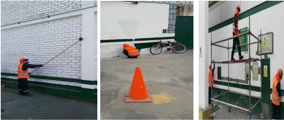
Figura 4: Limpieza, lijado de muros y desmontaje de señaléticas Fuente: Empresa
