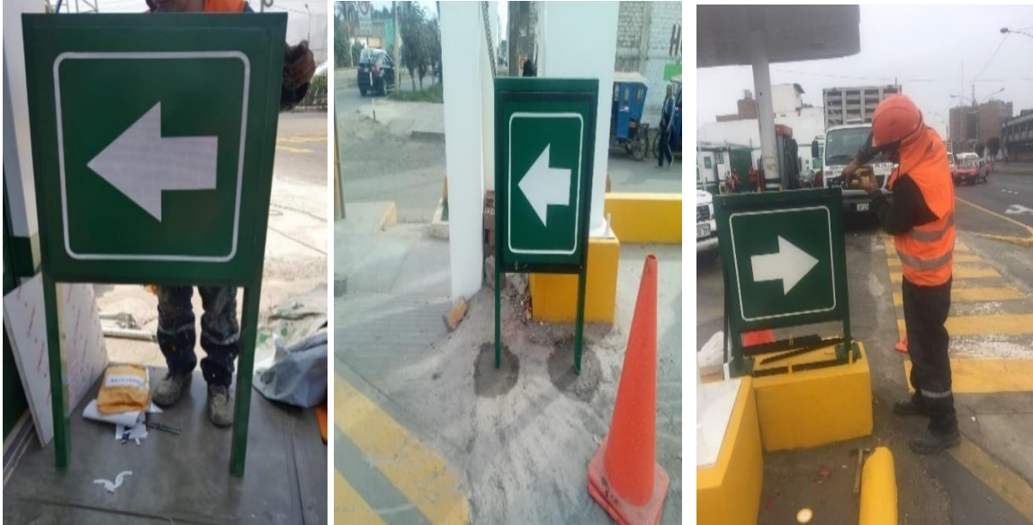
Figura 16: Desmontaje, mantenimiento e instalación de flecha reflectiva
