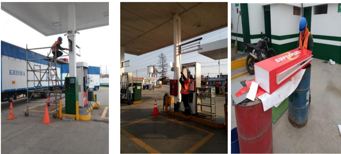
Figura 18: Desmontaje y mantenimiento de Banderolas Luminosas Fuente: Empresa
