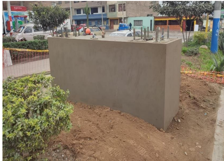
Figura 23: Vaciado, encofrado y desencofrado final de cimentación de Tótém Fuente: Empresa
