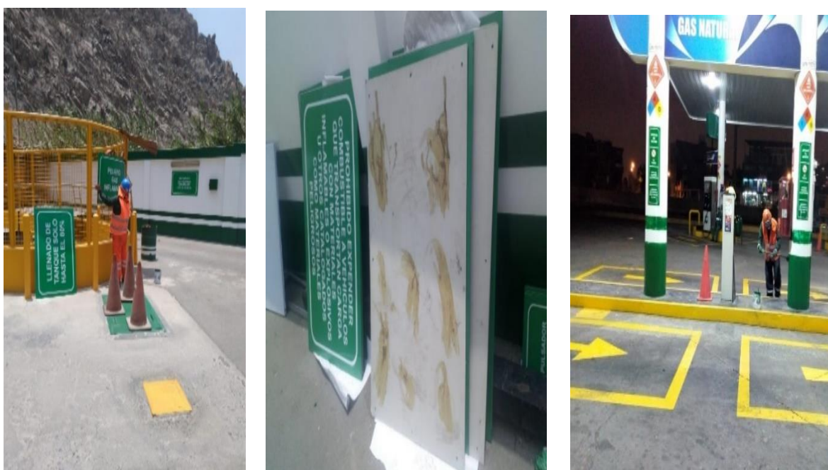
Figura 15: Desmontaje y Mantenimiento de Señaléticas y Prohibitivos Fuente: Empresa
