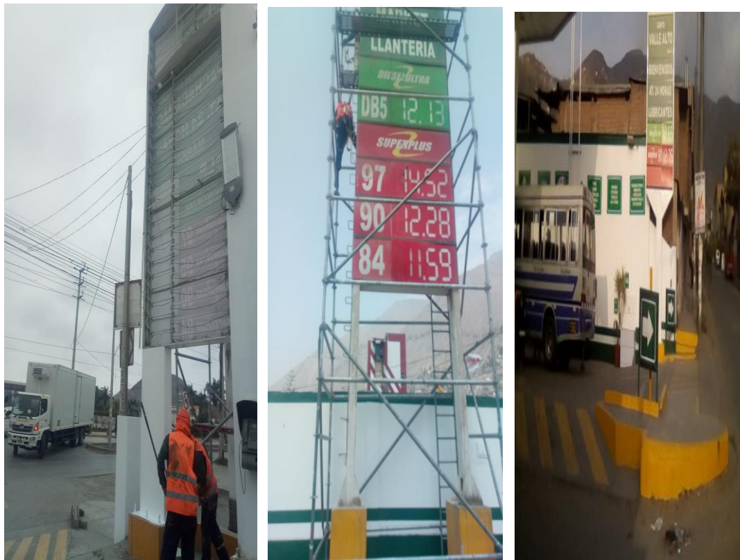
Figura 20: Desmontaje y Mantenimiento de Tótems Fuente: Empresa
