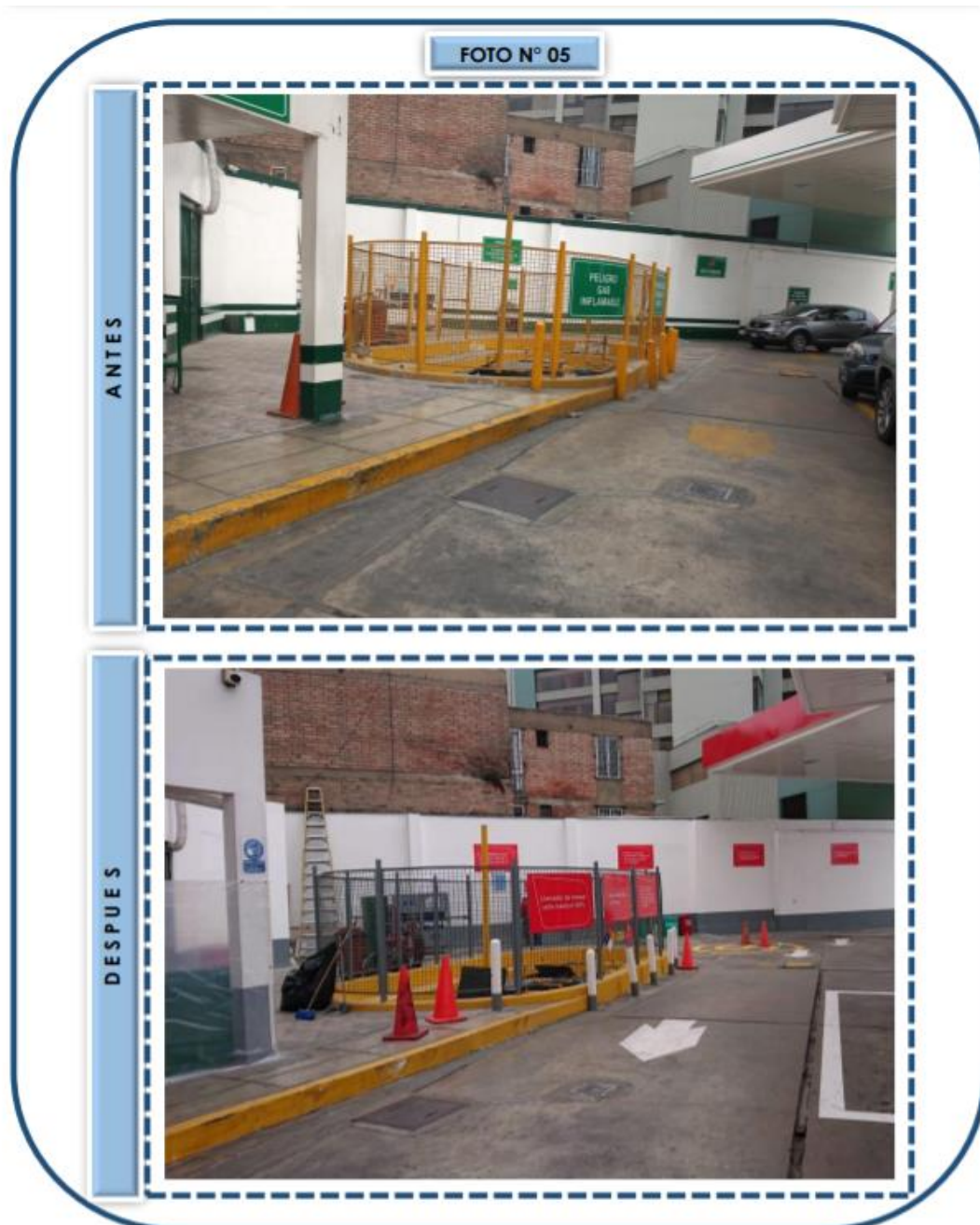
Figura 35: Antes y después de los trabajos de pintura realizados en el bunker de Glp o Gnv
