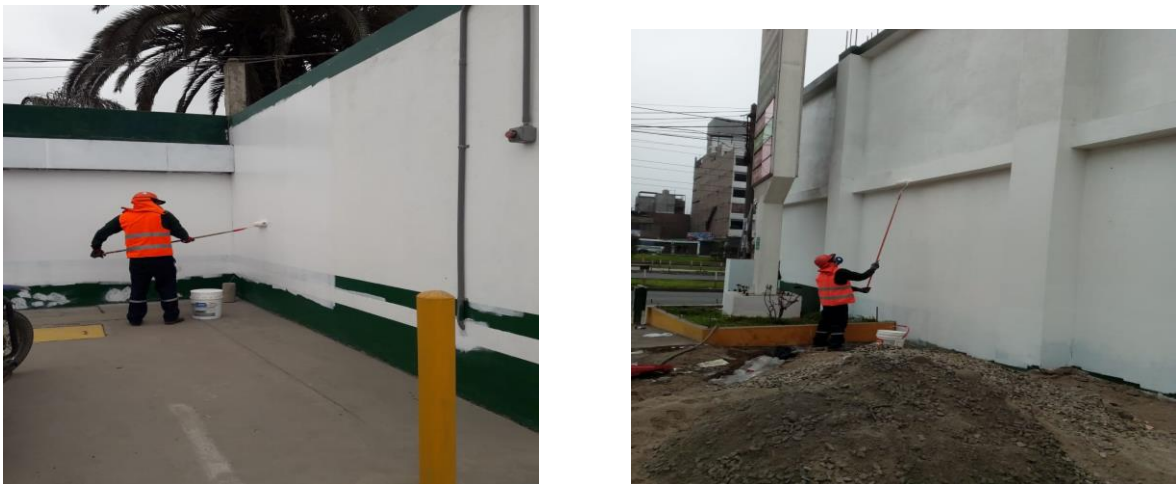
Figura 5: Pintado de muros Fuente: Empresa
