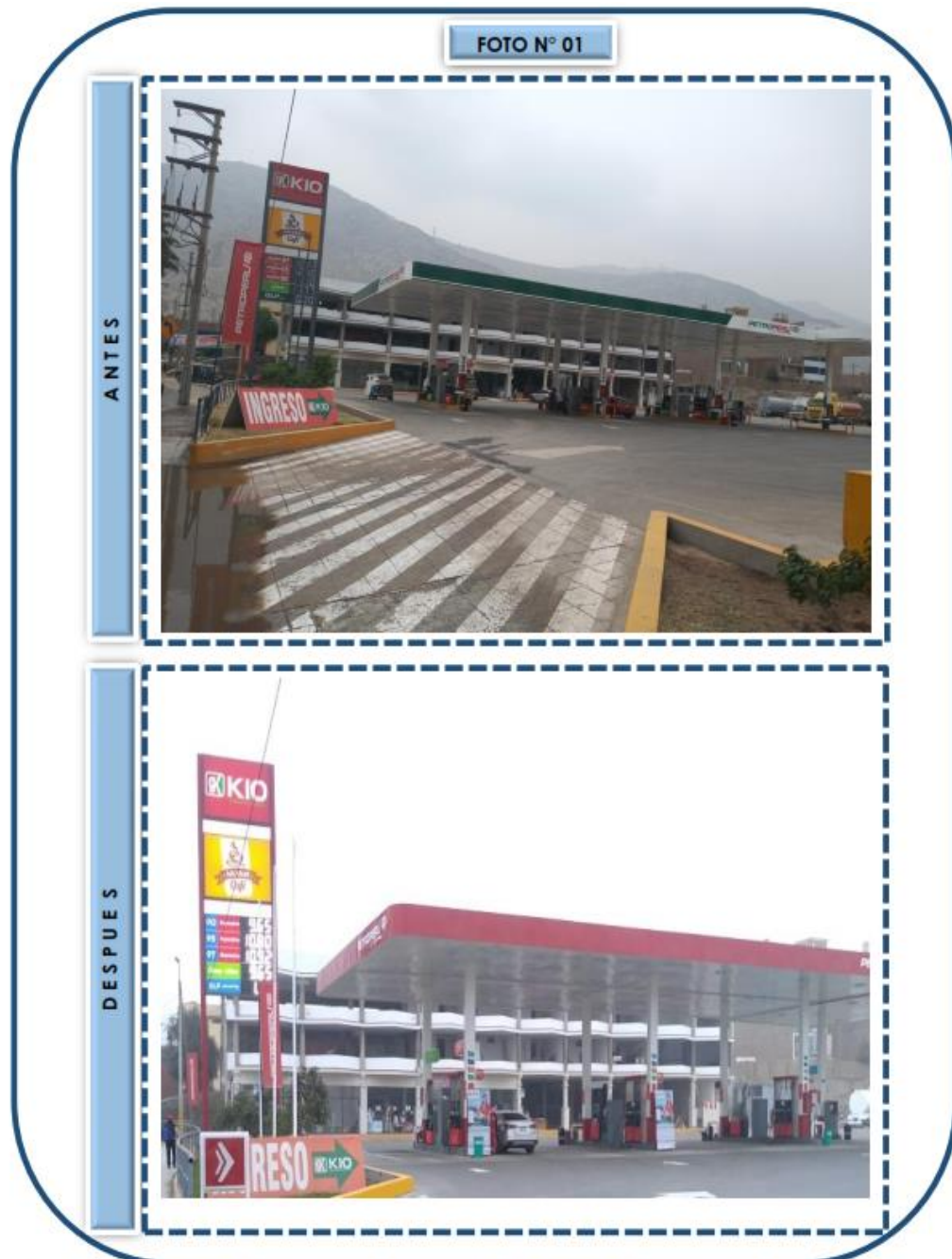
Figura 31: Antes y después de los trabajos generales realizados en una estación de servicio
