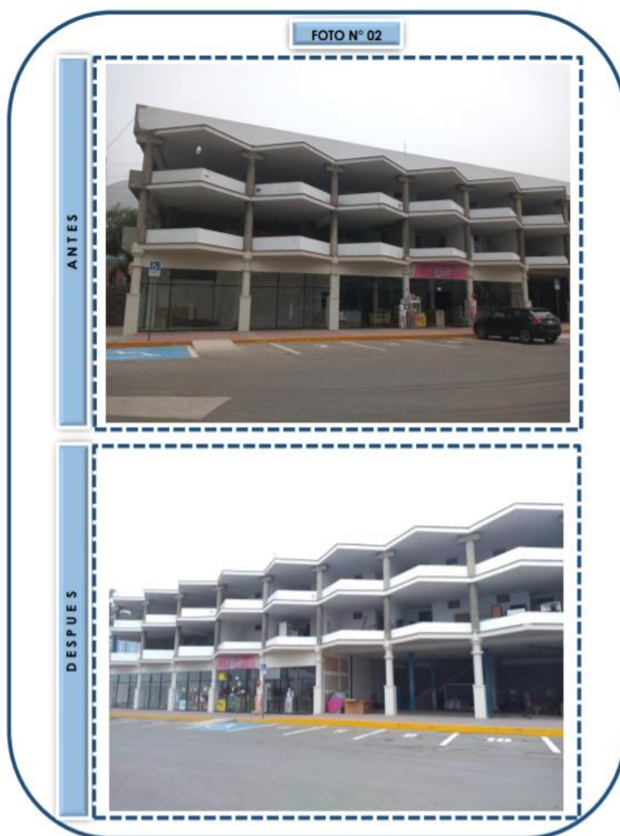
Figura 32: Antes y después de los trabajos de pintura realizados en edificio de oficina y market
