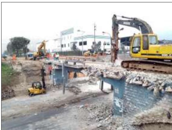
Foto 7. Demolición de Puente Echeandía
