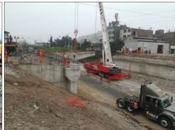
Foto 8. Montaje de vigas en Puente Echeandía
