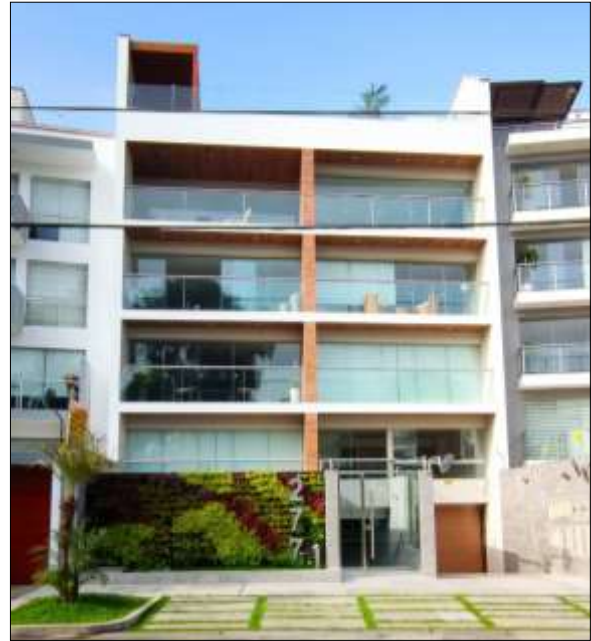
Foto 6. Edificio Monte Umbroso culminado
