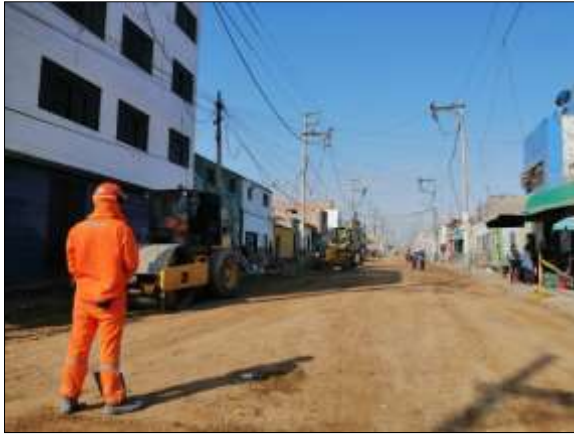
Foto 9. Conformación de base granular
