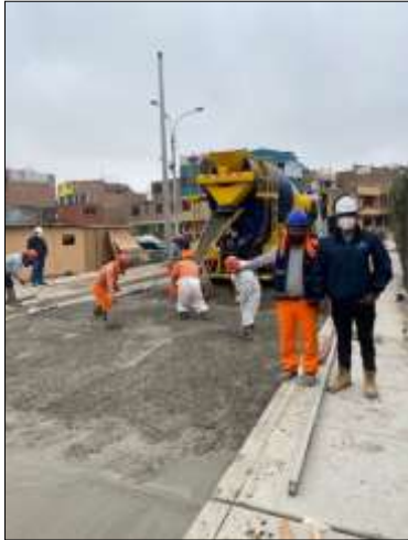
Foto 1. Vaciado de Pista
