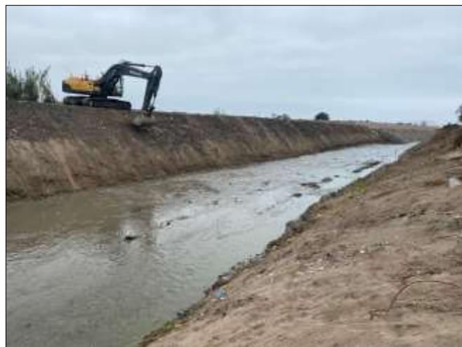
Foto 4. Conformación de talud en Río Lurín
