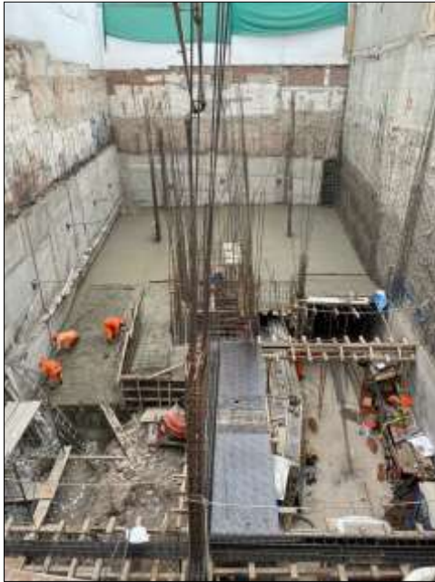
Foto 5. Vaciado de sótanos
