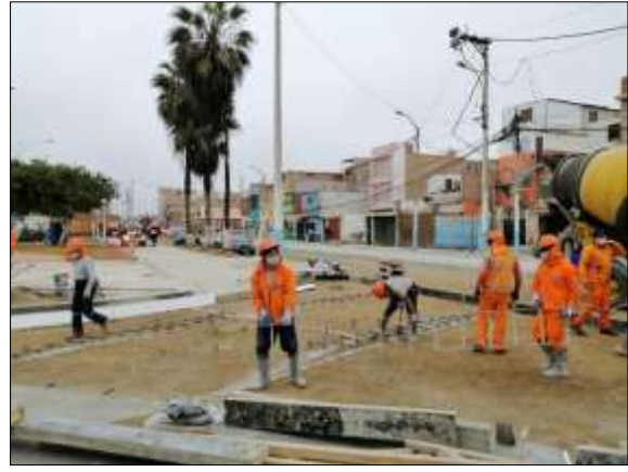
Foto 10. Colocación de Dowells para vaciado de pista
