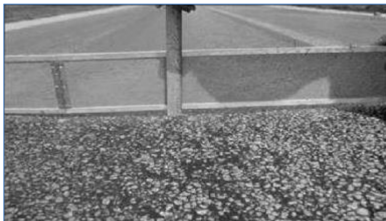
Figura 79. Ahuellamiento – mediana severidad Fuente: Norma Técnica ASTM D6433-03 (2004)
