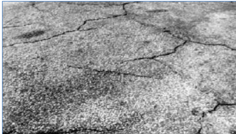
Figura 69. Abultamientos y hundimientos – baja severidad Fuente: Norma Técnica ASTM D6433-03 (2004)
