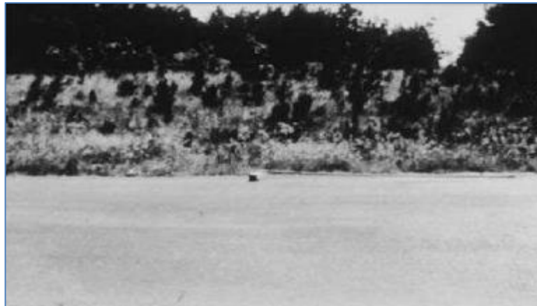
Figura 84. Hinchamiento – El nivel de severidad depende del criterio de la calidad de tránsito Fuente: Norma Técnica ASTM D6433-03 (2004)
