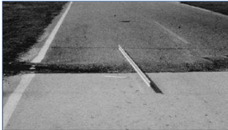
Figura 83. Desplazamiento – alta severidad Fuente: Norma Técnica ASTM D6433-03 (2004)
