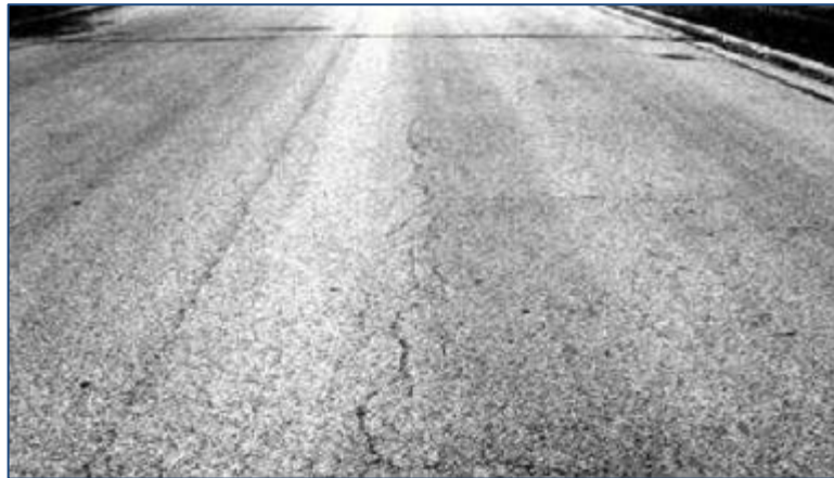
Figura 51. Piel de cocodrilo – baja severidad Fuente: Norma Técnica ASTM D6433-03 (2004)
