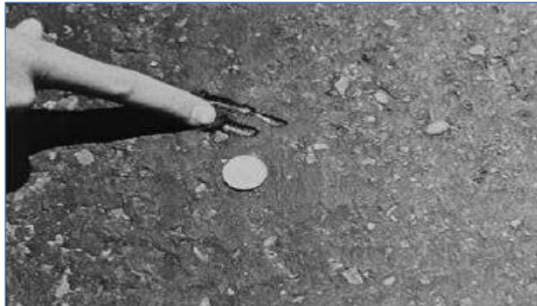
Figura 95. Exudación – mediana severidad Fuente: Norma Técnica ASTM D6433-03 (2004)
