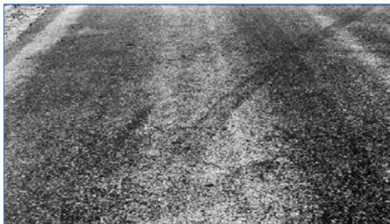
Figura 94. Exudación – baja severidad
