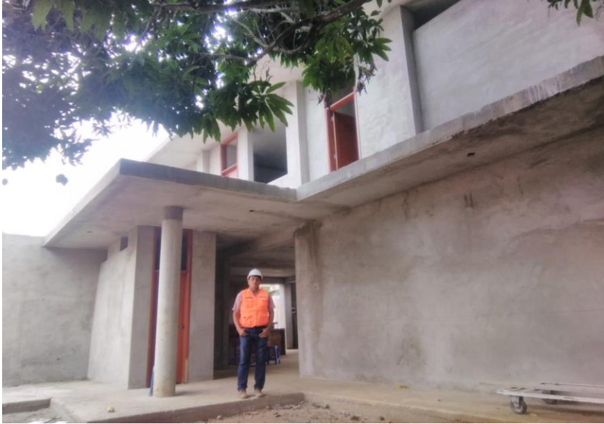
Figura 17. Casco de la obra concluida
