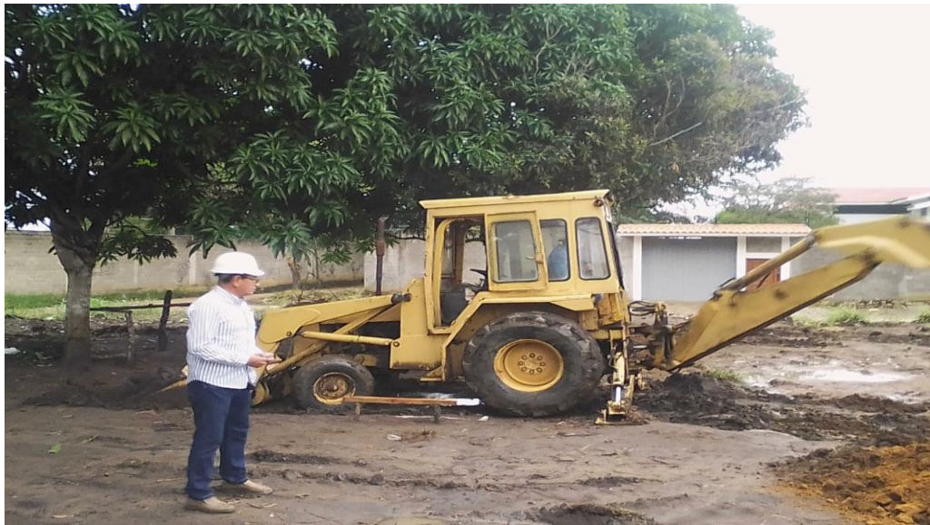
Figura 4. Excavaciones y nivelado de terreno
