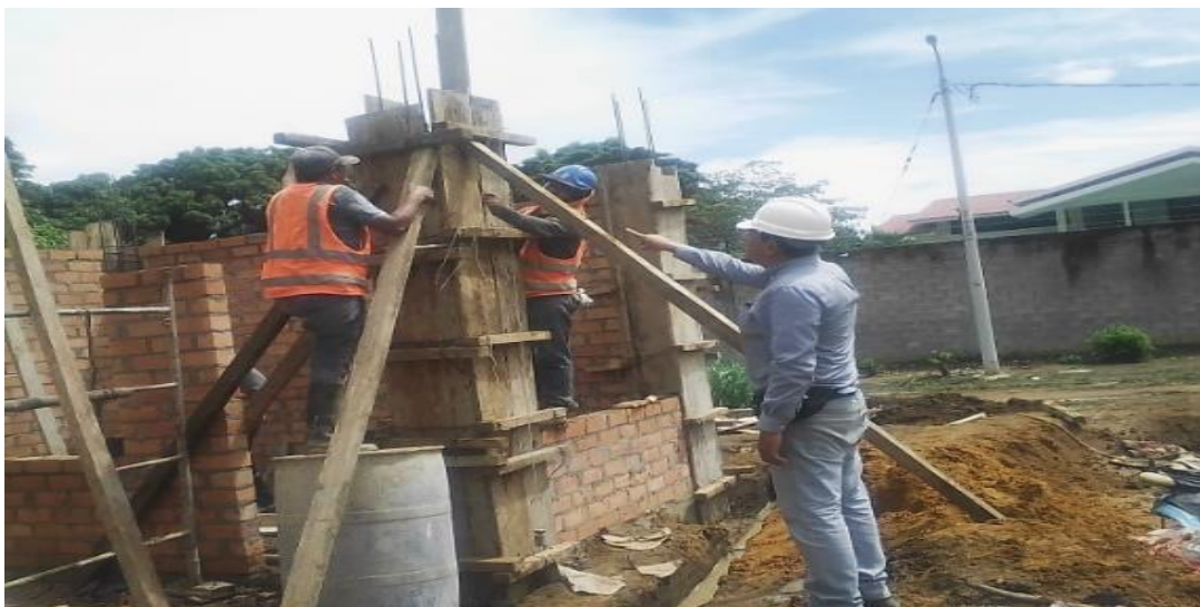
Figura 9. Encofrado, vaciado y desencofrado de columnas
