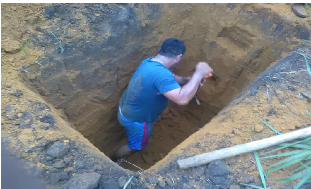
Figura 3. Excavación de calicata de 3m. de profundidad para extraer muestra del suelo y determinar su capacidad portante
