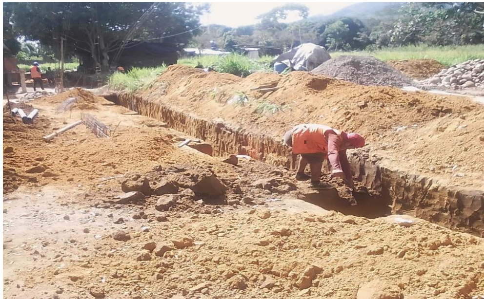
Figura 7. Excavación y perfilamiento de zanjas para cimientos
