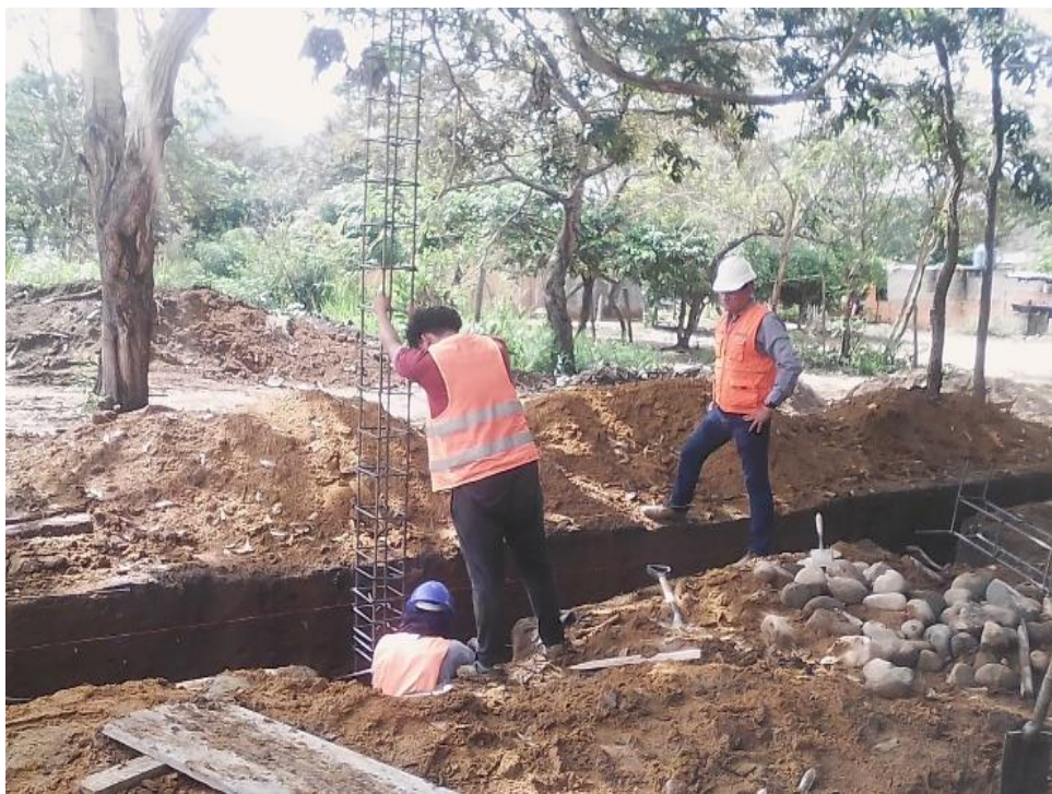
Figura 8. Colocación de armaduras de columnas previo al encofrado
