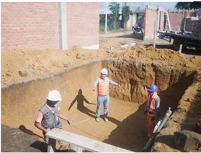
Figura 12. Construcción y acabado de piscina
