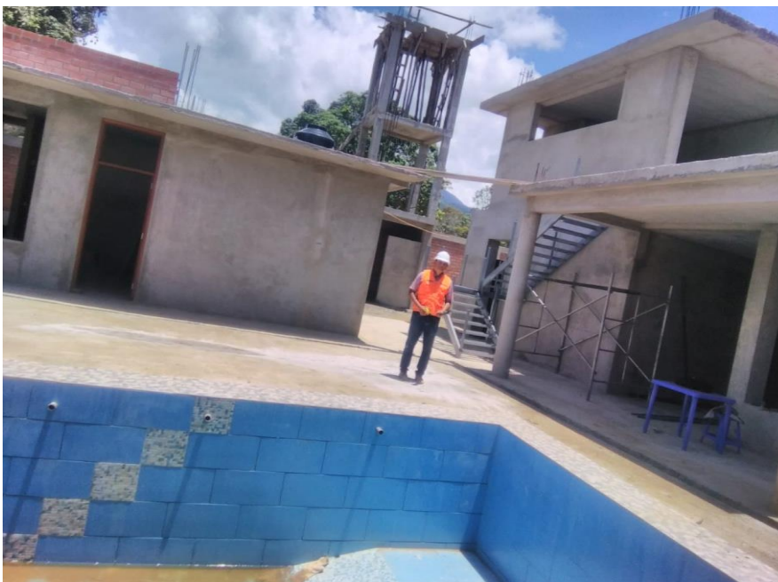
Figura 18. Piscina enchapada y torre para el tanque elevado.
