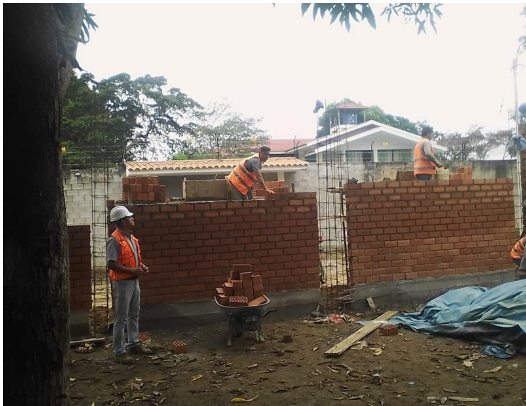
Figura 10. Ejecución de muros de cerco perimétrico.
