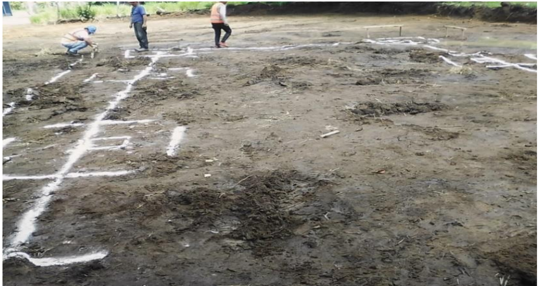
Figura 5. Trazo y replanteo
