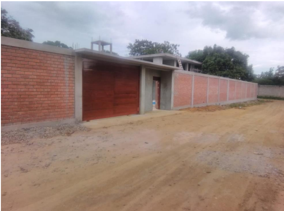
Figura 16. Muro perimetral y puertas de acceso al predio
